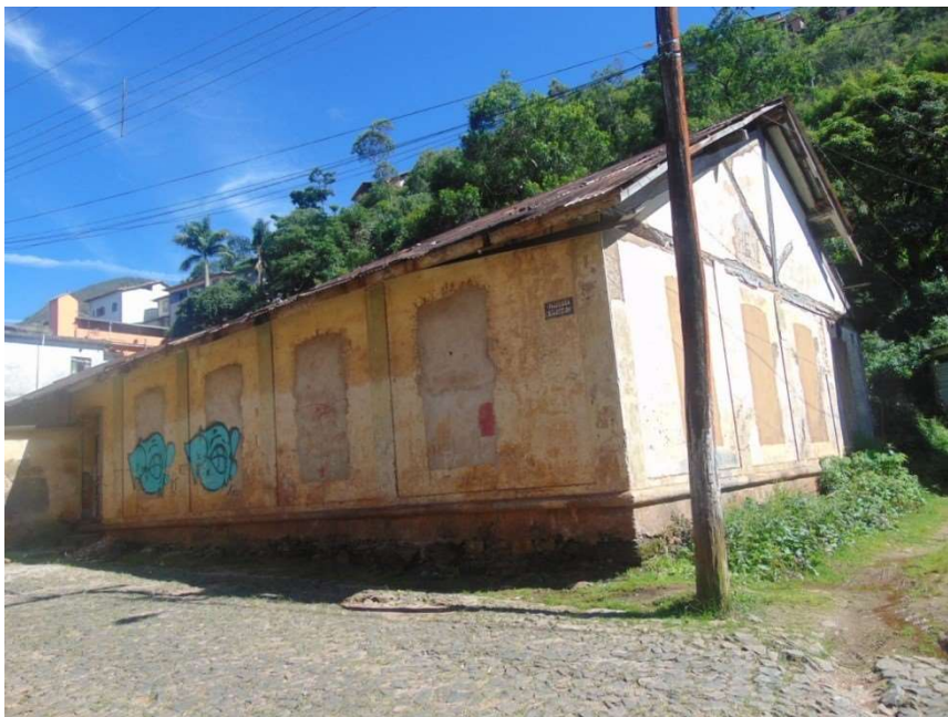
Figura 6- Vista parcial da fachada frontal do Reservatório III
