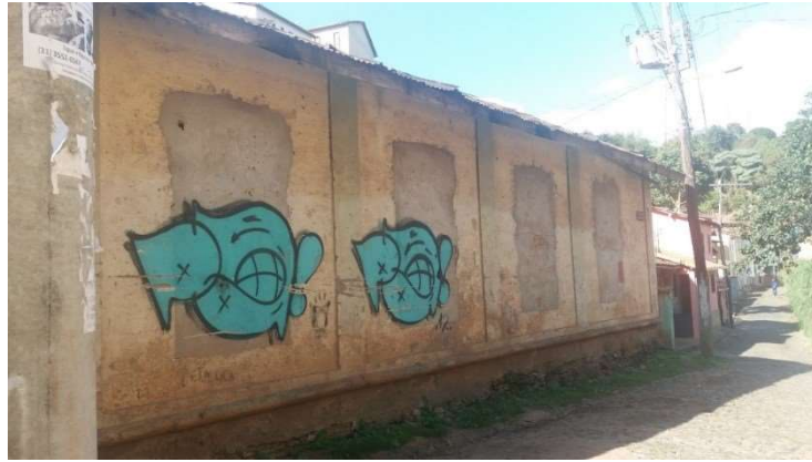
Figura 29- Antigas janelas concretadas
