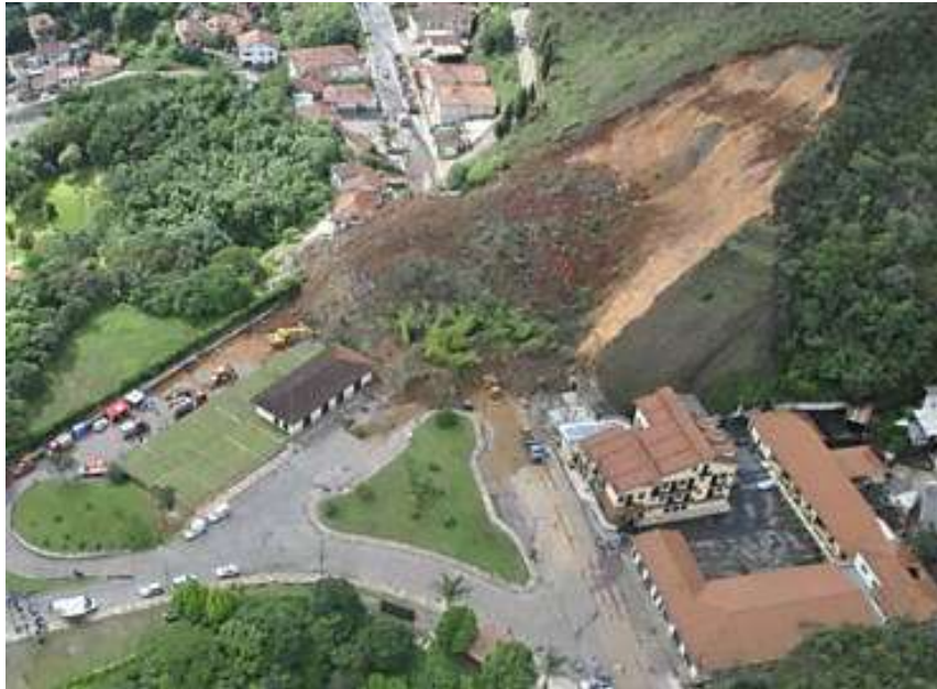
Figura 16 - Prédio da rodoviária atingido por deslizamento em 2012, vista aérea
