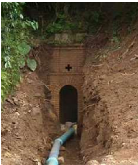
Figura 8- Vista frontal da mina
