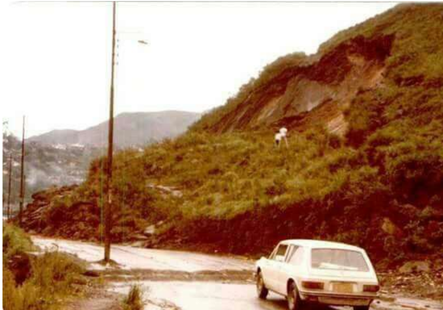
Figura 12- Vista do deslizamento em 1979 na rua Padre Rolim
