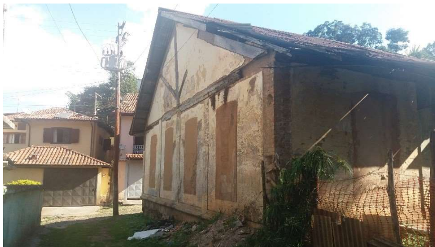
Figura 5 - Vista parcial da fachada do reservatório na rua Francisco Lopes
