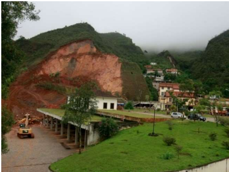
Figura 15- Prédio da rodoviária atingido por deslizamento em 2012
