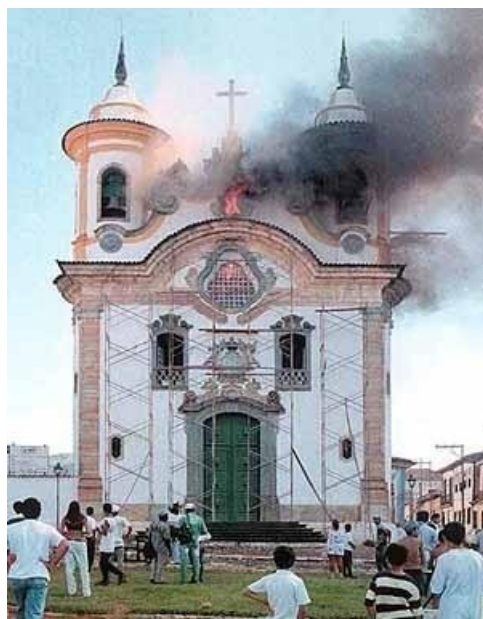
Figura 12 - Vista do incêndio pela fachada da Igreja de Nossa Senhora do Carmo.
