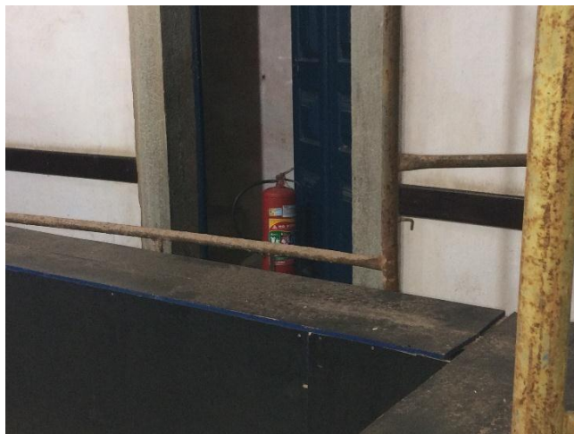
Figura 38 - Extintor obstruído.
