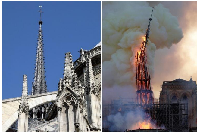
Figura 16 - Antes e depois: Danos causados pelo incêndio na agulha principal.
