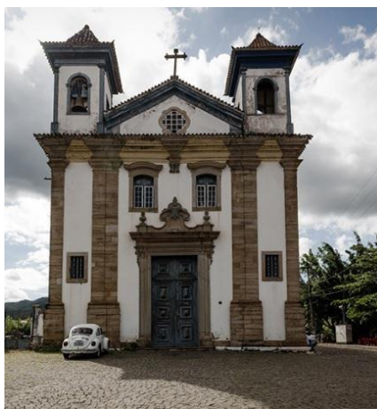
Figura 19 – Fachada principal Igreja do Rosário
