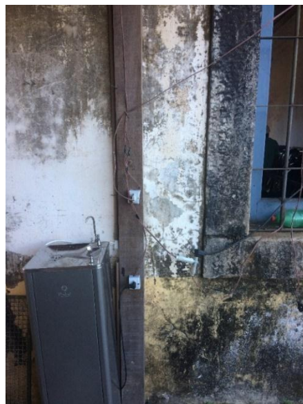
Figura 33 - Fontes de energia elétrica próximas ao bebedouro.
