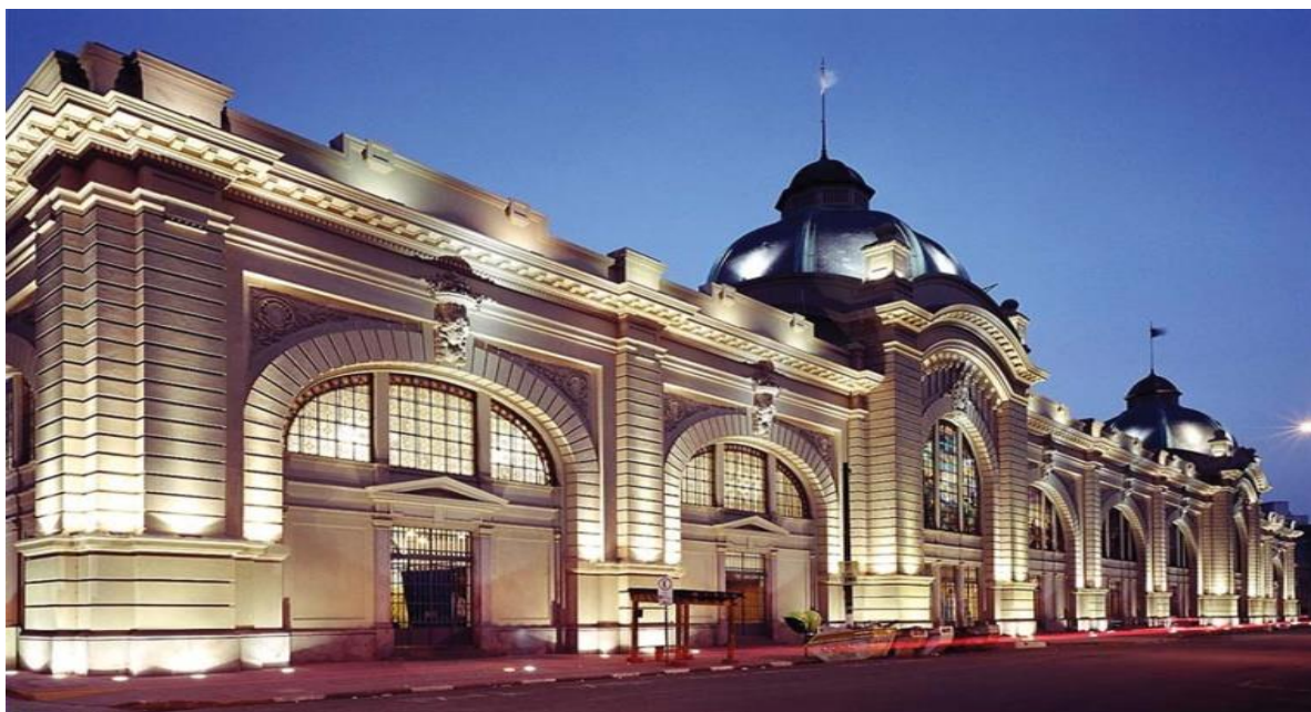
Figura 8 – Fachada Do Mercado Municipal De São Paulo
