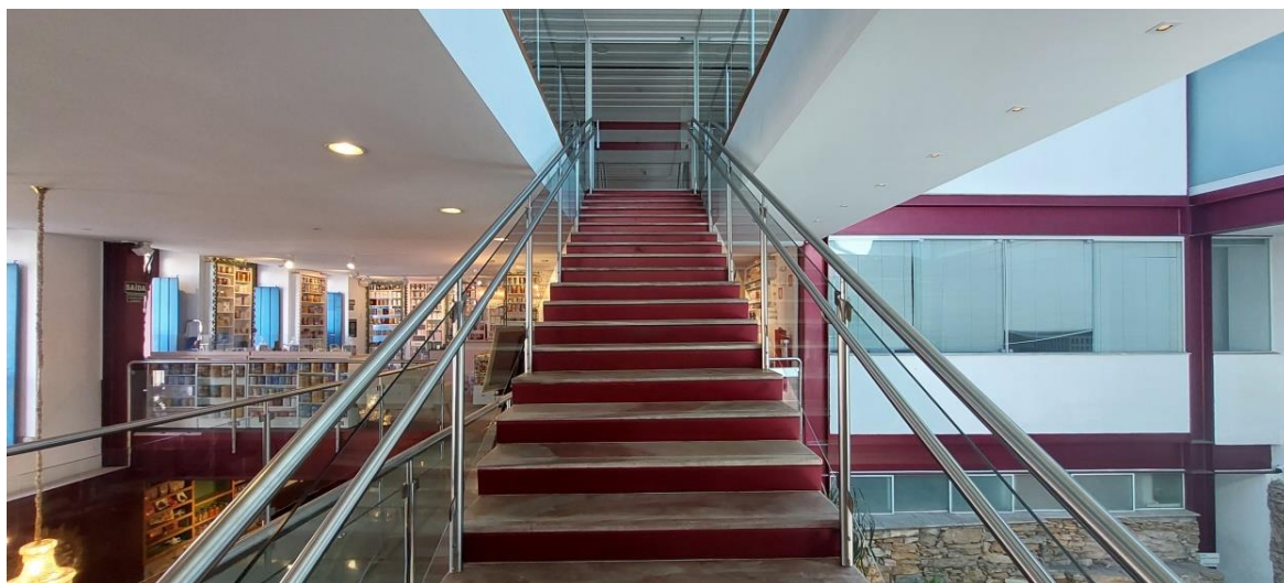
Figura 39 - Escada em estrutura de aço Fonte: Jonny Wederson Rosa 04/09/2022
