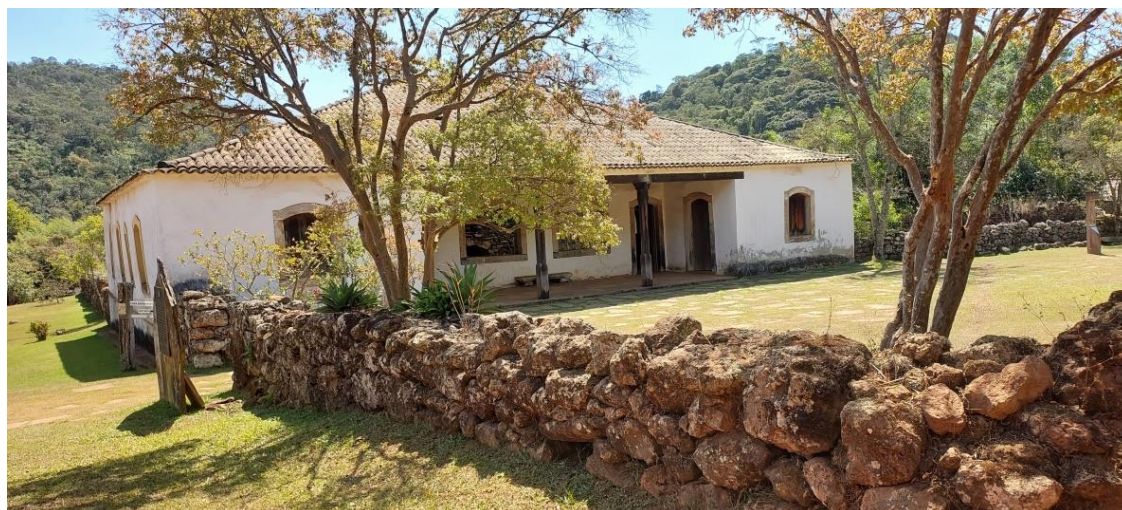
Figura 3 – Parte dos muros tombados da casa sede da antiga fazenda São João do Manso
