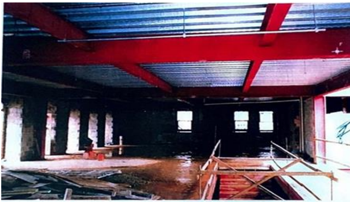
Figura 35 - Vista interna do 2º pavimento Fonte: Acervo IPHAN de Ouro Preto
