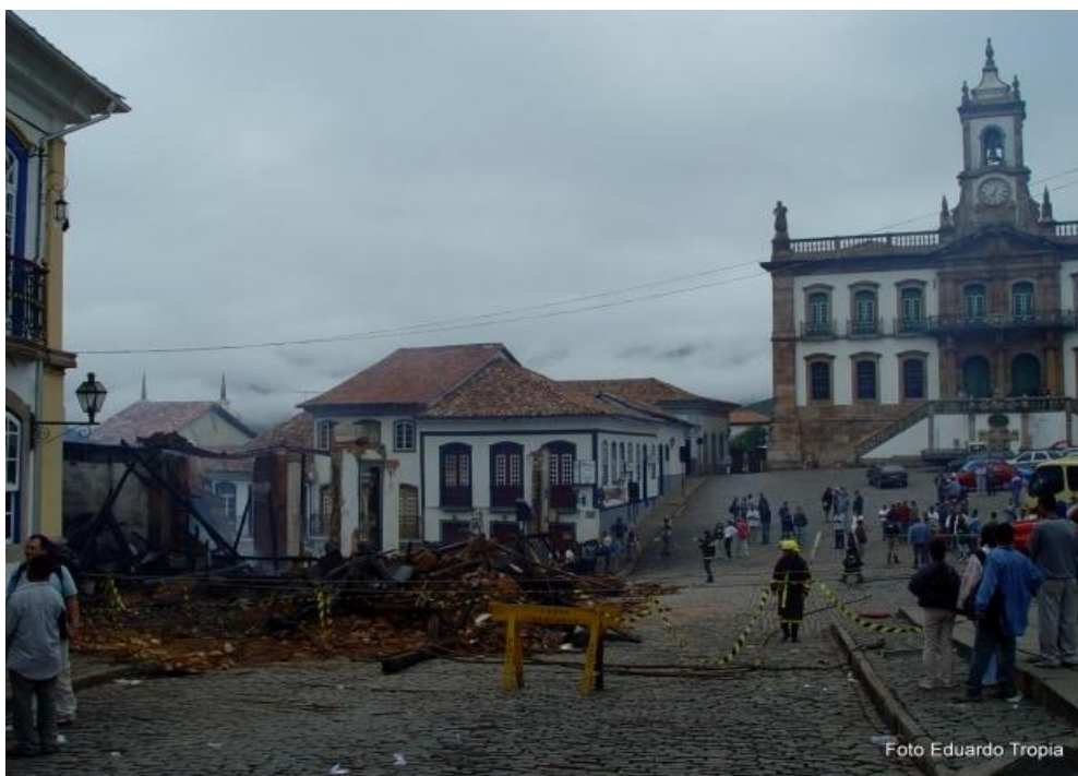
Figura 22 - incêndio no histórico casarão que abrigava o Hotel Pilão, Ouro Preto (MG), em 14.04.2003 Foto: Eduardo Tropia. Fonte: FIEMG - Parte I: História do incêndio do “Antigo Hotel Pilão” - ilumine o projeto. Acesso, 04/08/2022
