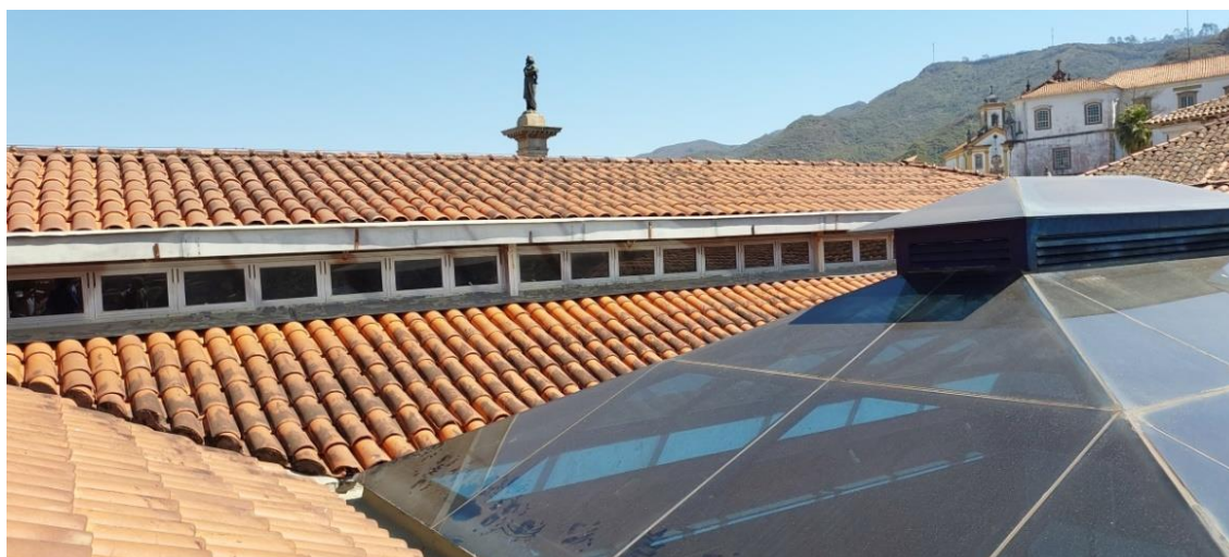
Figura 45 – Telhado de telhas de cerâmica Fonte: Jonny Wederson Rosa 04/09/2022
