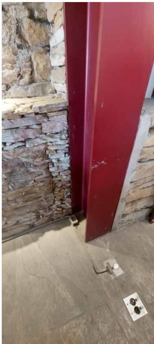
Figura 58 – Distingüibilidade entre as pedras antigas e as novas Fonte: Jonny Wederson Rosa 04/09/2022
