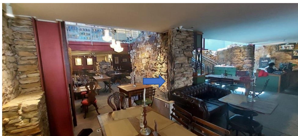
Figura 51 – Subsolo – Cafeteria – estrutura de madeira remanescente Fonte: Jonny Wederson Rosa 04/09/2022
