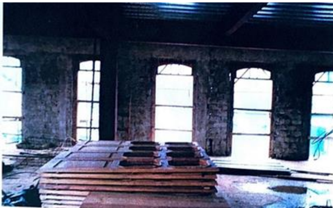
Figura 34 - Vista interna do 2º pavimento, Fonte: Acervo IPHAN de Ouro Preto
