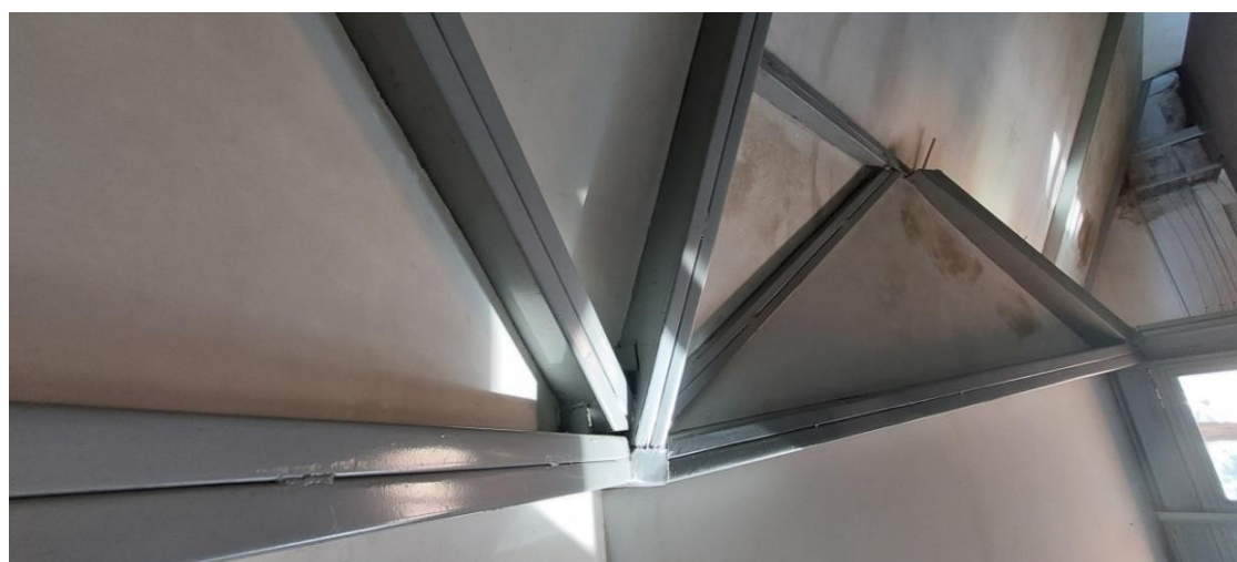
Figura 46 - Estrutura de treliças metálicas Fonte: Jonny Wederson Rosa 04/09/2022
