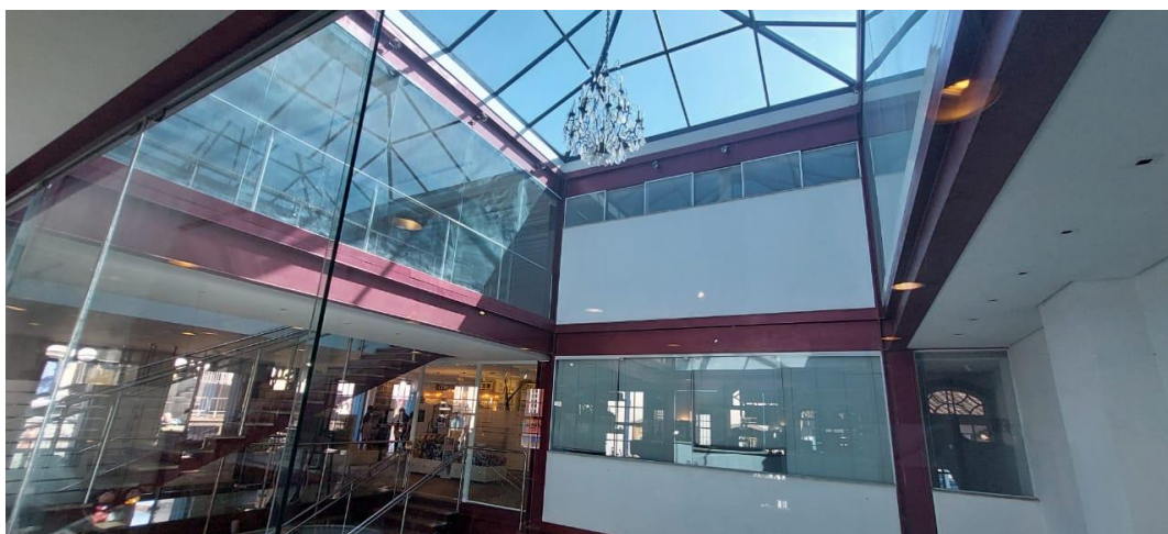
Figura 56 – Estrutura de aço Fonte: Jonny Wederson Rosa 04/09/2022
