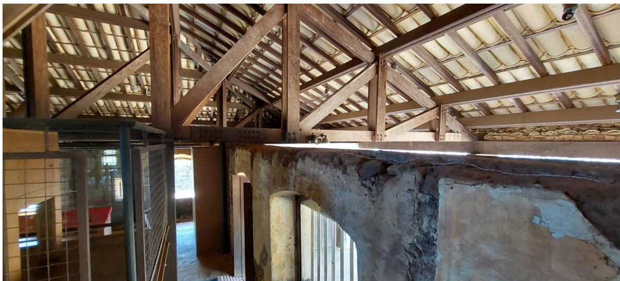
Figura 5 – A estrutura em aço e madeira não se apoiam nas paredes
