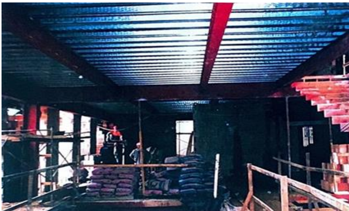
Figura 36 - Vista interna do 2º pavimento. Fonte: Acervo IPHAN de Ouro Preto
