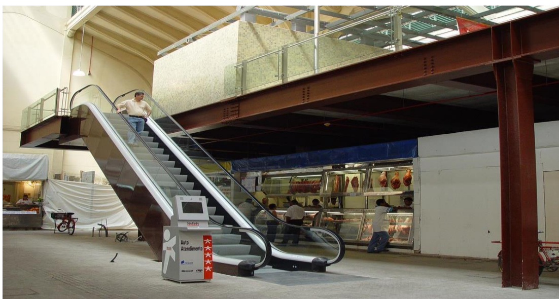
Figura – 10 Estrutura aparente de aço do Mercado Municipal De São Paulo
