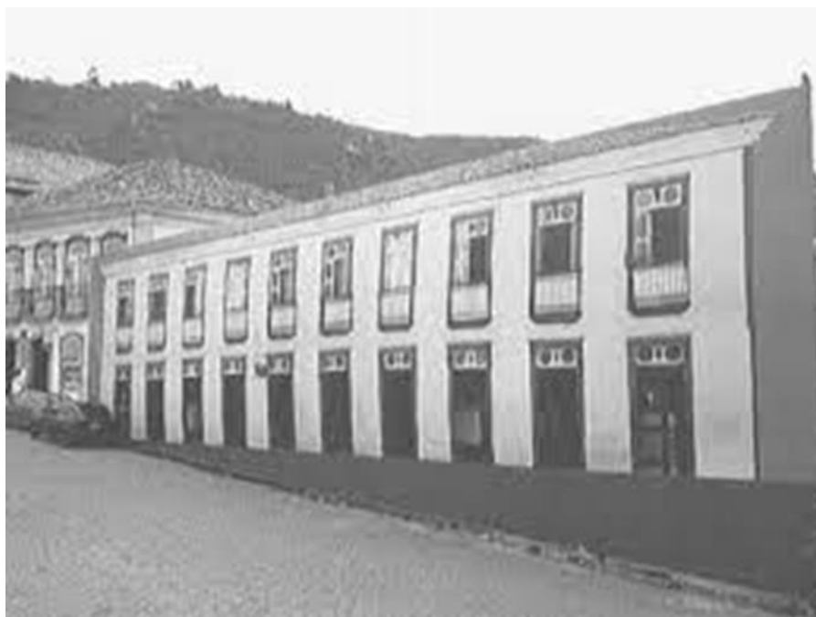
Figura 23 – Tapume com a fachada do edifício colocado onde havia o hotel. Fonte: Microsoft Word - Artigo Seminário Internacional com ajustes - Álvaro Costa (carneirocosta.com.br). Acesso 04/08/2022.
