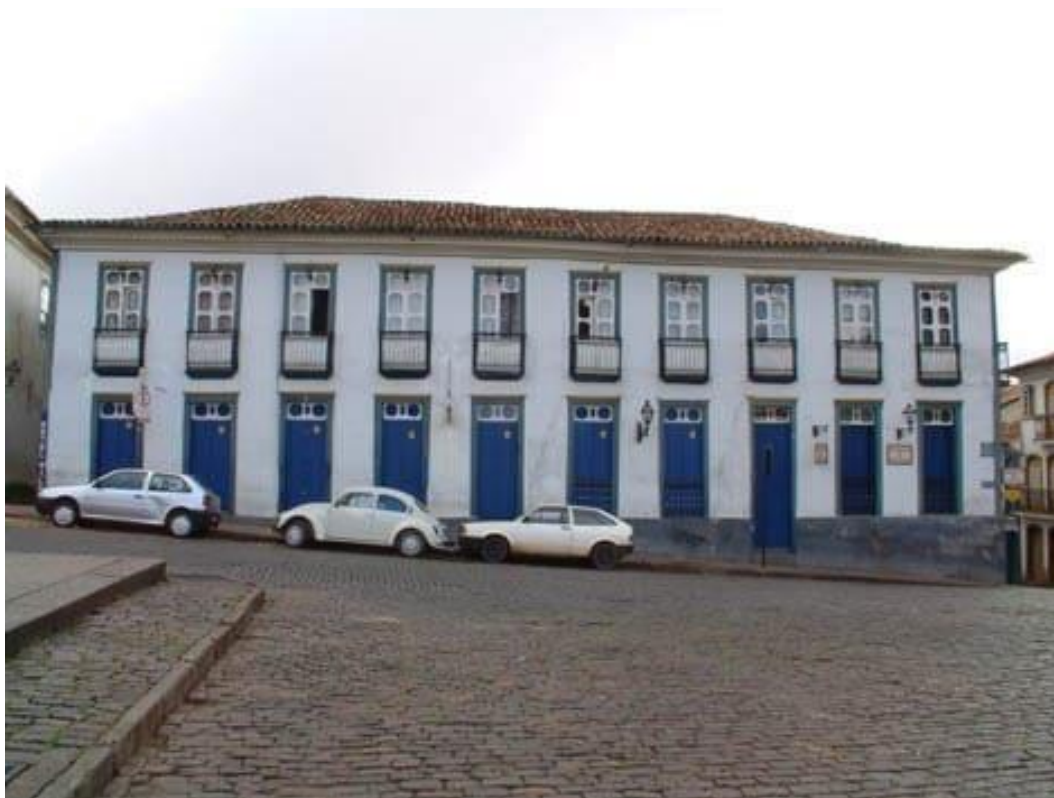
Figura 37 - Fachada principal do antigo Hotel Pilão antes do incêndio. Fonte: INBI-SU (Inventário Nacional de Sítios Urbanos e Bens Imóveis)
