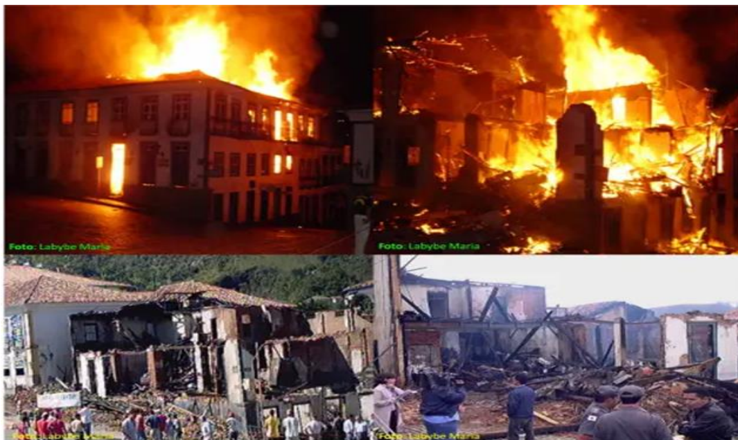
Figura 20– Incêndio no histórico casarão que abrigava o Hotel Pilão, Ouro Preto (MG), em 14.04.2003. Fotos: Labybe Maria. Fonte: Jornal O Liberal, 2003. Fonte: https://divulgacaotecnologica.wordpress.com/palestras/2-2/ . Acesso 04/08/2022
