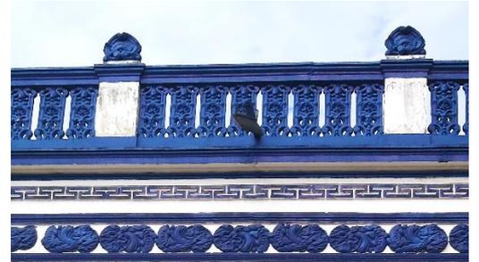
Detalhamento da platibanda
