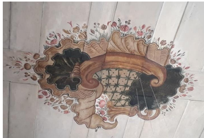
Figuras 21 e 22: Elementos decorativos do forro do Casarão de Pedra em Ouro Branco, MG.
