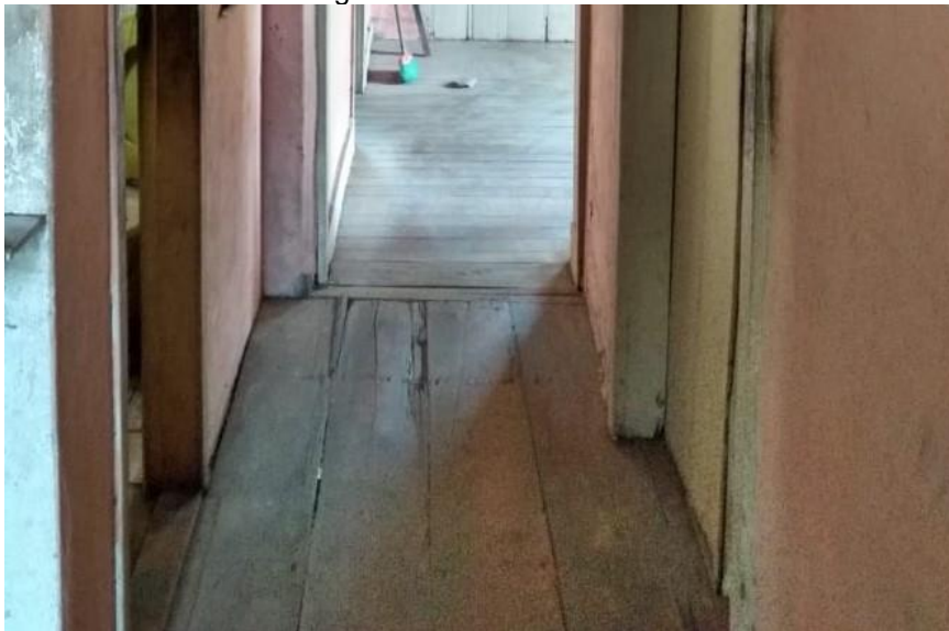
Figura 14 – Piso de tábua corrida
