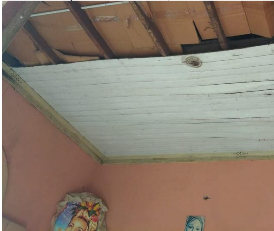
Figura 16 – Forro de madeira pinus na sala
