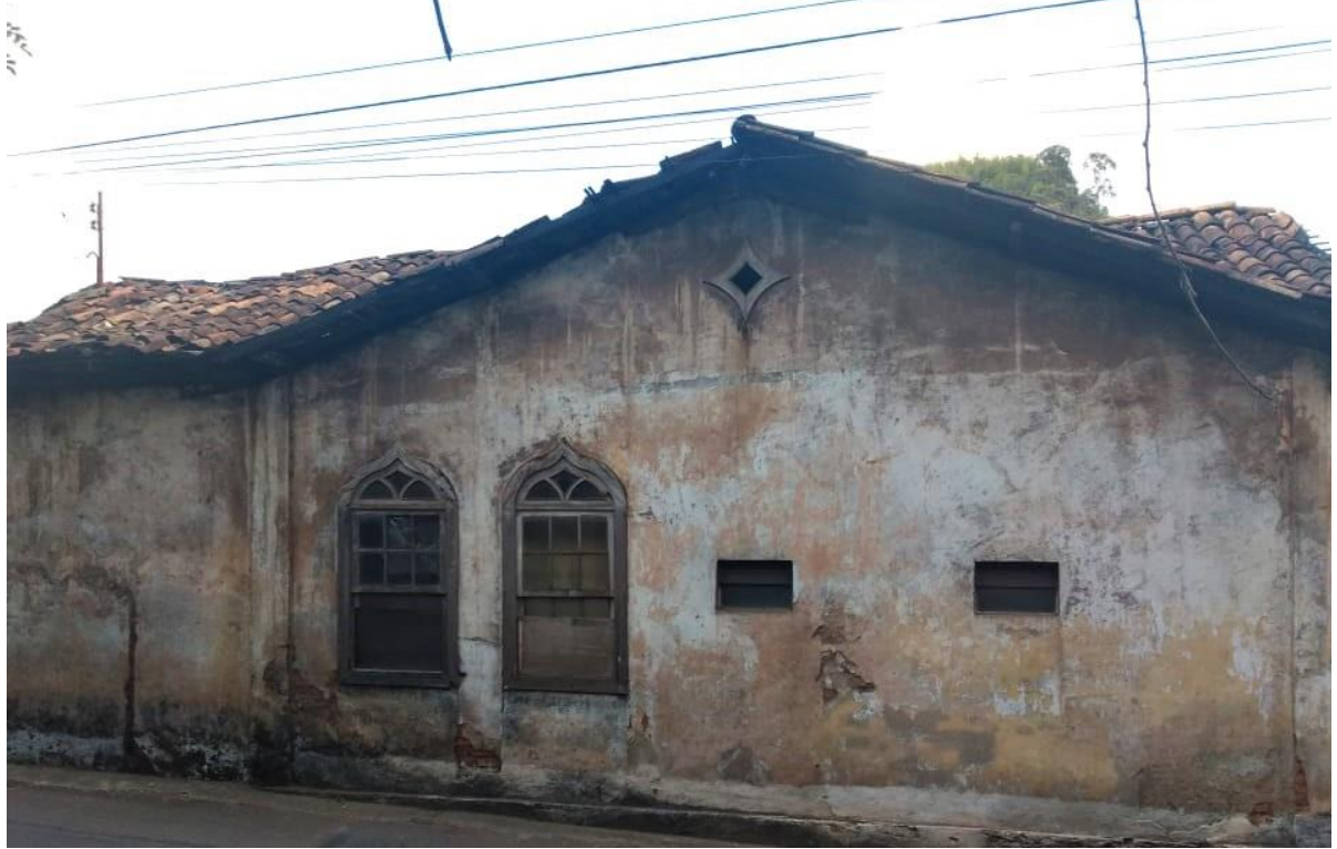
Figura 12 – Telhado de telhas cerâmicas
