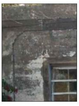
6: Perda da camada pictórica na fachada esquerda
