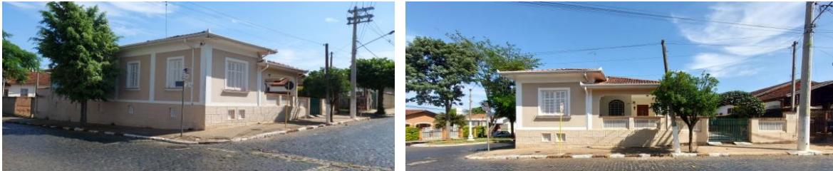
Figura 107 – Figura 108 - Casarão - Praça Barão de Mogi Guaçu, Nº 264 (Esquina com a Rua Luís Gama)
