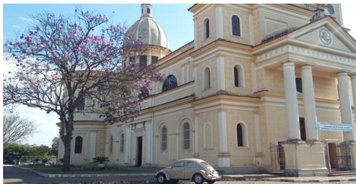
Figura 29–Fachada lateral da Igreja Matriz Nossa Senhora das Dores.
