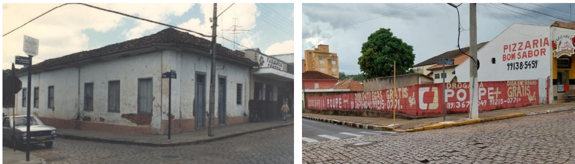
Figura 53 – Figura 54 - Residência da Família Feijão, antes de ser demolida. Atualmente um terreno vazio
