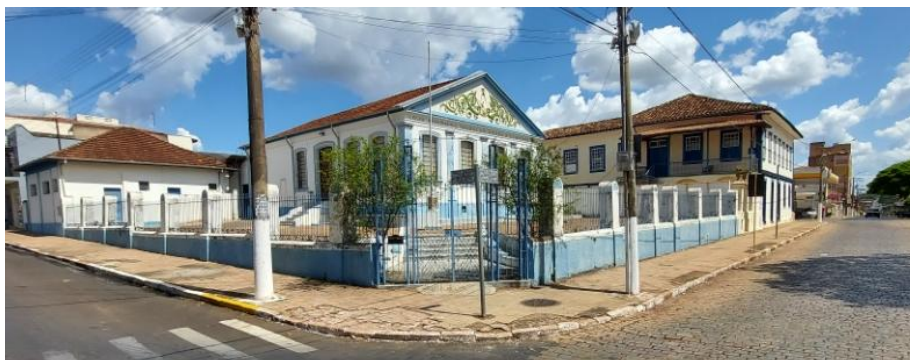
Figura 98 - Loja Maçônica – Rua Altino Arantes, Nº 943, esquina com a Praça Barão de Mogi Guaçu
