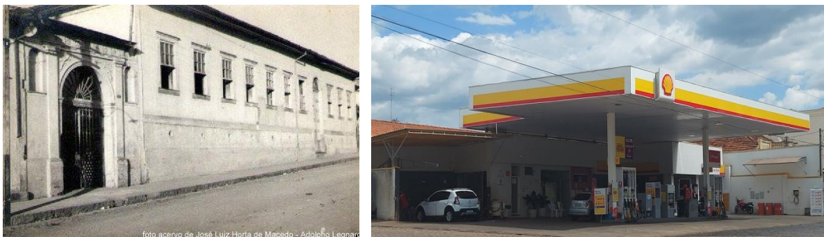
Figura 73 – Casarão que foi residência do Barão de Mogi Guaçu. Atualmente é o Posto Shell
