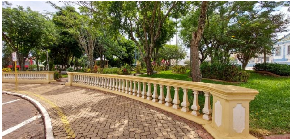
Figura 22 - Balaustrada da praça
