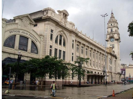
Figura 40 - Estação Júlio Prestes, São Paulo. Projeto de Cristiano Stockler das Neves
