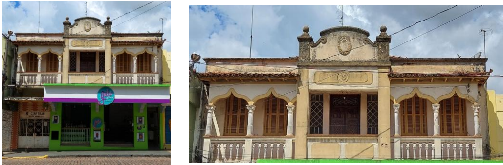
Figura 56 – Figura 57 - Piso inferior: Sorveteria e Ciretran e piso superior: antiga casa da Família Abbá
