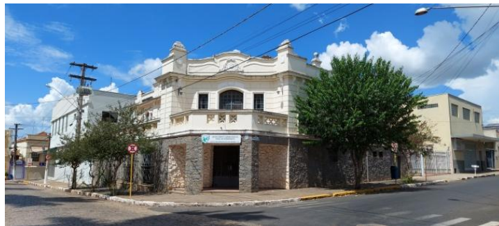
Figura 97 - Clube Casa Branca/Departamento Administrativo da Prefeitura, Nº 51 - Praça Barão de Mogi Guaçu, esquina com a Rua Altino Arantes
