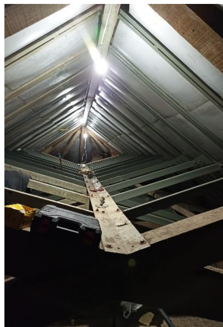
Figura 30 – Estrutura metálica parcialmente finalizada
