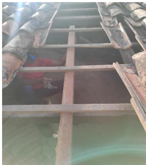
Figura 19 – Substituição de caibros
