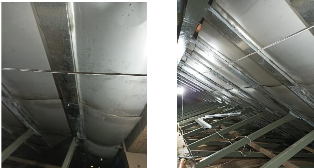
Figuras 31 e 32 – Instalação das calhas internas na estrutura metálica
