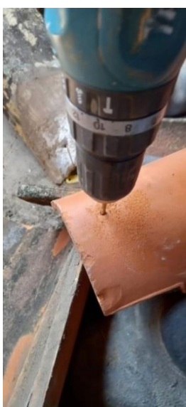
Figura 23 – Furação de telha nova para amarração
