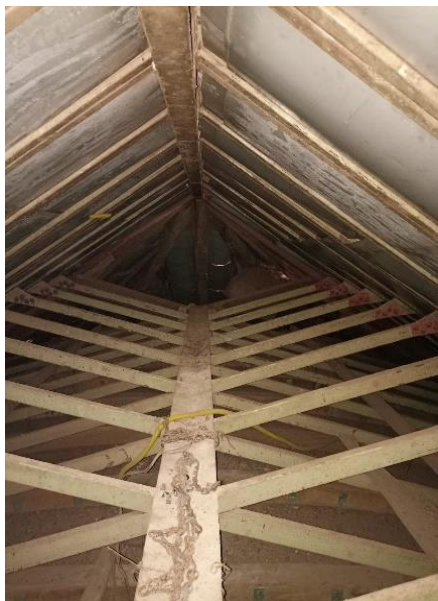
Figura 27 – Estrutura metálica antes do tratamento
