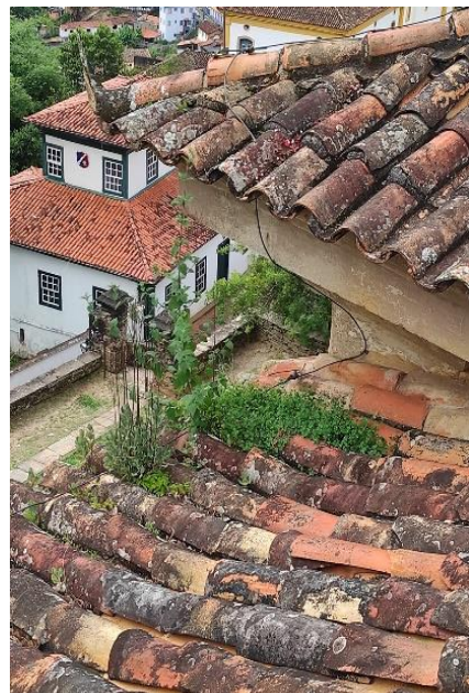
Figura 14 – Vegetação instalada no telhado da nave
