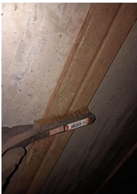
Figura 29 – Estrutura metálica durante o processo
