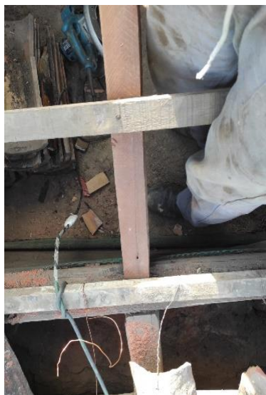
Figura 22 – Caibro da cobertura da nave substituído
