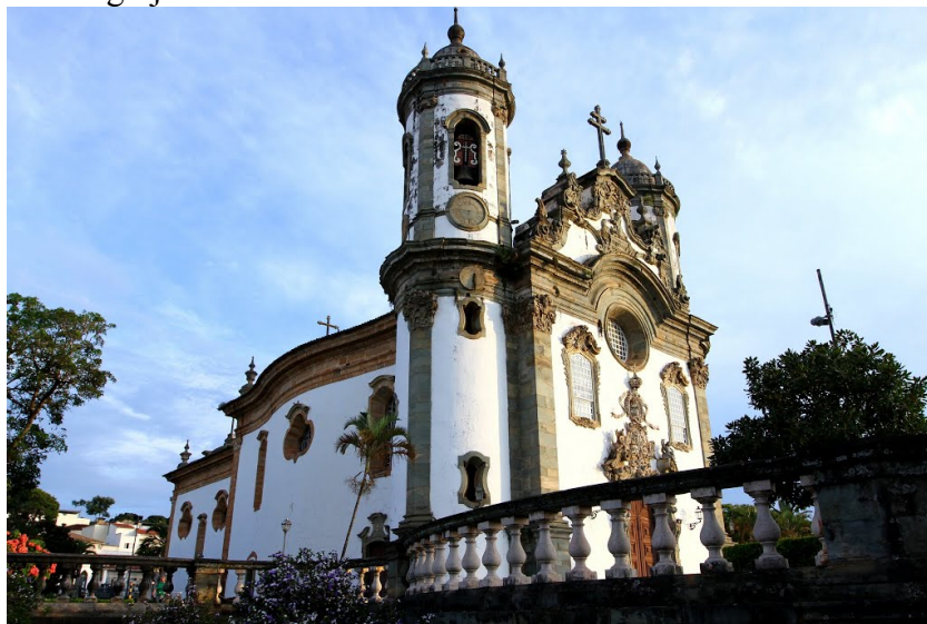
Figura 43: Igreja da Ordem Terceira de São Francisco de São João del Rei.
