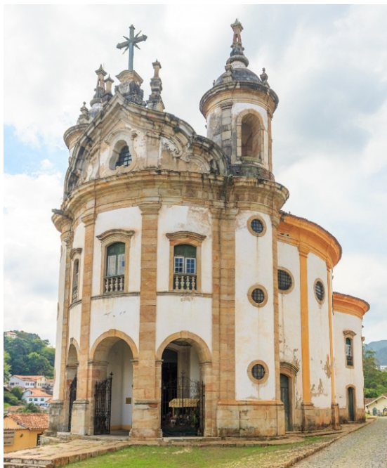
Figura 34: Igreja de Nossa Senhora do Rosário dos Homens Pretos, de Ouro Preto.
