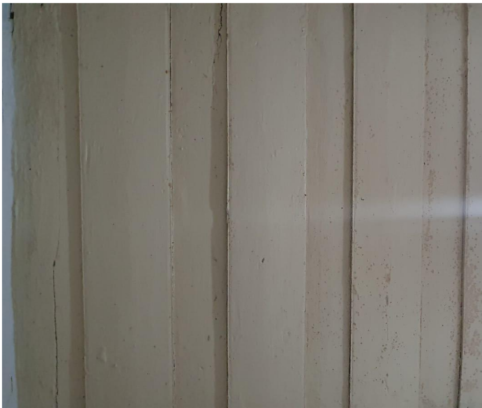
Figura 40 - Forro em saia e camisa.
