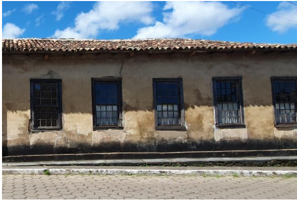
Figura 20 - Casa em estilo colonial
