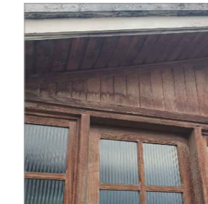
9- Destaque do verniz contaminado, gerando mancha de umidade na peça.
