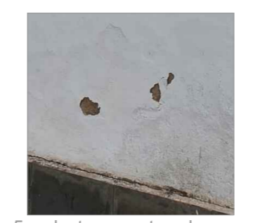
5- destacamento da camada pictórica.
