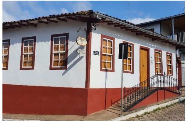
Figura 21 - Casa em estilo colonial
