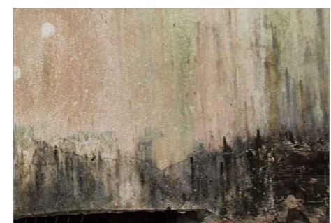
1- Patina biológica concentrada na area de maior captação de água pluvial.
