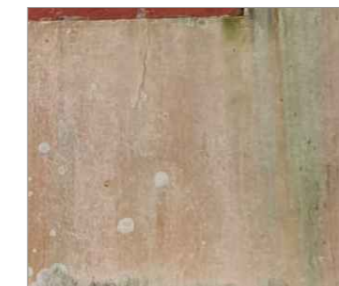
7- Oxidação e alteração da camada pictórica *proximo da árvore de goiaba que suja a parede*
