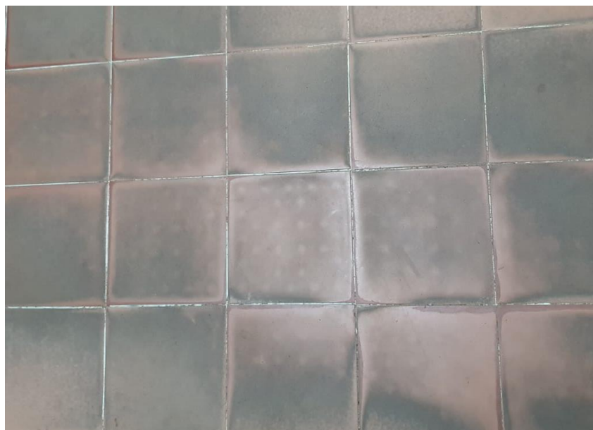
Figura 43 - Piso de cerâmica.
