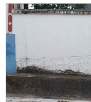
1- Pátina biológica nas regiões de maior concentração de água pluvial.
