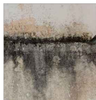
1- Pátina biológica nas regiões de maior concentração de água pluvial.
