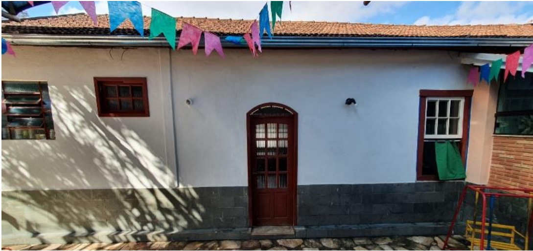
Figura 34 - Fachada lateral esquerda.
