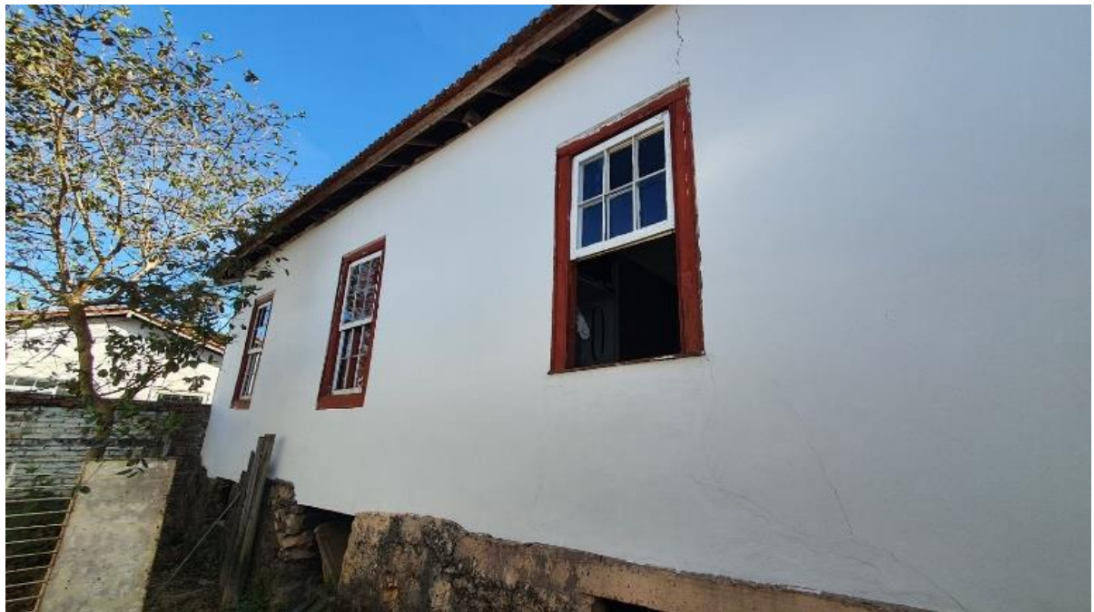
Figura 35 - Fachada lateral direita.
