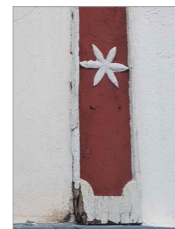
5- Elemento ornamental com pequenas perdas devido a ação do tempo juntamente com térmitas.
