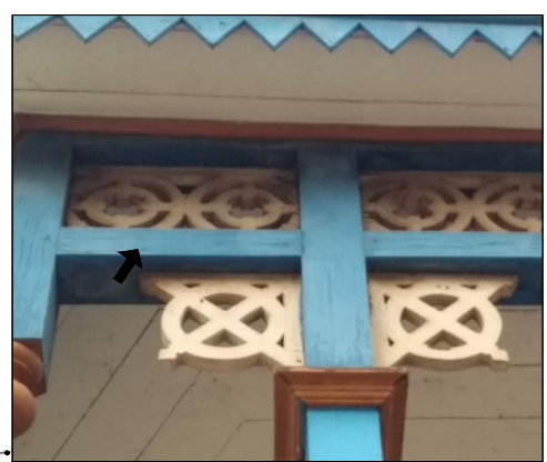
A – Detalhe da perda da coloração da camada pictórica Foto: Flávio Junior, 2021.
