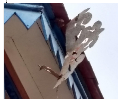
D – Detalhe do deslocamento do suporte Foto: Flávio Junior, 2021.
