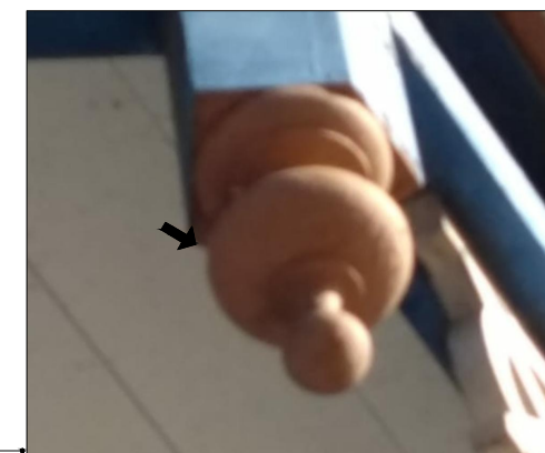
C – Detalhe perda da coloração da camada pictórica Foto: Flávio Junior, 2019.
