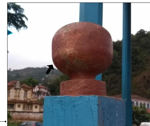
A – Detalhe craquelamento e perda da camada pictórica Foto: Flávio Junior, 2019.
