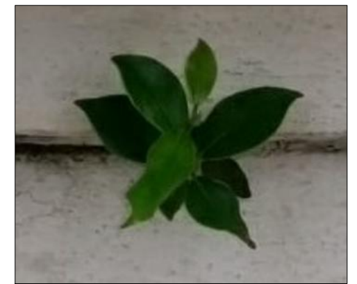
D – Detalhe da vegetação na alvenaria Foto: Flávio Junior, 2021.
