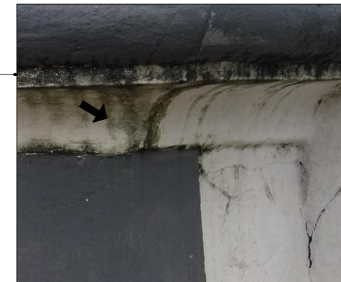
E – Detalhe biofilme (fungo) na cimalha Foto: Flávio Junior, 2019.
