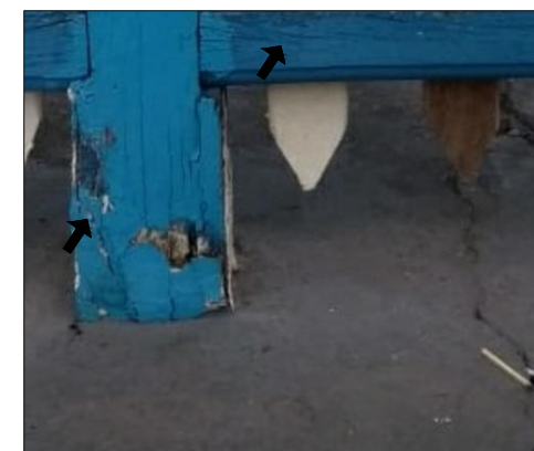
D – Detalhe craquelamento da camada pictórica Foto: Flávio Junior, 2019.
