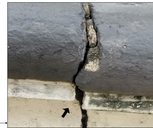
C – Detalhe da rachadura na alvenaria Foto: Flávio Junior, 2021.
