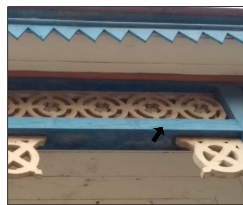
B – Detalhe da perda da coloração da camada pictórica Foto: Flávio Junior, 2021.
