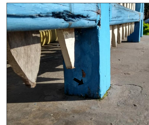
D – Detalhe apodrecimento da base do pilarete Foto: Flávio Junior, 2019.
