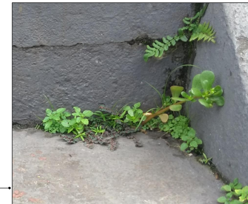
C – Detalhe vegetação na alvenaria Foto: Flávio Junior, 2019.
