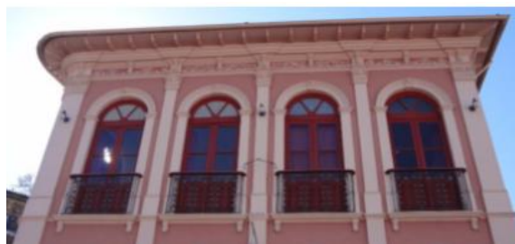
Figura 31: Detalhe do arremate do telhado atualmente no MPMG Fonte: https://www.tripadvisor.com.br/Attraction_Review-g303389-d10195167-Reviews-Predio_do_Ministerio_Publico-Ouro_Preto_State_of_Minas_Gerais.html | Data: Acesso em 21 de junho de 2021
