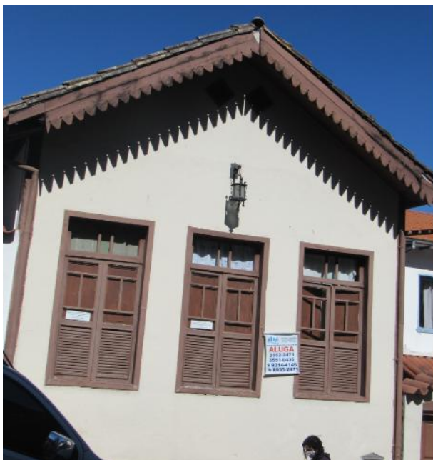
Figura 07: Edificação localizada na Rua das Flores em Ouro Preto, com características ecléticas – Lambrequim no beiral do telhado. Fonte: Luana Santos | Data: 23/06/2021
