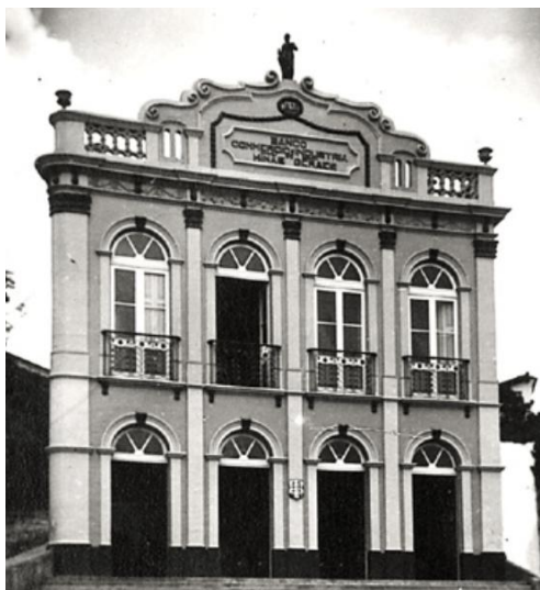
Figura 28: Fachada principal do MPMG antes da intervenção
