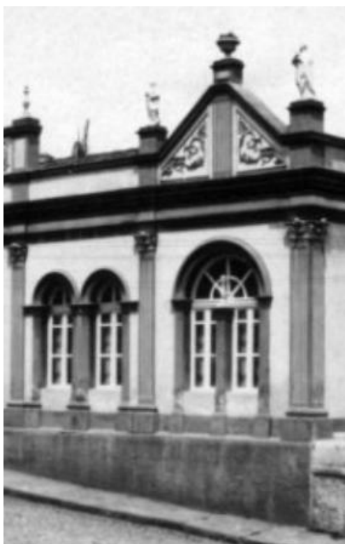
Figura 24: Detalhe do lado direito da fachada principal antes da intervenção – esquadrias e telhado
