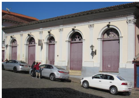
Figura 27: Detalhe da fachada principal do Cine Vila Rica depois da intervenção Fonte: Luana Santos | Data: 25/06/2021
