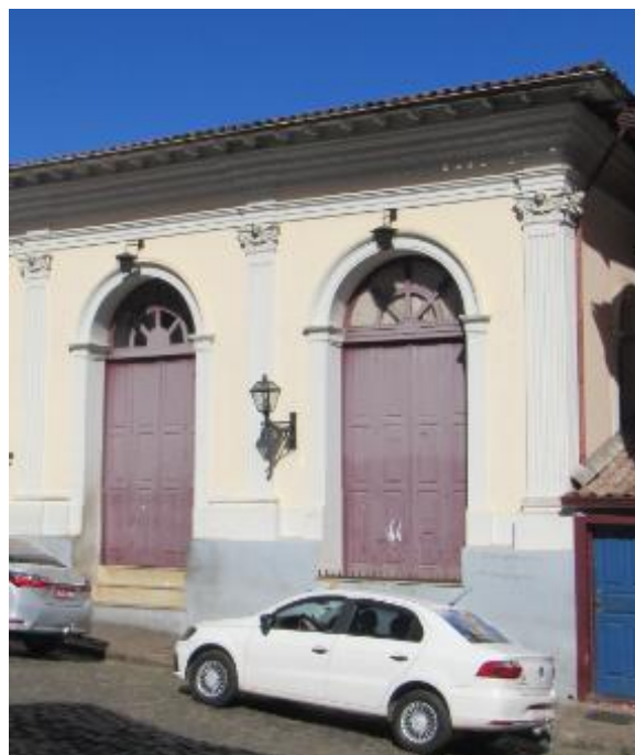
Figura 25: Detalhe do lado direito da fachada principal após a intervenção – esquadrias e telhado
