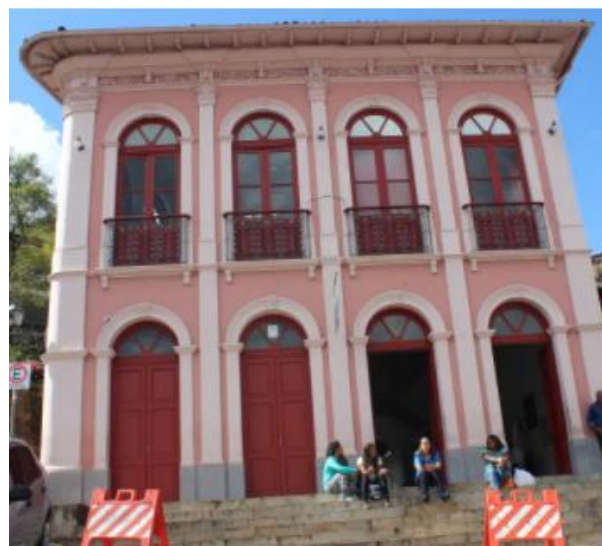
Figura 29: Fachada principal do MPMG após a intervenção
