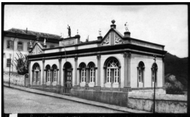
Figura 26: Detalhe da fachada principal do Cine Vila Rica antes da intervenção Fonte: acervo Luiz Fontana em https://ouropreto.mg.gov.br/luizfontana/#fotografias | Data: Acesso em 22 de maio de 2021 às 19h30min.
