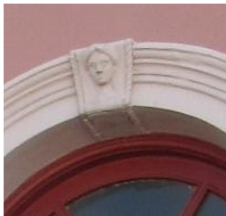
Figura 35: Detalhe da aduela que compõem os arcos do MPMG Fonte: Luana Santos | Data: 25/06/2021
