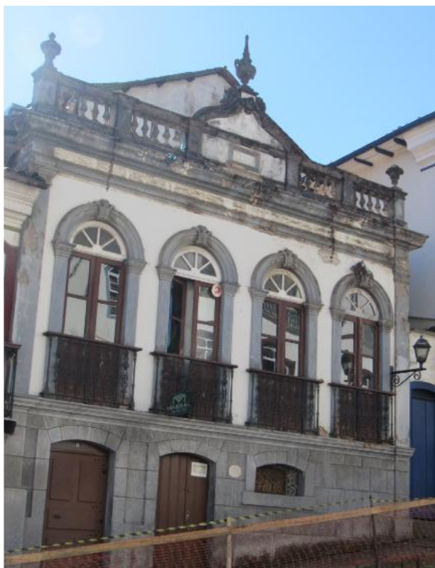
Figura 05: Edificação localizada na Rua Direita em Ouro Preto, com características ecléticas – platibanda com elementos decorativos, gradil de ferro, bandeiras e folhas das janelas de vidro. Fonte: Luana Santos | Data: 23/06/2021
