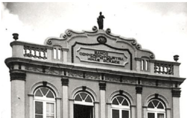
Figura 30: Detalhe do arremate do telhado antes da intervenção no MPMG Fonte: Fonte: acervo Luiz Fontana https://ouropreto.mg.gov.br/luizfontana/#fotografias | Data: acessado em 18 de junho de 2021
