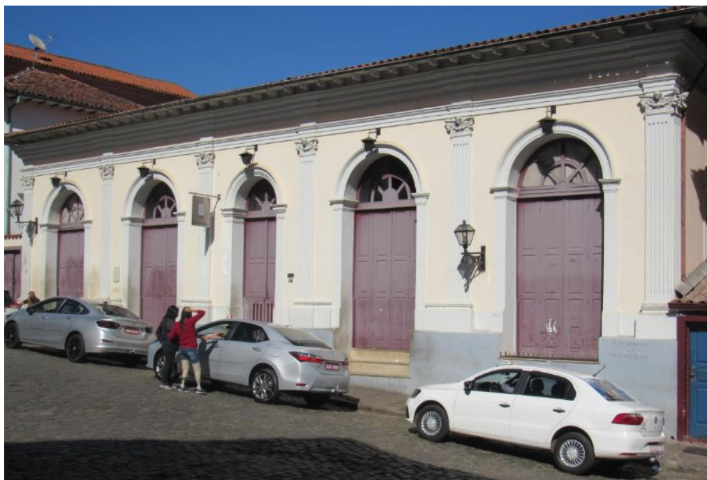
Figura 15: Vista da fachada frontal do Cine Vila Rica Fonte: Luana Santos | Data: 25/06/2021
