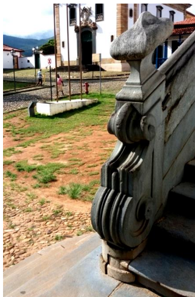
Figura 19: Detalhe do acabamento em cantaria da escadaria da Câmara de Mariana. Fonte: Walleska Werneck, 2018.
