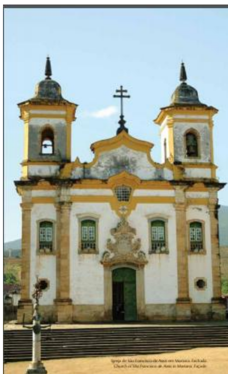
Figura 5: Fachada da igreja de São Francisco. Mariana - MG. Fonte: OLIVEIRA, 2010, p. 136.
