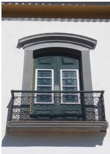
Figura 11: Sacada com balcão em pedra e parapeito em ferro da Câmara Municipal de Mariana. Fonte: Walleska Werneck, 2018.
