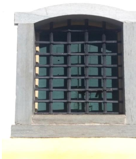
Figura 12: Janela frontal do piso inferior com grade de ferro. Fonte: Walleska Werneck, 2018.
