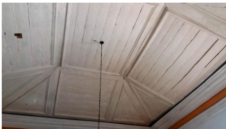
Figura 15: Detalhe do forro de madeira do andar superior. Fonte: Walleska Werneck, 2018.
