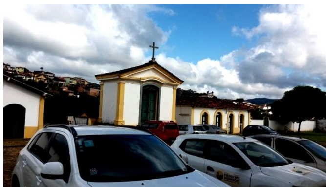
Figura 20: Passo e antigo armazém da Câmara Municipal de Mariana-MG. Fonte: Walleska Werneck, 2018.
