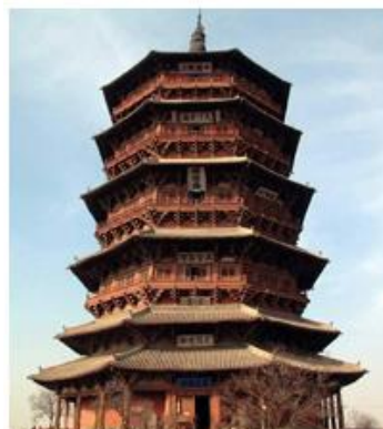
Figura 49: Pagode localizado no templo budista de Fogong, no distrito de Yingxian, província de Shanxi da China, construído na Dinastia Lian (916-1125). Fonte < http://portuguese.cri.cn/152/2006/10/31/1@54545.htm > Acesso em janeiro de 2020.
