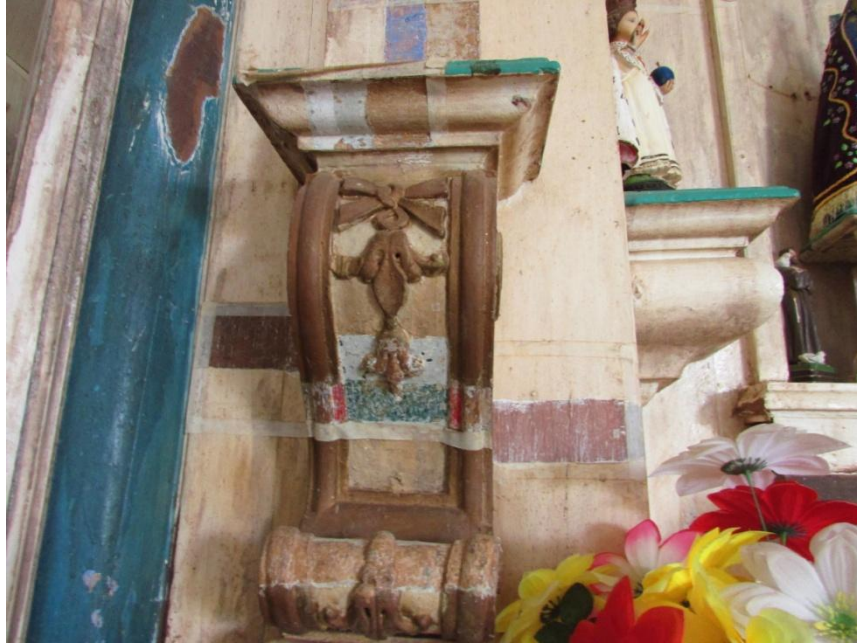
Figura 39: Detalhe de prospecção. Fonte: Cássia Miranda, 2019.
