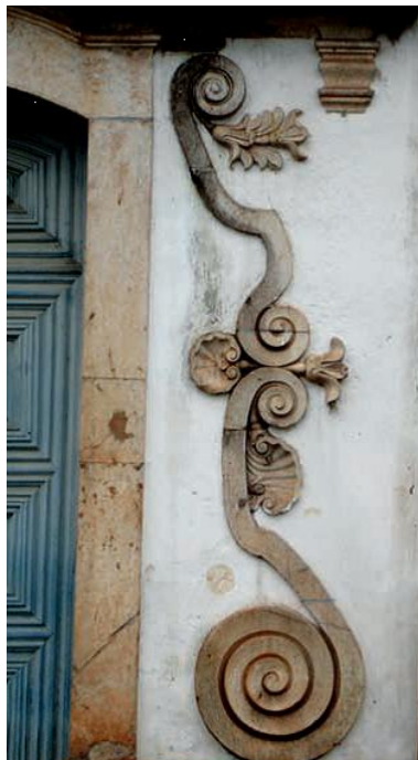
Figura 46: Detalhe de ornamentação na fachada principal. Fonte: IEPHA, 2014, v. 1, p. 95.
