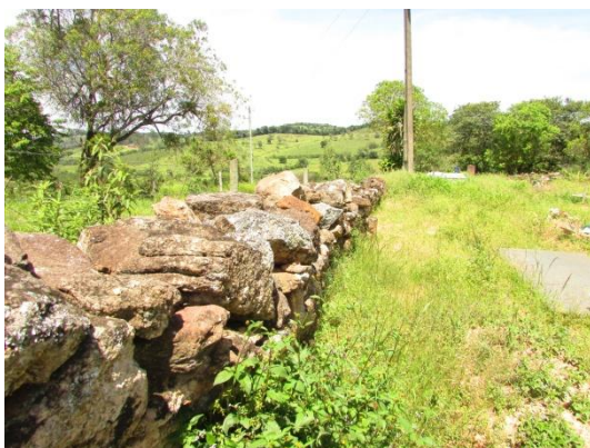
Figura 25: Muro de pedra (entorno da capela). Fonte: Cássia Miranda, 2019.
