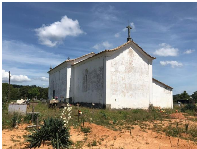
Figura 23: Fachada posterior da Capela de N. S. da Lapa de Olhos d'Água. Fonte: Cássia Miranda, 2019.
