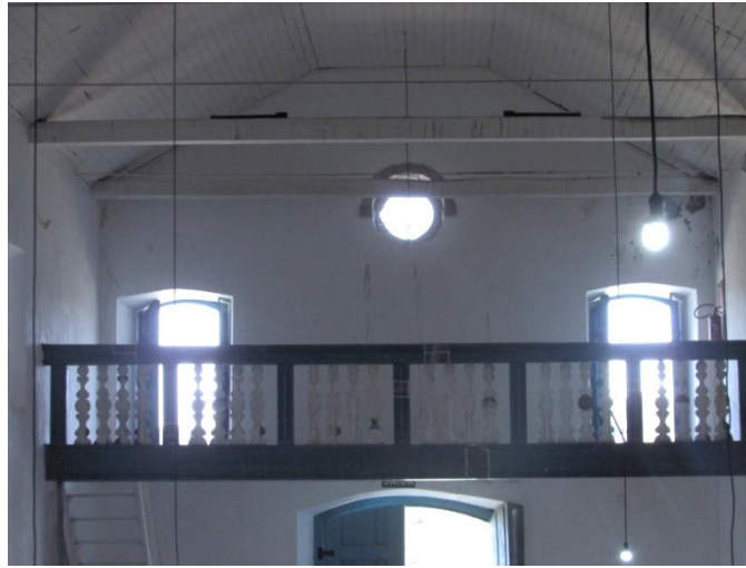
Figura 38: Detalhe do coro e forro. Fonte: Cássia Miranda, 2019.
