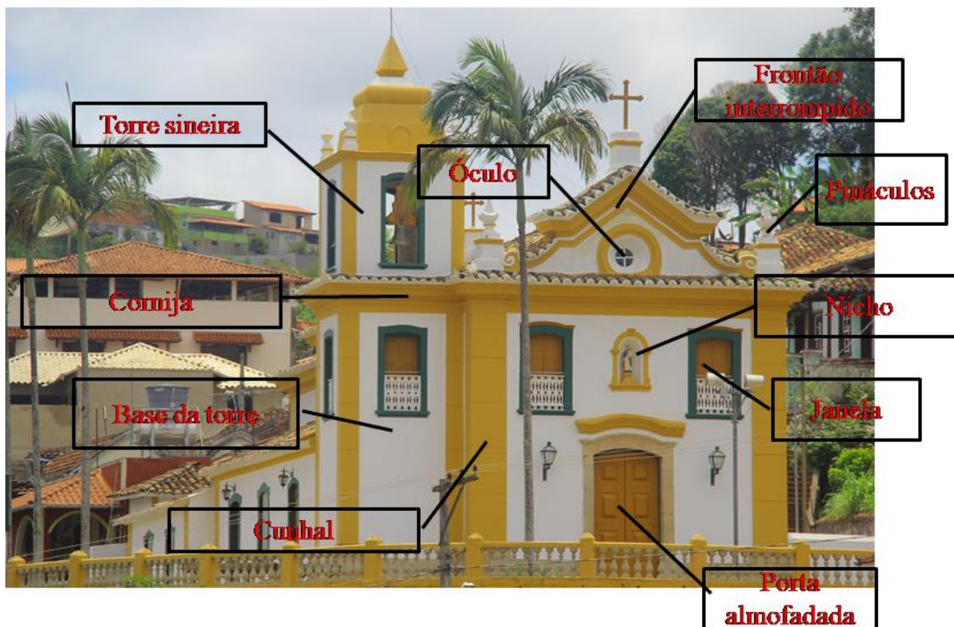
Figura 55: Fachada frontal, capela de N. S. do Rosário, Prados - MG. Disponível em: https://www.viaggiando.com.br/2017/01/prados.html . (acesso em: 28 jun. 2019).
