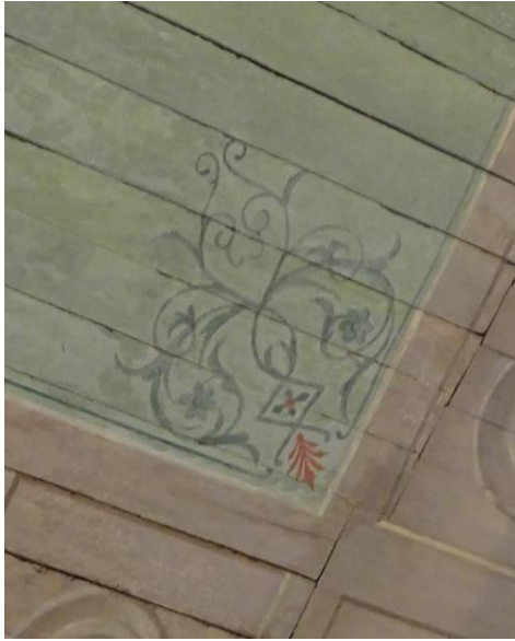
FIGURA 29: Motivo – forro da nave. Fonte: ACERVO PESSOAL, 2018.
