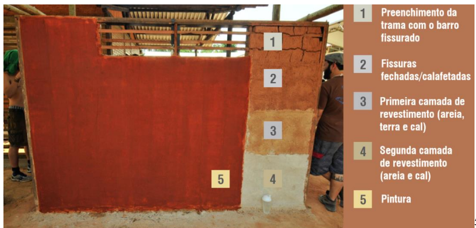
Figura 5. Fases de uma parede em pau a pique. Viçosa – MG, 2014. Autor: CARDOSO.
