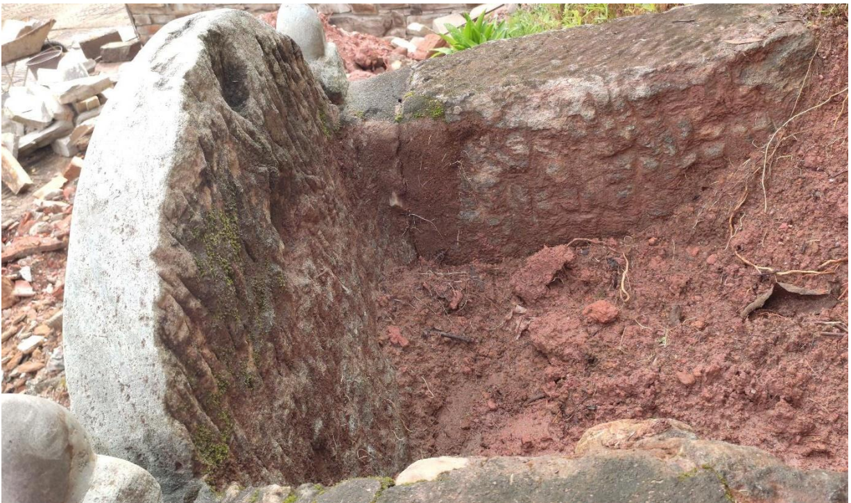
Figura 13- Parte posterior do coroamento a bacia de captação e detalhe onde se vê o desbaste bruto da pedra sabão.
