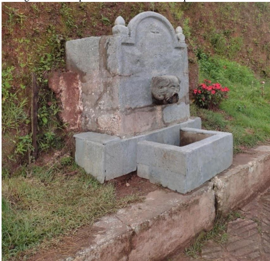
Figura 8- Vista parcial frontal e lateral esquerdo do chafariz.
