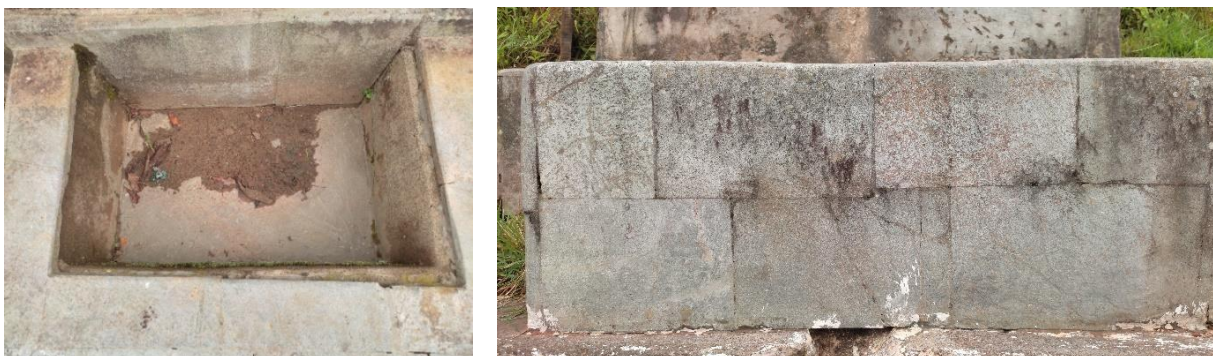
Figura 9- Detalhe de dentro da bacia e revestimento frontal.
