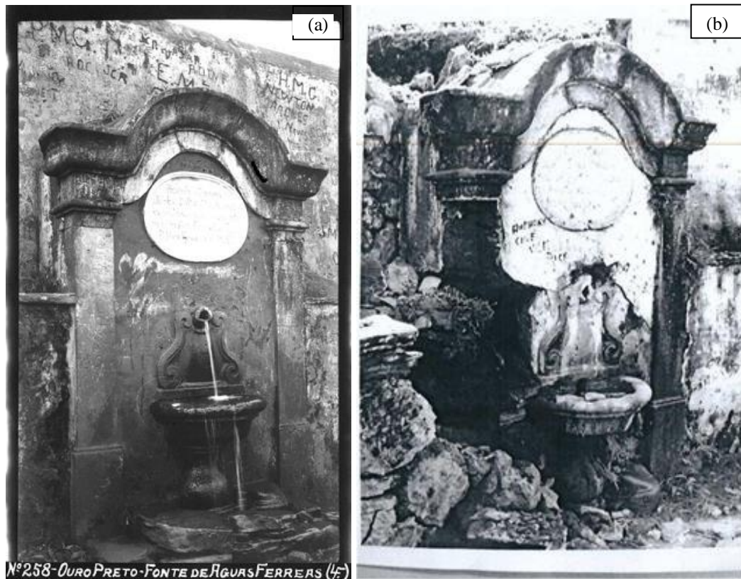
Figura 4 - Chafariz após ser atingido por queda de barreiras em 1960.
