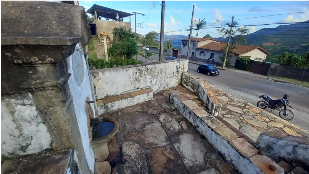
Figura 50 - Destaque para a proximidade do Chafariz com a rodovia.
