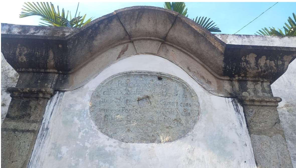
Figura 16 - Chafariz das Águas Férreas. Detalhe para a moldura elíptica em pedra sabão.
