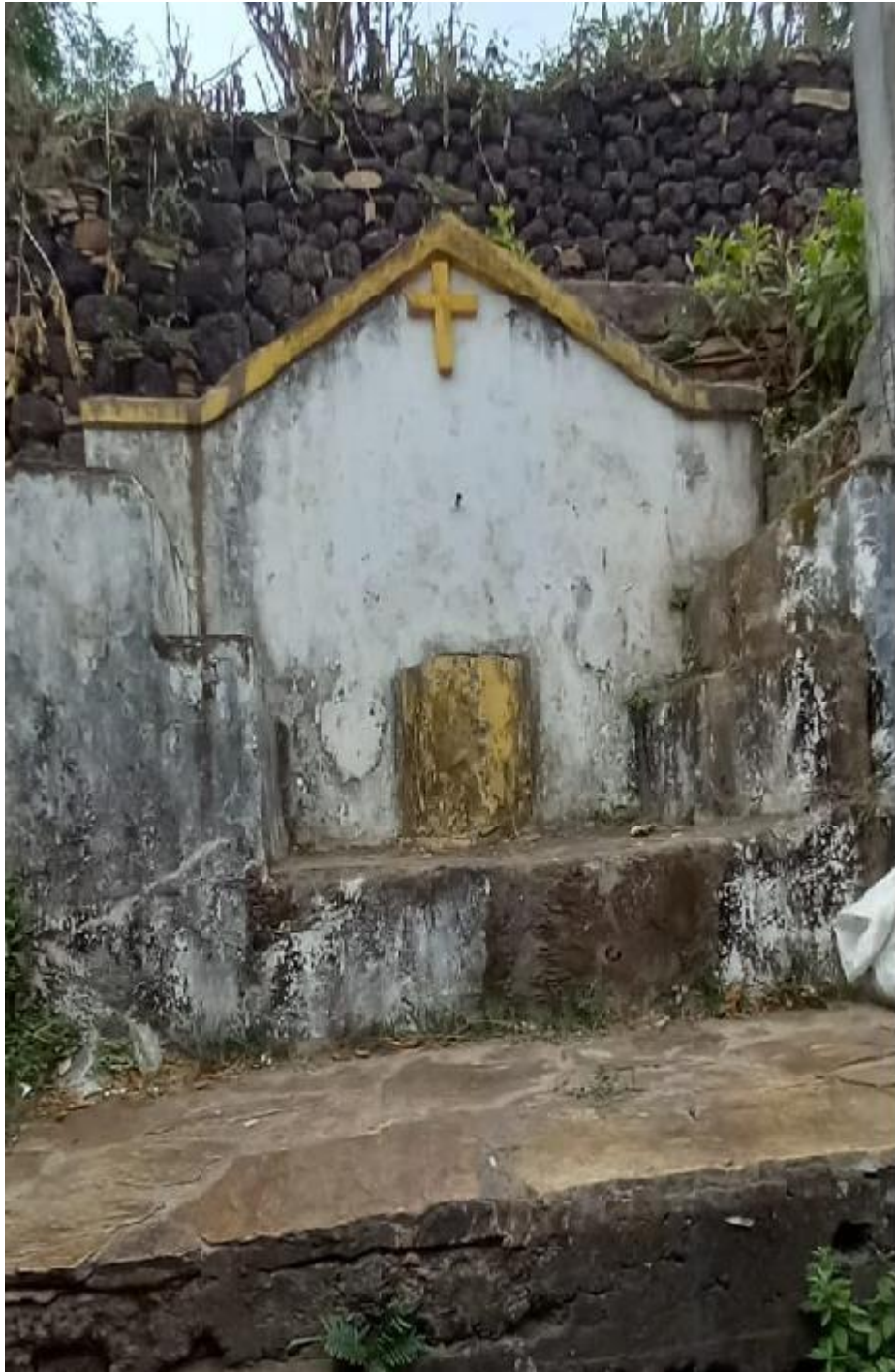
Figura 40 - Chafariz da Sobreira ou do Beco da Canastra.
