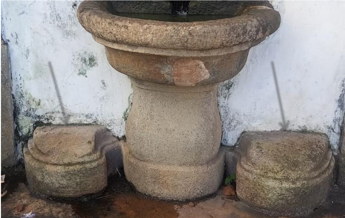
Figura 48 - Destaque para os socos para os pés.
