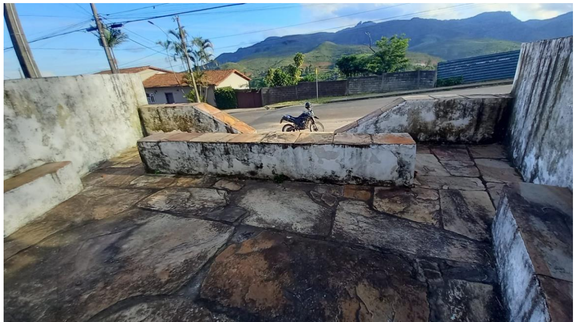
Figura 53 - Destaques para paredões de contornam o Chafariz.
