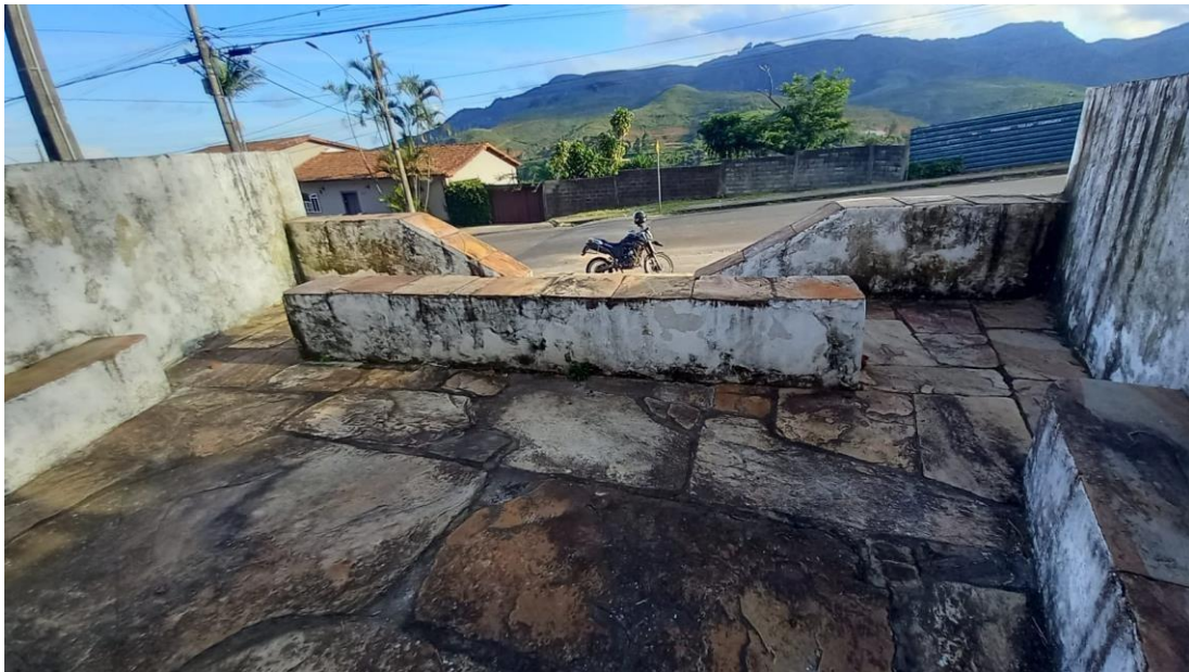
Figura 51 - Destaque para o piso em pedras de quartzito.
