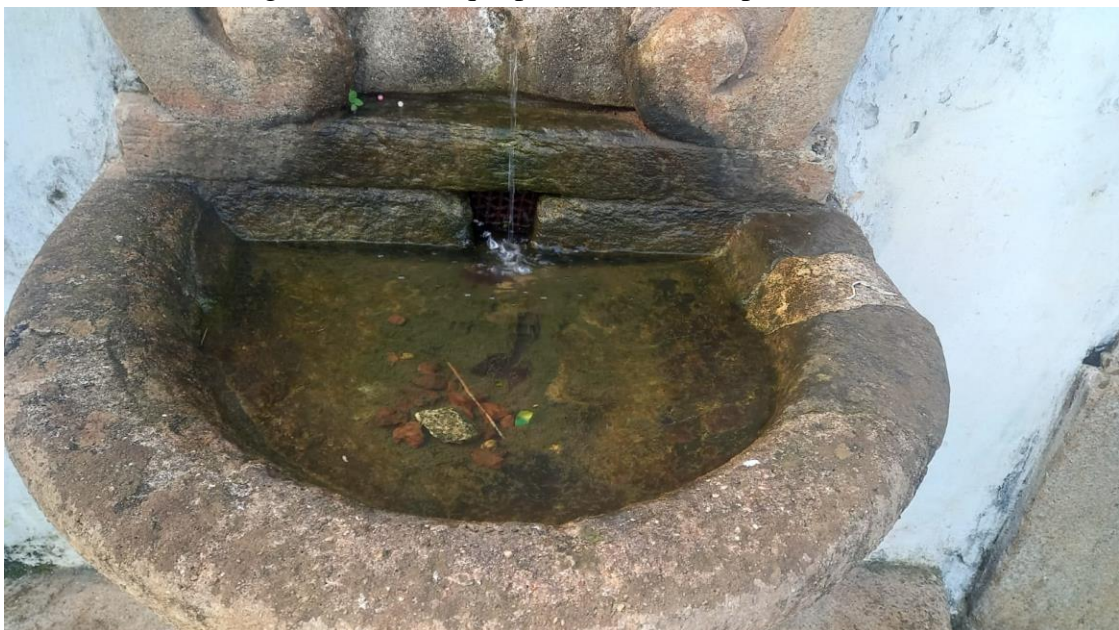
Figura 49 - Destaque para o interior da pia (bacia).
