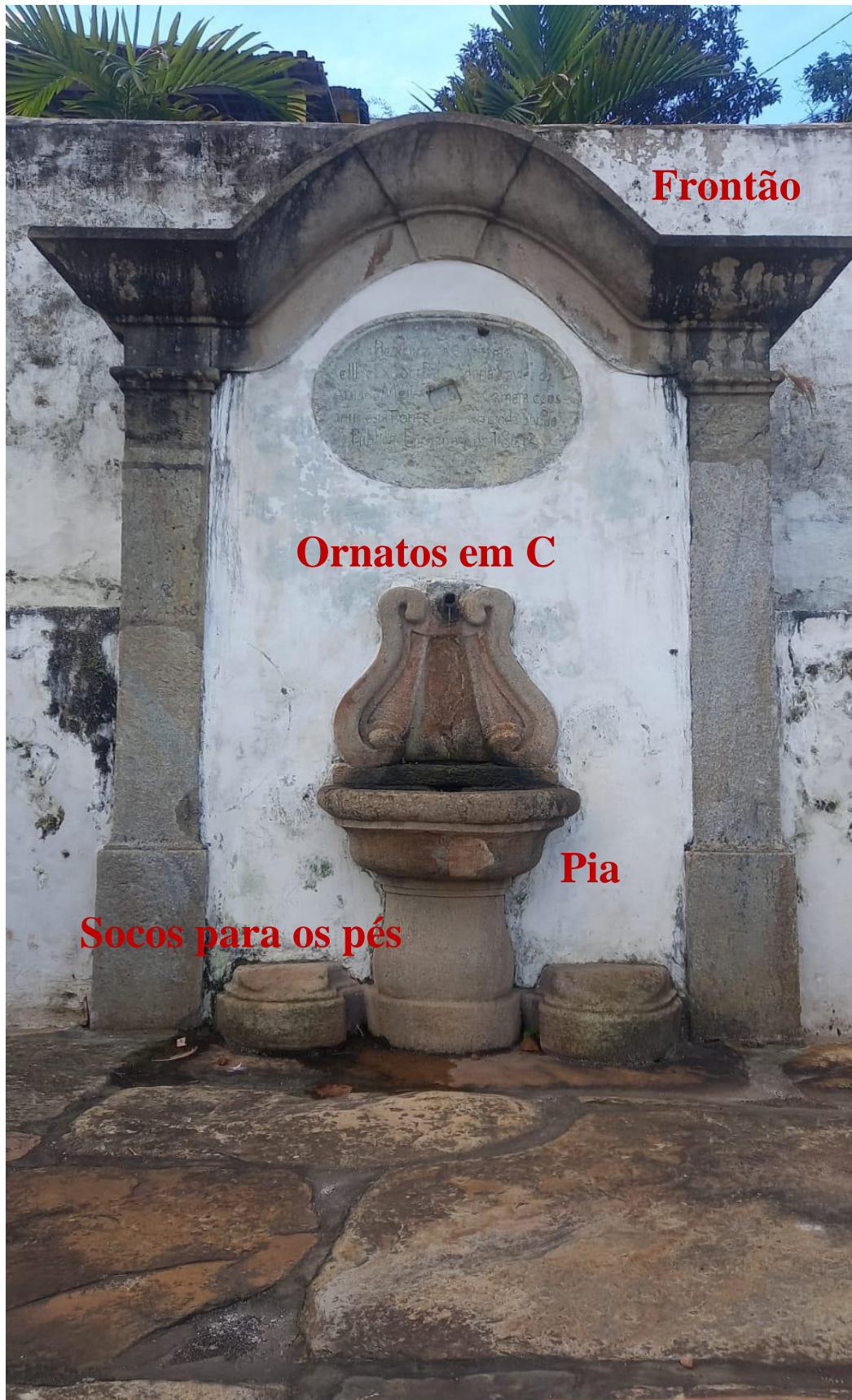
Figura 15 - Detalhe para a os elementos que compõem a estrutura do chafariz.
