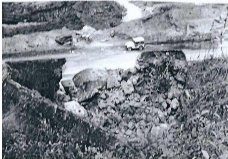
Figura 6 - Chafariz após ser atingido por queda de barreiras em 1960.
