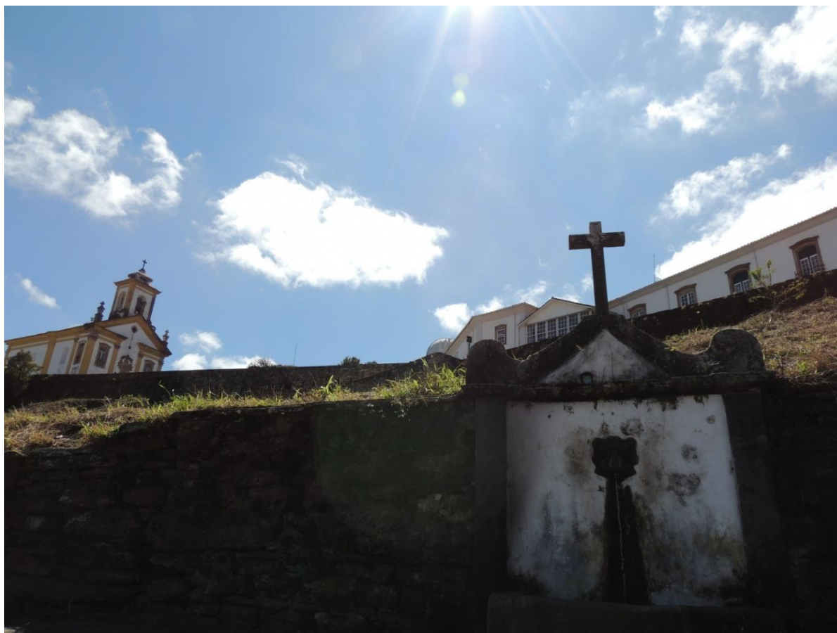
Figura 32 - Chafariz dos Cavalos ou do Quartel.
