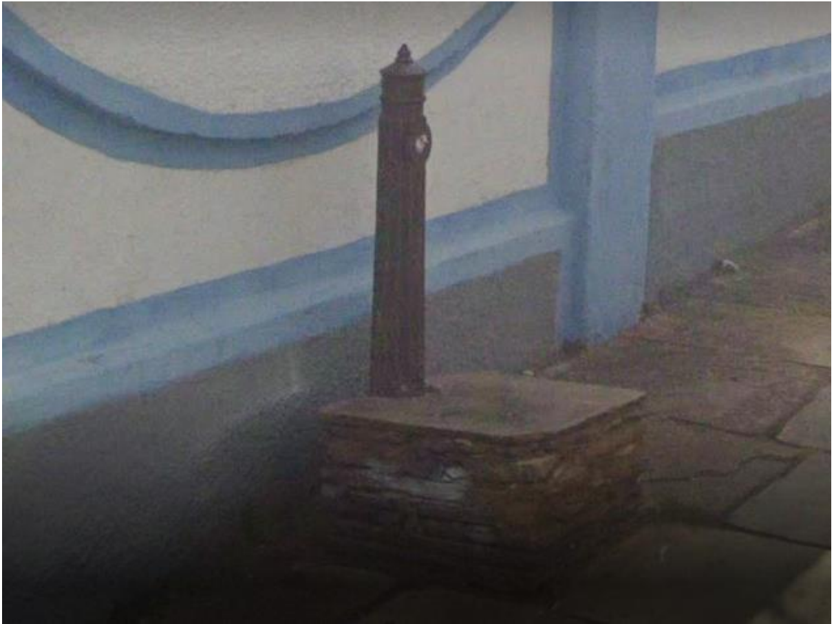
Figura 37 - Chafariz de Ferro da Rua Alvarenga.
