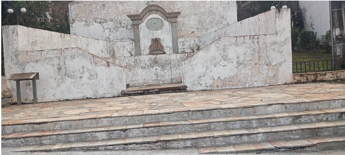
Figura 57 - Destaque para o Chafariz após remoção das sugididades.
