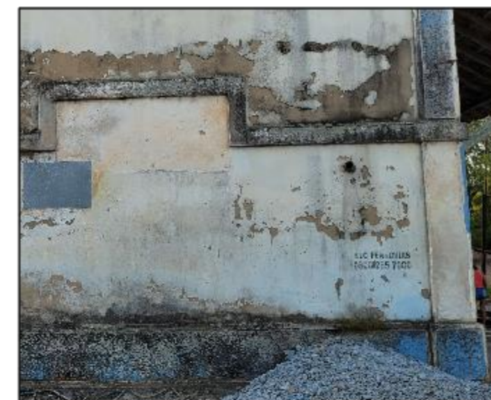
3_ Perda de camada pictórica, mancha de umidade intervenção inadequada, esmaecimento da camada pictórica e sujidade generalizada
