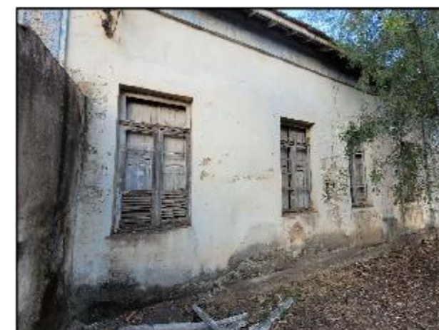
1 Esmacimento da camada pictórica e sujidade generalizada e mancha de umidade
