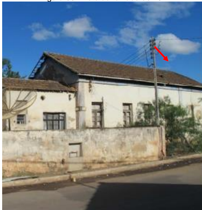
Figura 55 - Foto do telhado de 2011
