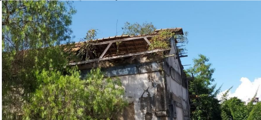
Figura 3 - Foto do telhado da Estação Ferroviária de Santo Antônio dos Campos
