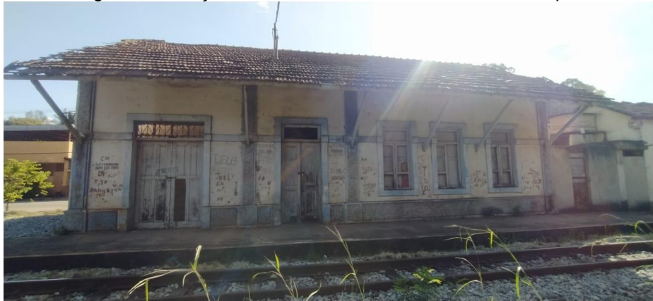
Figura 2 - Estação Ferroviária de Santo Antônio dos Campos
