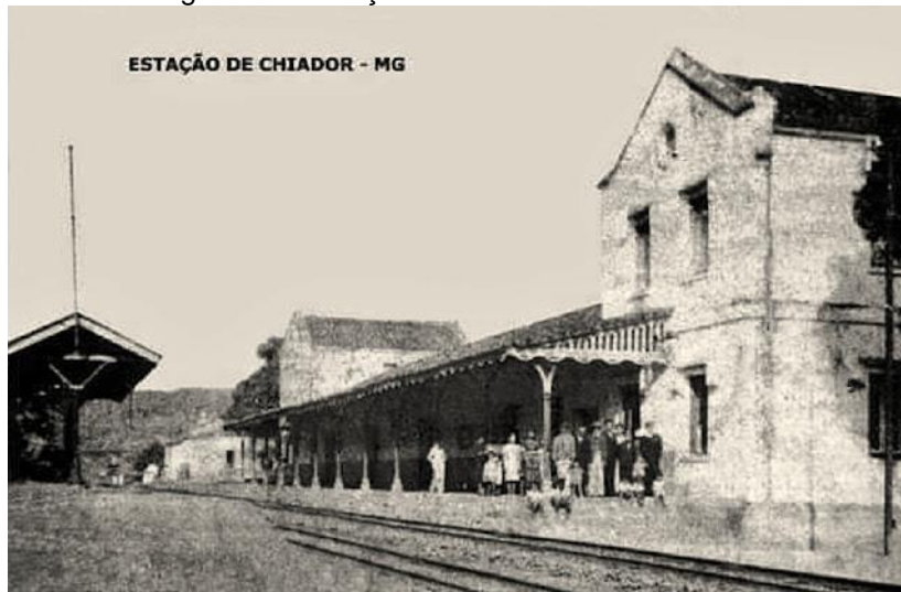
Figura 10 - Estação Ferroviária de Chiador MG
