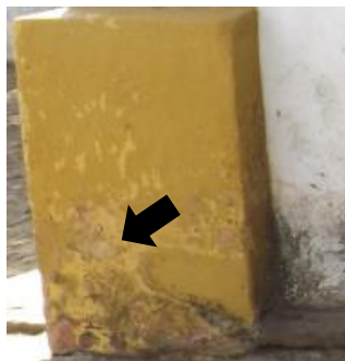
03 – Detalhe do embasamento do cunhal esquerdo
