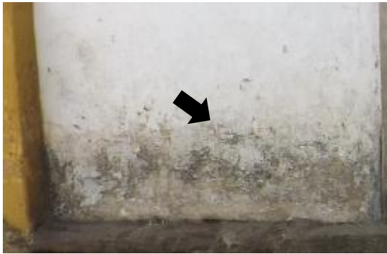
01 – Detalhe inferior lado esquerdo do embasamento
