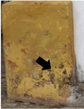
01 – Detalhe do embasamento do cunhal esquerdo.
