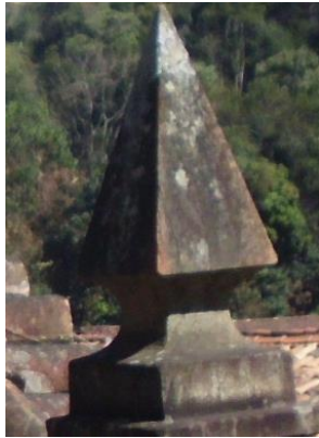
01 – Detalhe do coruchéu esquerdo
