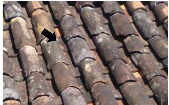
02 – Detalhe da cobertura, água direita.
