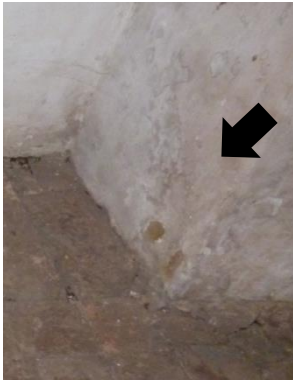
01 – Detalhe da alvenaria.
