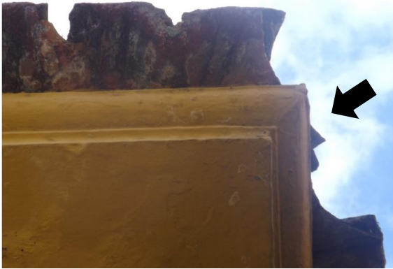
01 – Detalhe da cobertura
