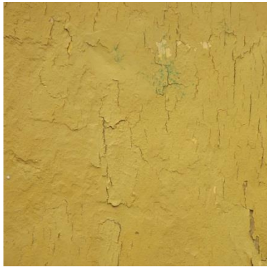
01 – Detalhe do cunhal esquerdo .
