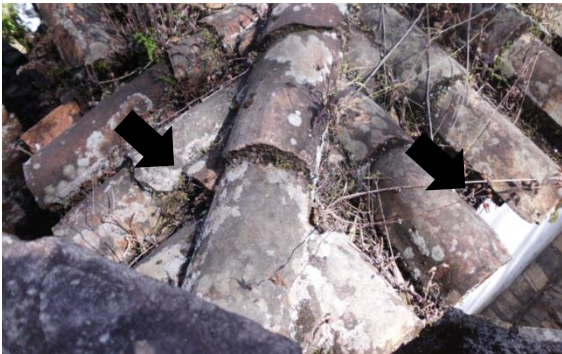
03 – Detalhe da cobertura
