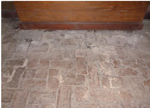
01 – Detalhe superior do piso
