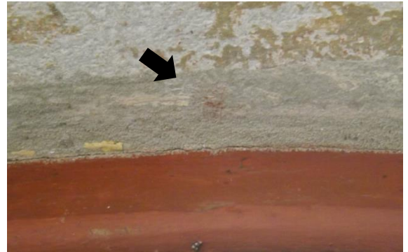
02 – Detalhe do acabamento da verga da esquadria
