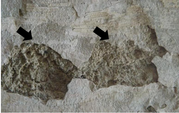
01 – Detalhe da parede em alvenaria
