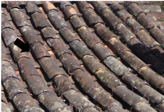
01 – Detalhe da cobertura, água esquerda.
