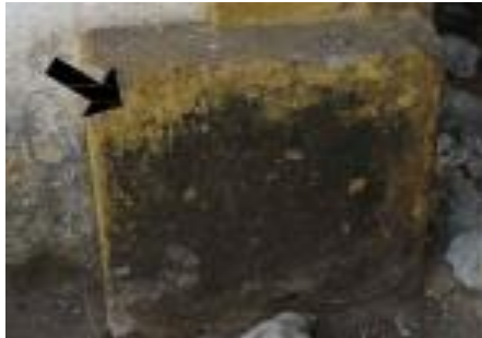
01 – Detalhe do embasamento do cunhal direito
