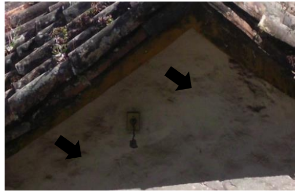
02 – Detalhe da empena
