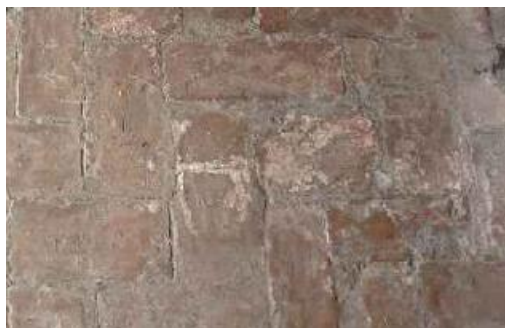
03 – Detalhe do piso
