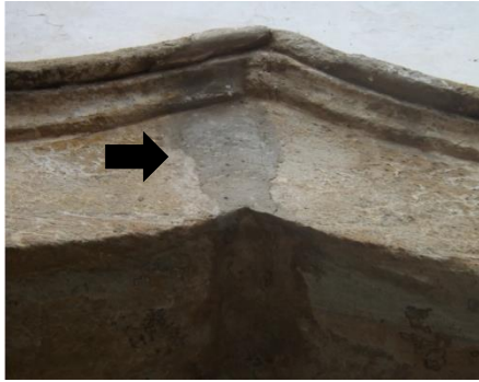
01 – Detalhe da verga da porta frontal.
