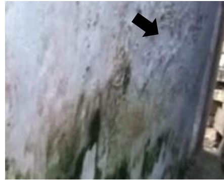
02 – Detalhe da alvenaria
