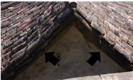
03 – Detalhe da empena
