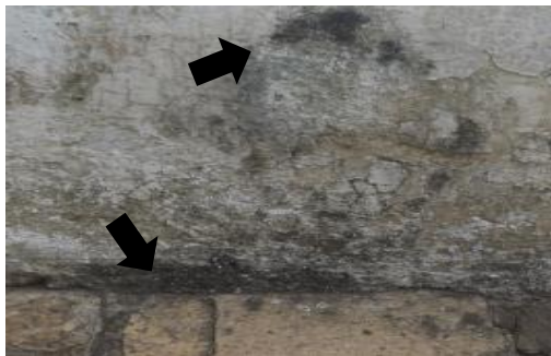
03 – Detalhe do embasamento do cunhal esquerdo
