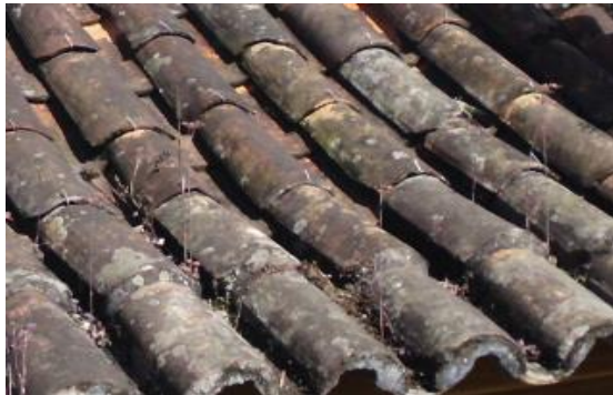
03 – Detalhe da cobertura, água esquerda
