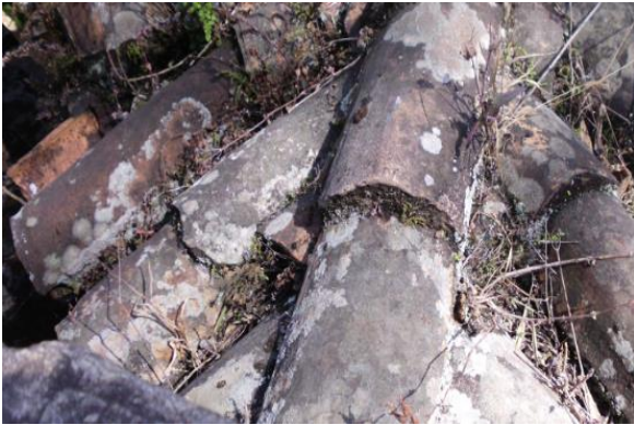
01 – Detalhe posterior da cobertura
