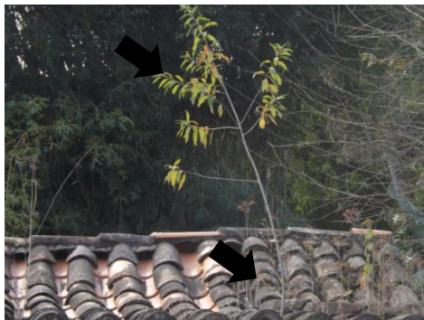
03 – Detalhe da cobertura
