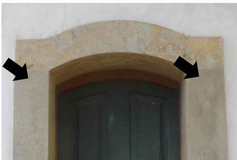
03 – Detalhe dos umbrais da esquadria.
