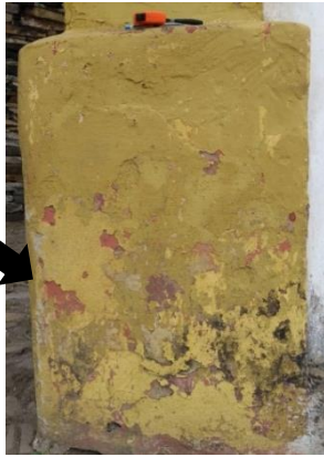
01 – Detalhe do embasamento do cunhal esquerdo.
