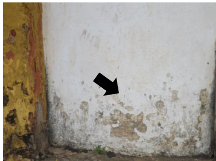
03 – Detalhe do embasamento, lado esquerdo.
