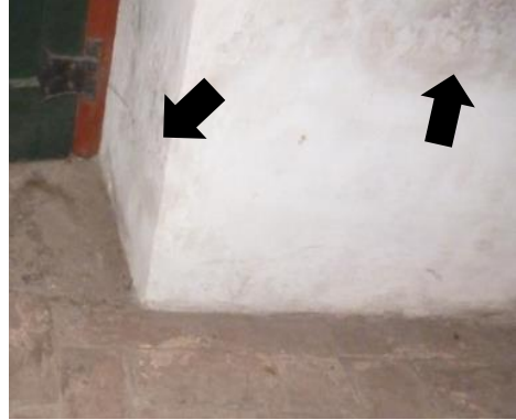
02 – Detalhe da alvenaria.
