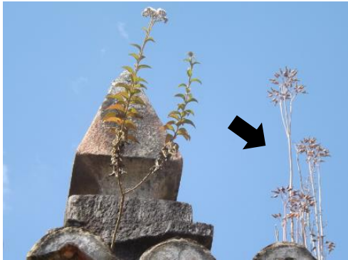
01 – Detalhe da cobertura
