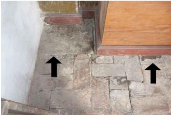
01 – Detalhe canto superior esquerdo do piso
