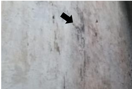
01 – Detalhe da parede em alvenaria
