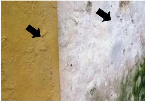
01 – Detalhe do cunhal esquerdo e alvenaria
