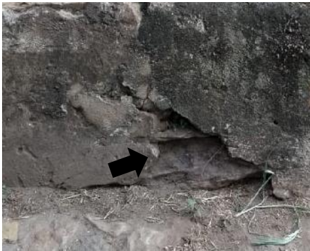
01 – Detalhe inferior do embasamento
