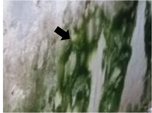
02 – Detalhe da alvenaria
