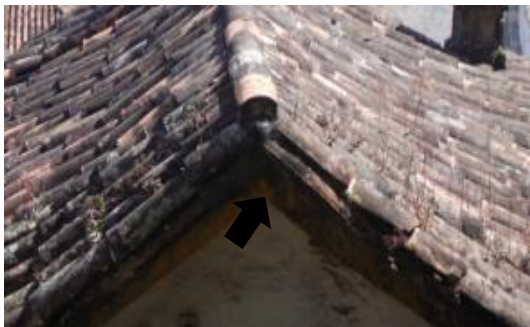
03 – Vista posterior da cobertura
