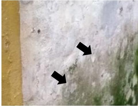
01 – Detalhe da parede em alvenaria
