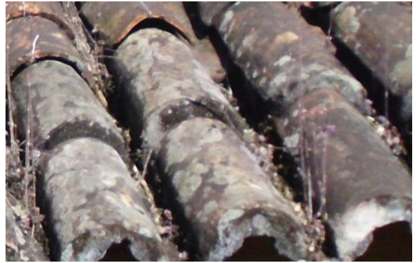
02 – Detalhe da cobertura, água direita.
