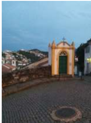
Figura 16-Fachada frontal Passo do Pretório
