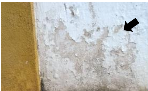
03 – Detalhe do embasamento do cunhal esquerdo
