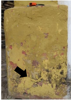
01 – Detalhe do embasamento do cunhal esquerdo.
