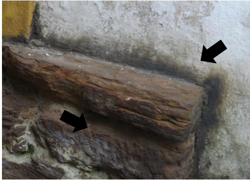
01 – Detalhe inferior lado esquerdo do embasamento
