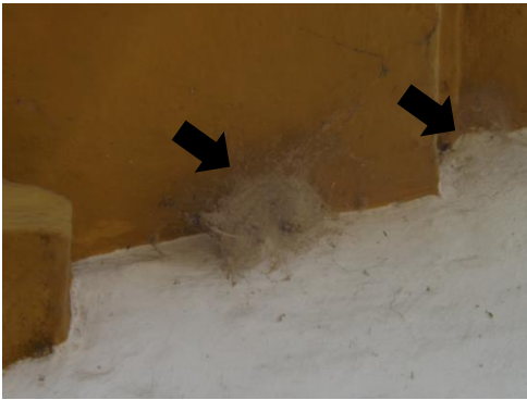
01 – Detalhe do embasamento do cunhal esquerdo.
