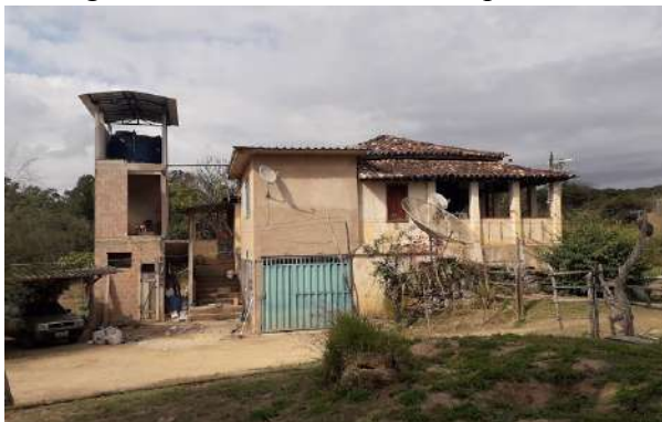
Figura 73 - Fachada lateral esquerda
