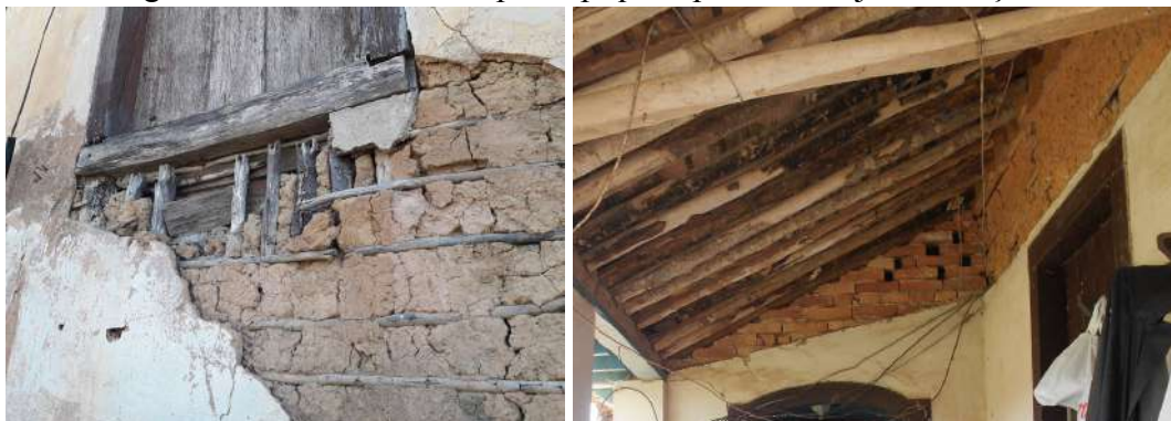
Figura 30 e 31 - Parede de pau a pique e parede de tijolo maciço
