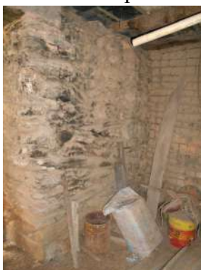
Figura 32 - Paredes de pedra no porão
