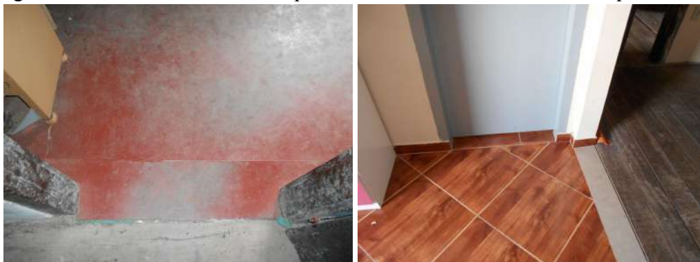
Figura 35 e 36 - Piso de cimento queimado na cozinha e cerâmica no quarto cinco
