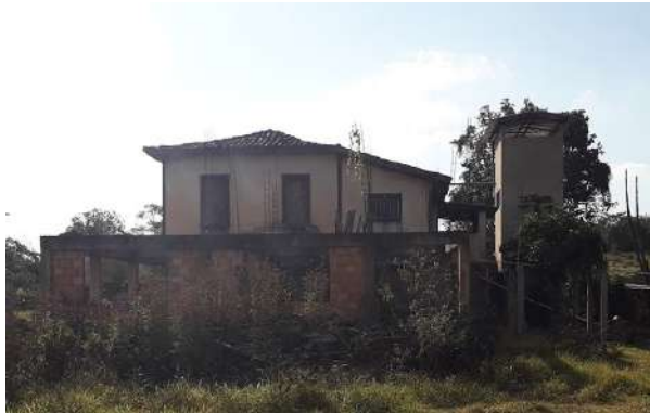
Figura 72 - Fachada lateral direita
