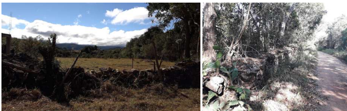
Figuras 22 e 23 - Muros de pedras próximo ao casarão.
