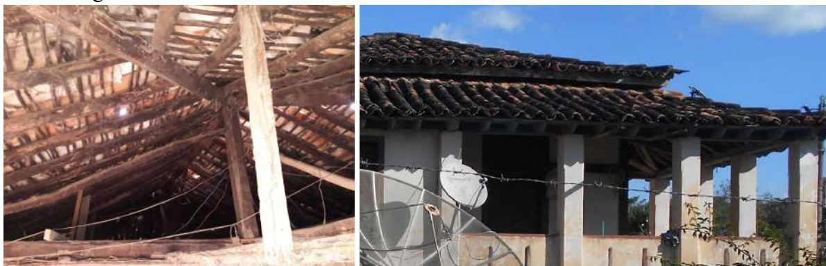
Figuras 25 e 26 - Estrutura do telhado e cachorros no beiral da varanda
