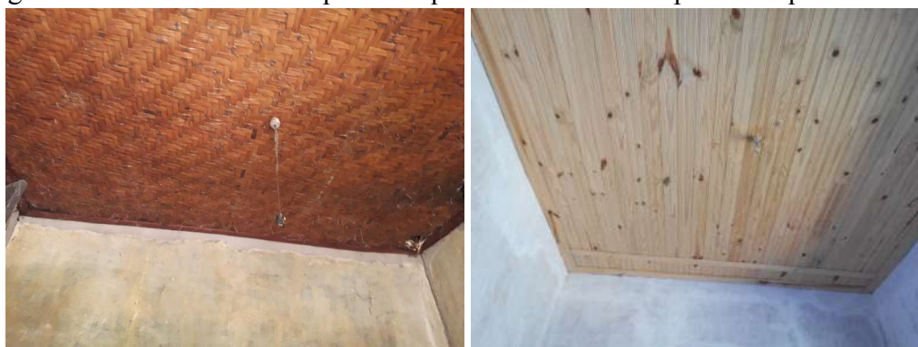
Figuras 37 e 38 - Forro de taquara no quarto três e forro de pinus no quarto dois
