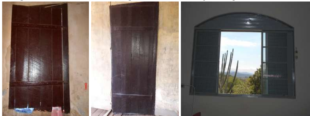
Figuras 39, 40 e 41 - Janela e porta de madeira e janela quarto cinco
