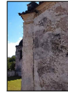
2: Mancha negra, perda da camada pictórica, perda da coloração da camada pictórica e biofilme
