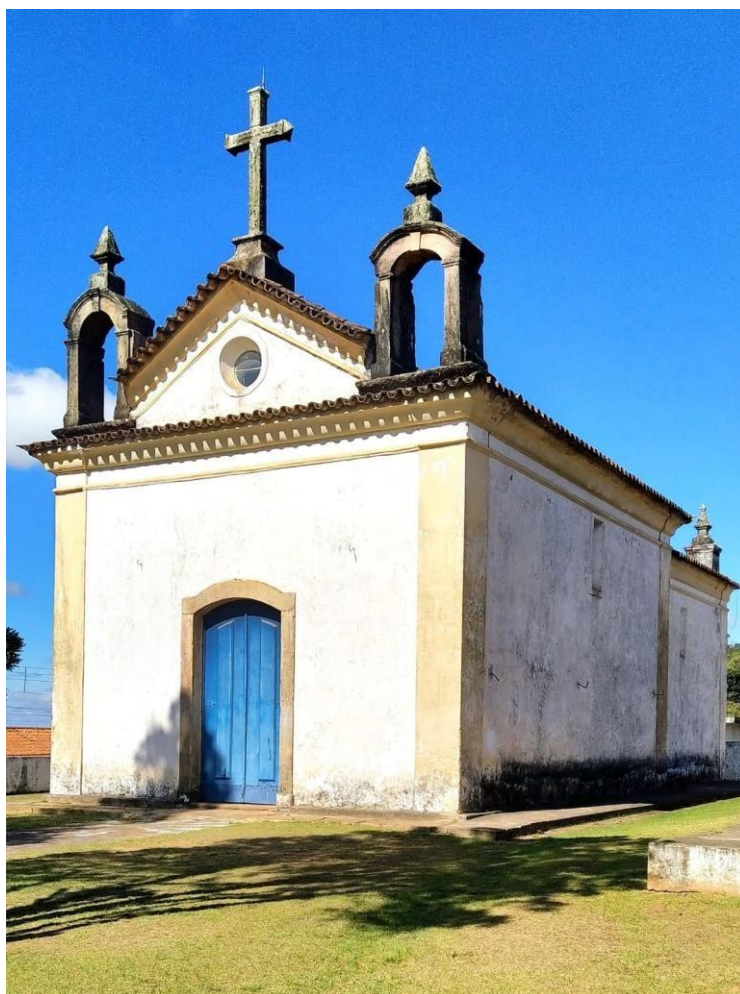
Figura 1 – Fachda Capela São Bartolomeu
