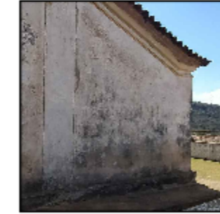
3: Mancha negra, perda da camada pictórica e vício de construção
