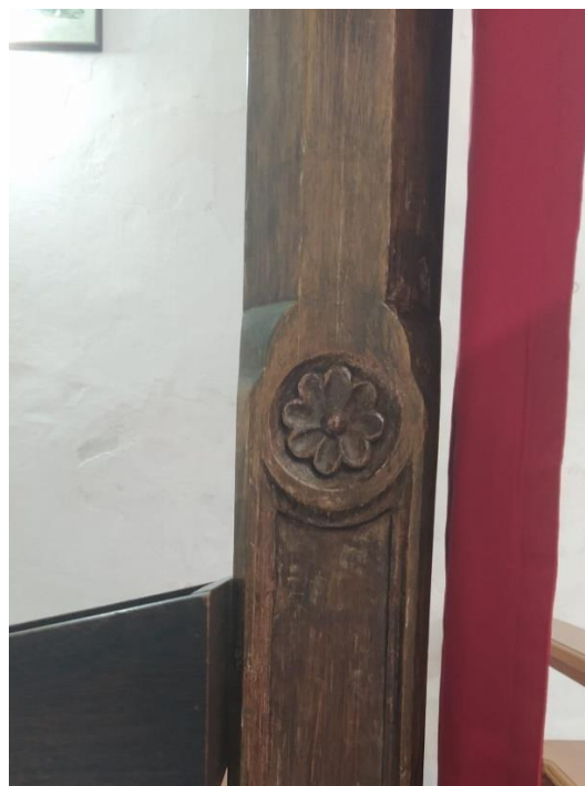
Figura 9 – Detalhe do pilar do coro
