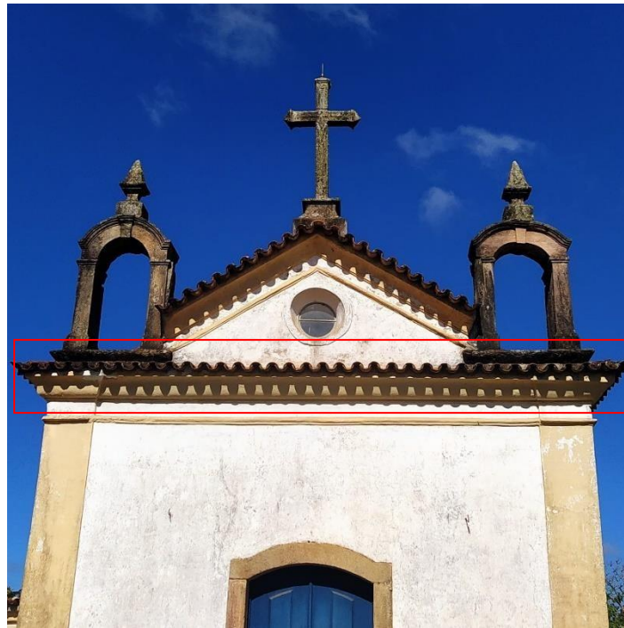
Figura 5 – Frontal delimitado por cimalha
