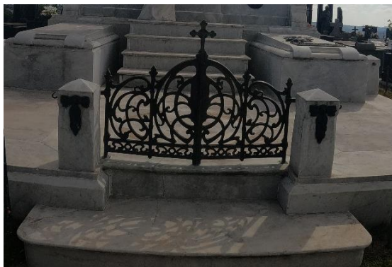
Figura 53 Portão de acesso ao "interior" da obra. Fonte: Cíntia Murta
