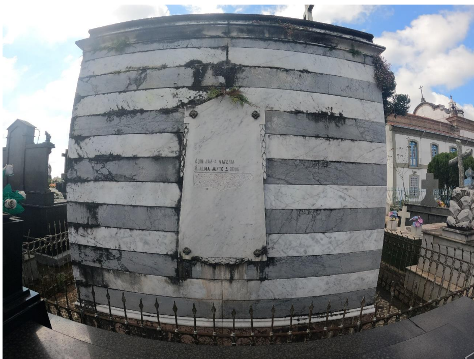
Figura 47 Fachada lateral esquerda. Fonte: Cintia Murta Castro Lima
