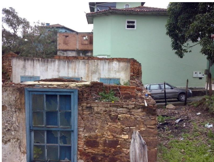
Figura 4 –Alvenaria de pedra seca na edificação
