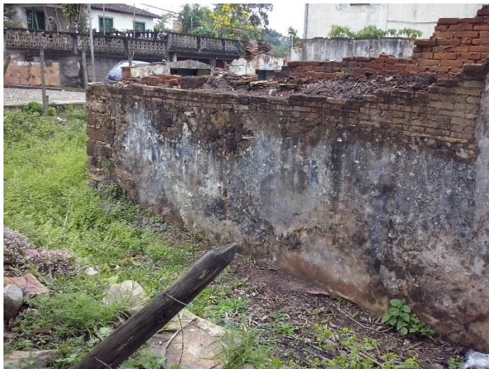
Figura 22 – Deposição do solo junto à edificação
