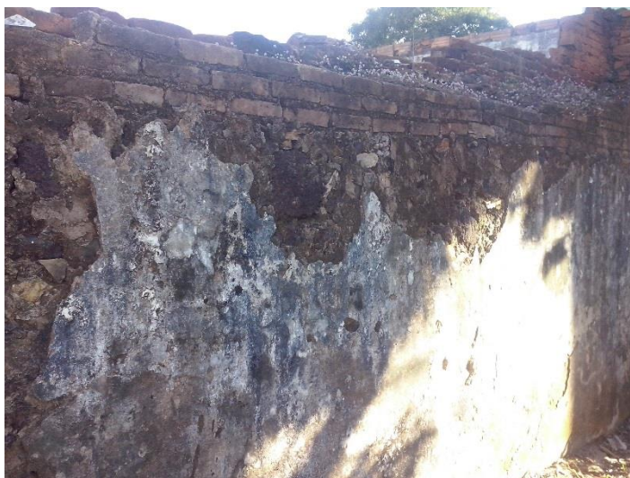
Figura 24 – Pontos de estufamento de reboco
