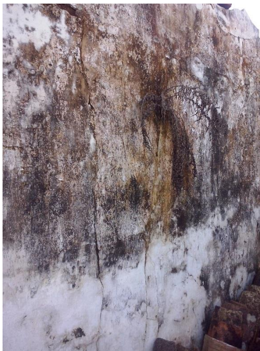
Figura 15– Desenvolvimento de vegetação e umidade
