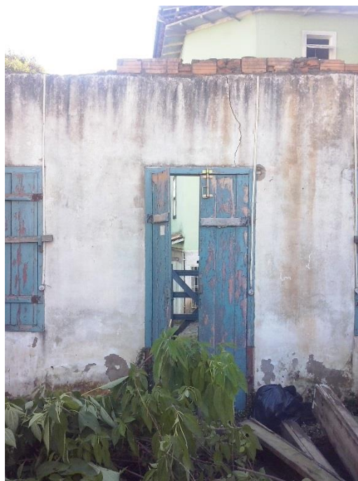
Figura 21 – Trinca acima da porta de acesso.
