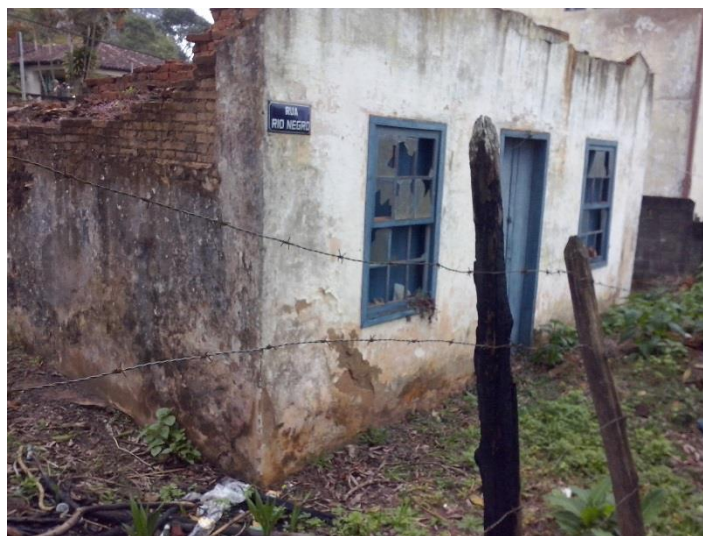
Figura 13 –Acumulo de entulho e vegetação no terreno
