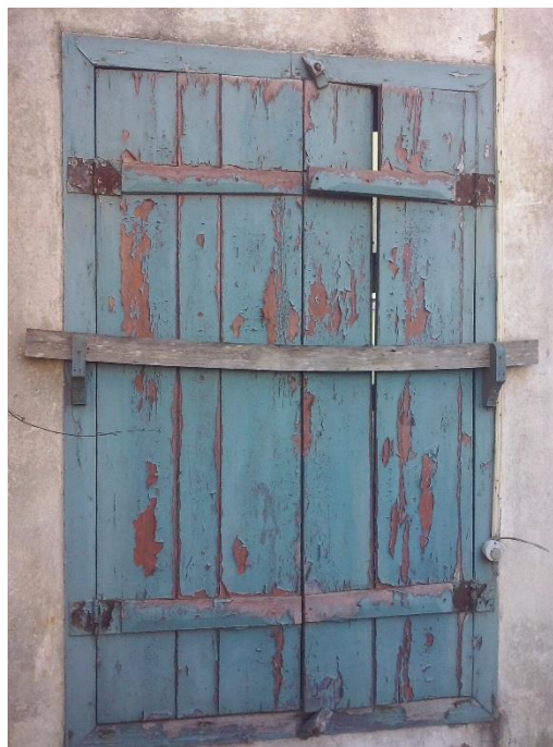
Figura 20 – Esquadria com desgaste na
