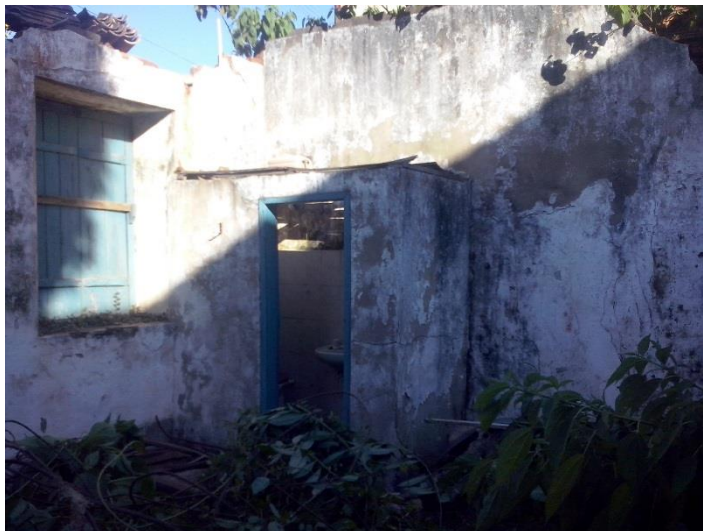
Figura 11 – Banheiro da edificação
