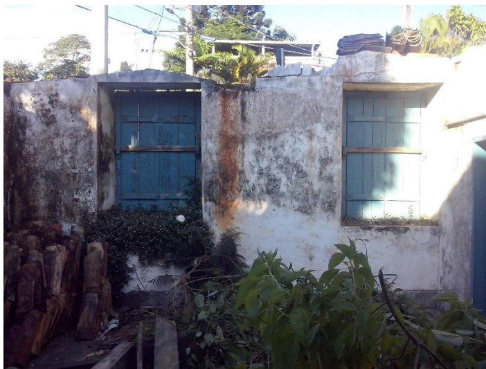
Figura 25 – Desenvolvimento de vegetação dentro da edificação
