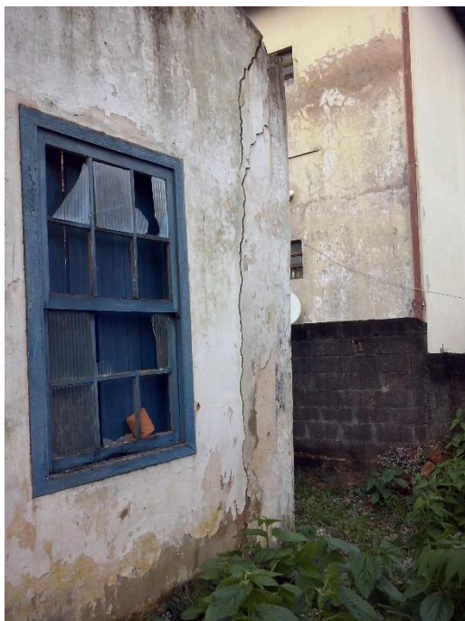
Figura 19 – Esquadria com vidros quebrados
