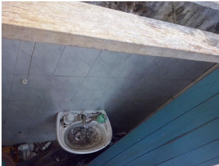
Figura 26 – Acumulo de sujeira na pia do banheiro
