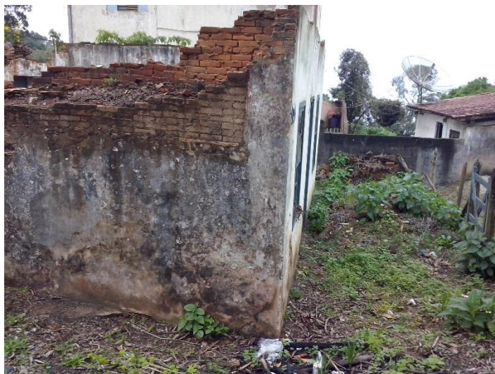
Figura 5 –Alvenaria de tijolo de barro
