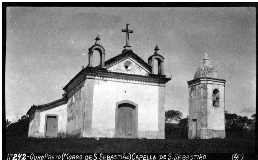
Figura 3 – Foto antiga da Capela de São Sebastião.
