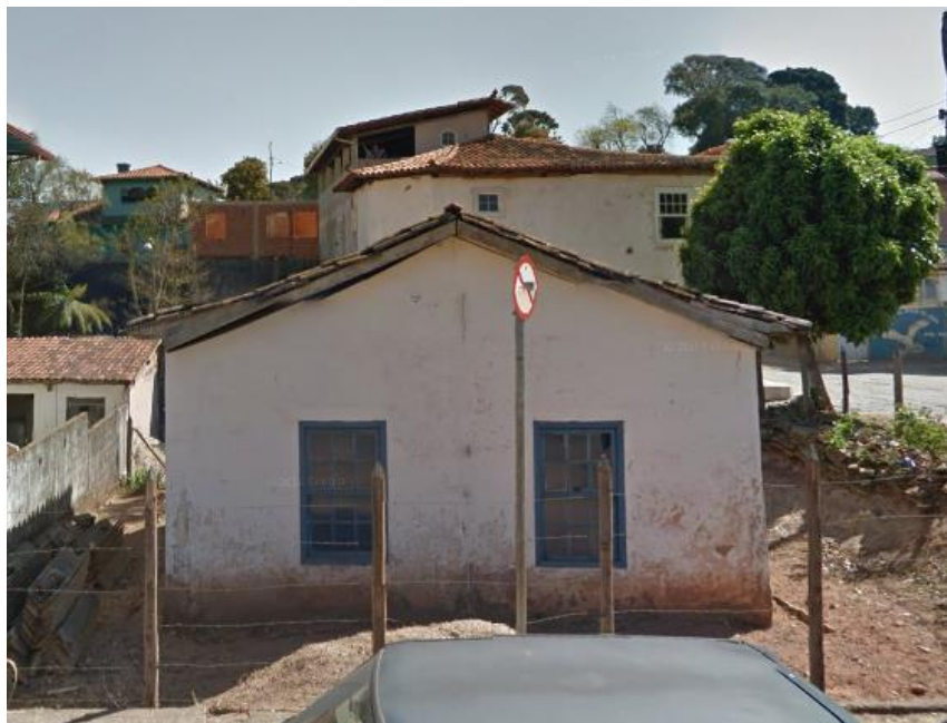
Figura 12 – Foto da edificação antes do arruinamento
