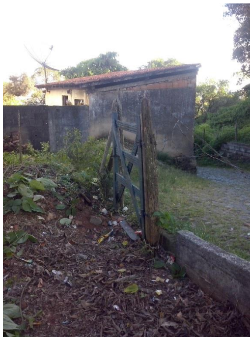
Figura 10 –Portão de acesso ao terreno
