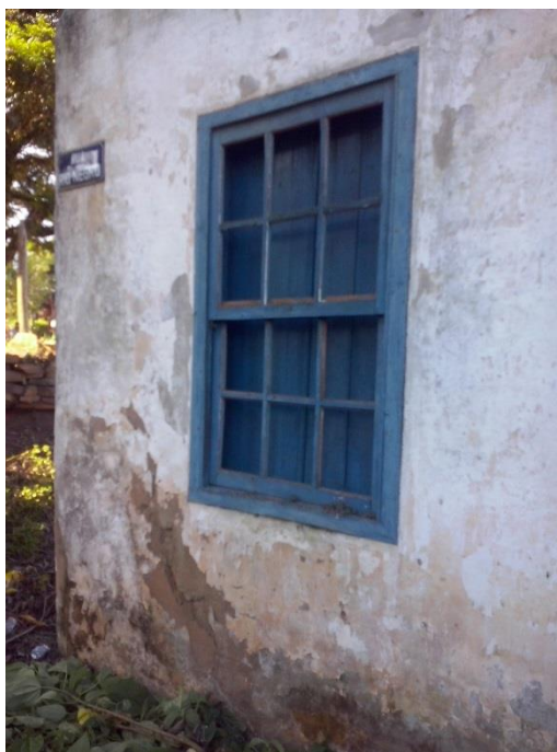
Figura 16 – Destacamento de placas de reboco
