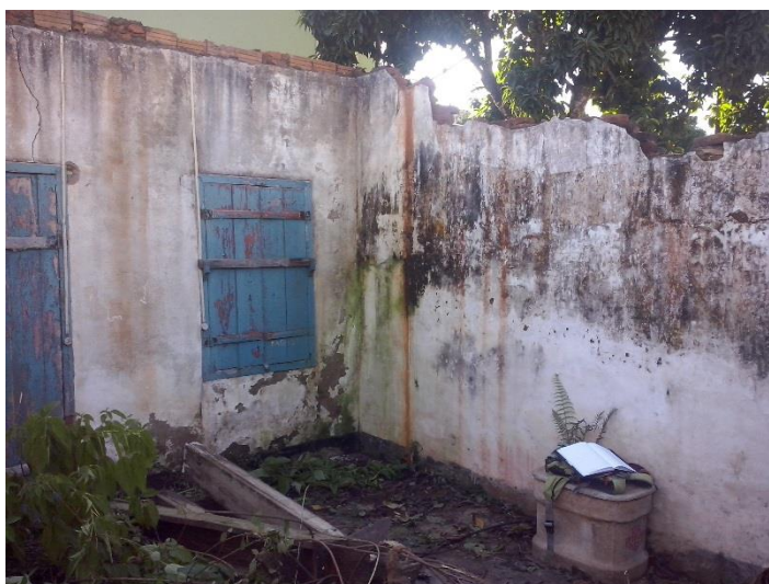
Figura 18 – Aumento de patologias próximo a transição de técnicas construtivas
