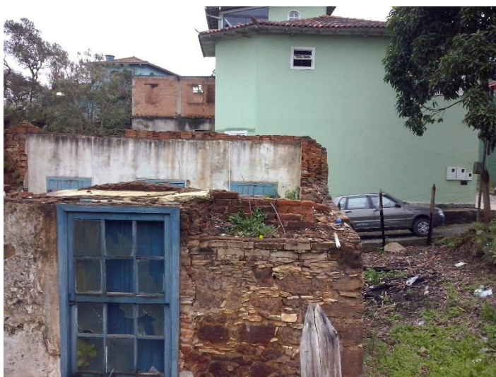
Figura 17 – Fiadas de tijolo nas paredes arruinadas
