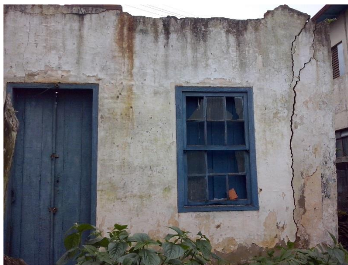
Figura 23 – Rachadura próxima a lateral direita da edificação
