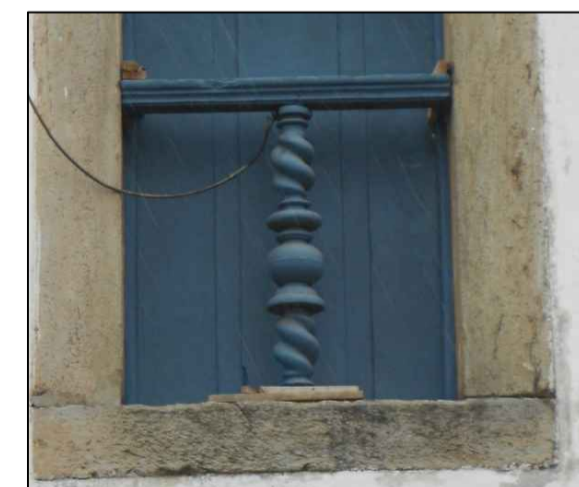
F - PERDA DE MATERIAL COM FORMAÇÃO DE LACUNAS, INTERVENÇÃO INADEQUADA
