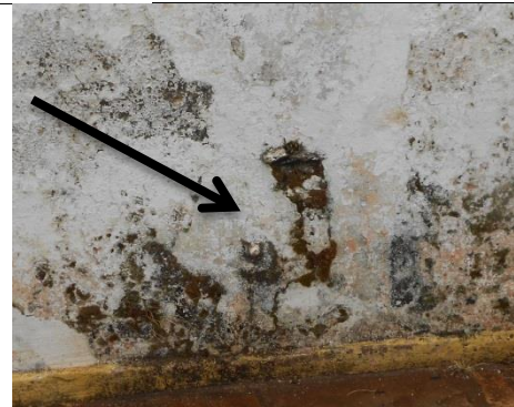
b) Mancha enegrecida, descascamento da camada pictórica e mancha de umidade (fachada posterior)
