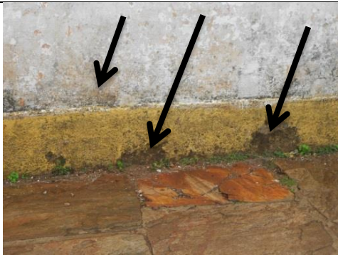
a) Mancha de umidade e perda localizada de reboco (fachada lateral esquerda)
