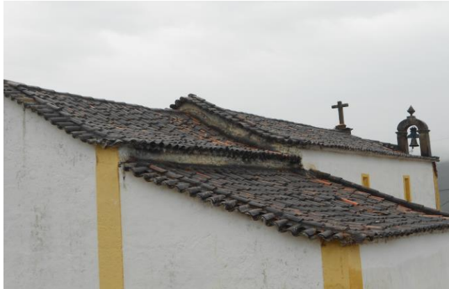
Figura 20: Vista parcial do telhado Fonte: Autora, 2014
