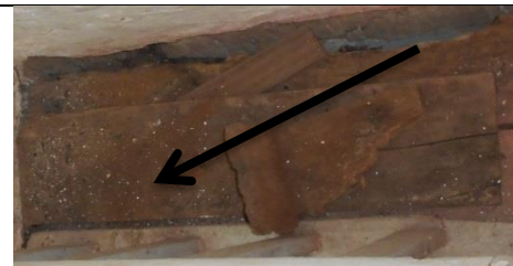
b) Perda de material ,presença de umidade e apodrecimento da madeira(piso do coro)
