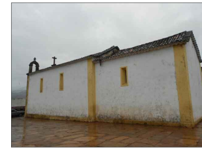
D - FACHADA LATERAL ESQUERDA COM PRESENÇA DE SUJIDADE, DESCASCAMENTO DA CAMADA PICTÓRICA, MANCHA DE UMIDADE DESCENDENTE
