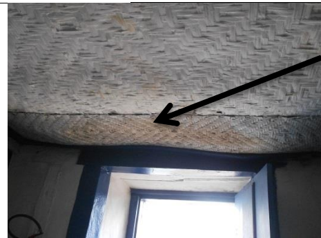
b) Abaulamento (forro da sacristia)
