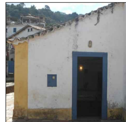
A - MANCHA DE ENEGRECIDA, DESGASCAMENTO DA CAMADA PICTÓRICA, VEGETAÇÃO SUPERIOR DE PEQUENO PORTE, TELHAS QUEBRADAS
