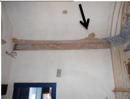
a) Descascamento da camada pictórica (forro capela mor)
