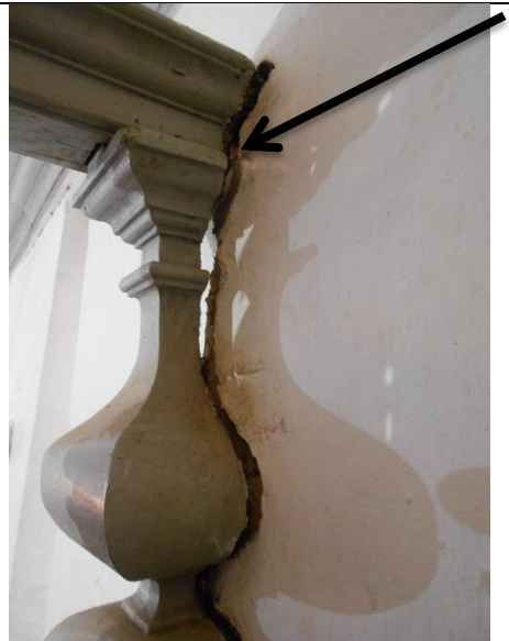
b) Desprendimento da madeira (balaustrada do coro)
