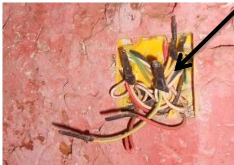
a) Fiação Irregular (parede interna do depósito)
