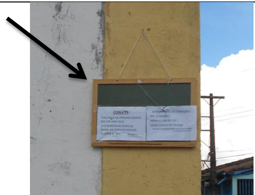
b) Uso inadequado (fachada lateral direita)
