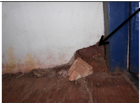
b) Desprendimento de argamassa (parede interna acesso ao coro)
