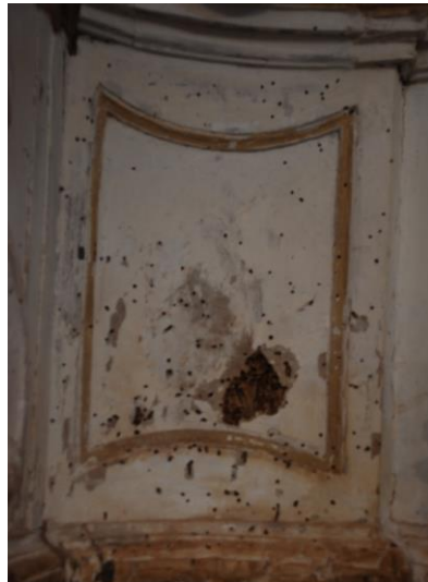
Figura 27: Detalhe do retábulo ataque de xilófagos Fonte: Autora/2014
