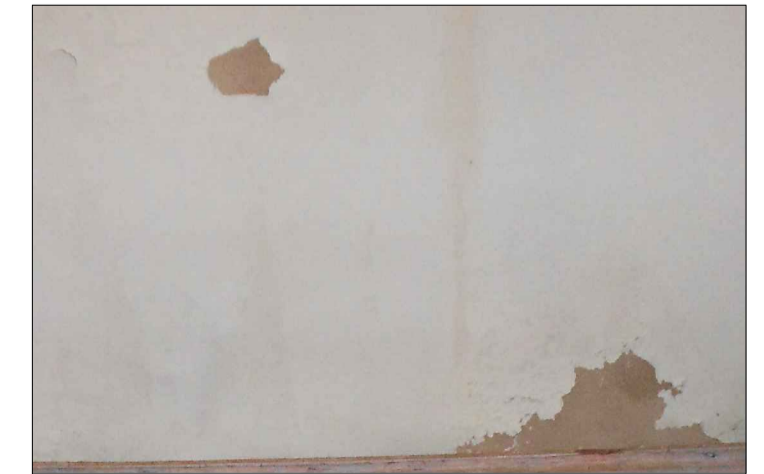
A - DESCASCAMENTO DA CAMADA PICTÓRICA
