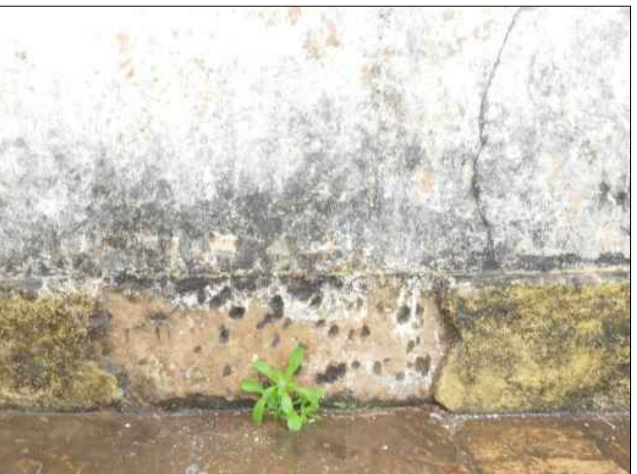
C - PRESENÇA DE VEGETAÇÃO INFERIOR DE PEQUENO PORTE, DESTACAMENTO LOCALIZADO DO REBOCO
