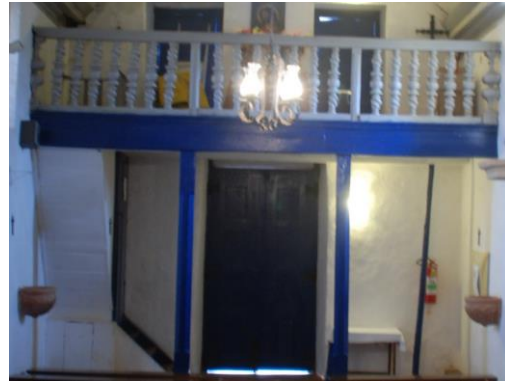
Figura 26: Vista do guarda corpo do coro Fonte: Autora/2014
