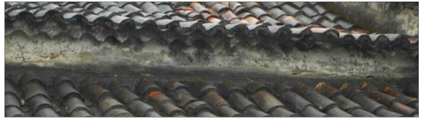
A - MANCHA ENEGRECIDADA, DESCASCAMENTO, DESPRENHEMENTO DA CAMADA PICTÓRICA, FALTA DE ARRIMAÇÃO NAS TELHAS, PEÇAS QUEBRADAS E DESLOCADAS, FISSURAMENTO, DESPRENHEMENTO DE ARGAMASSA
