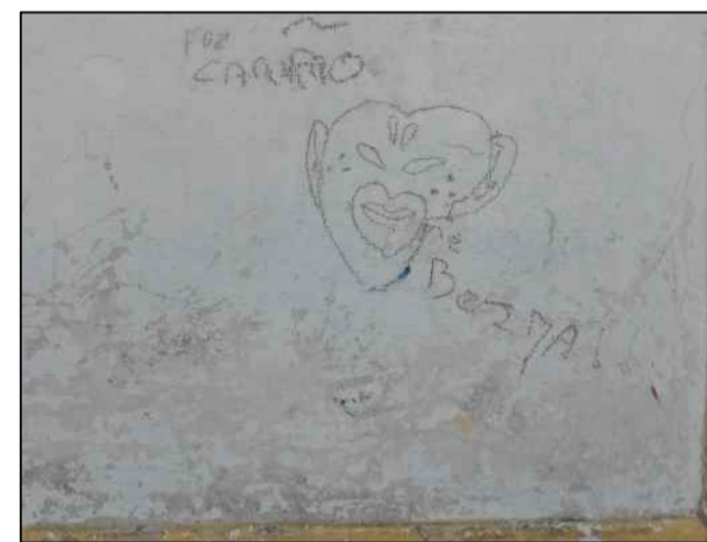
C - PICHÇÃO, DESGASCAMENTO DA CAMADA PICTÓRICA
