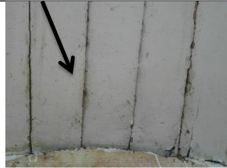
b) Descascamento da camada pictórica e sujeira (forro do coro)
