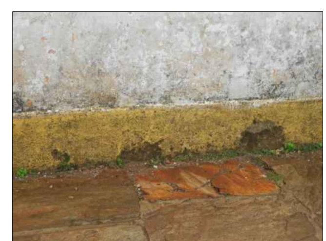
B - PRESENÇA DE VEGETAÇÃO INFERIOR DE PEQUENO PORTE, DESTACAMENTO LOCALIZADO DO REBOCO
