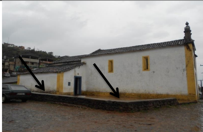
Descascamento da camada pictórica e mancha de umidade (fachada lateral direita)
