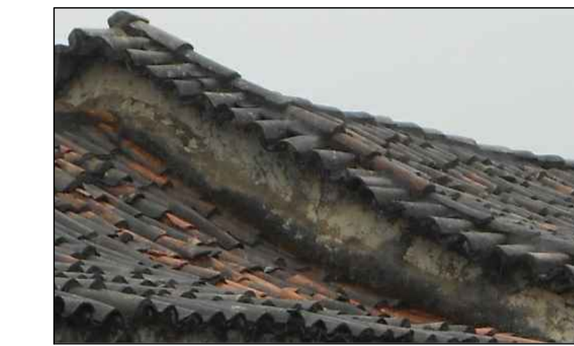
A - MANCHA ENEGRECIDA DESESCENTE, DESGASCAMENTO DA CAMADA PICTÓRICA, FALTA DE AMARRAÇÃO NAS TELHAS, PEÇAS QUEBRADAS E DESLOCADAS, FISSURAMENTO, DESPRENDIMENTO DE ARGAMASSA DE REBOCO
