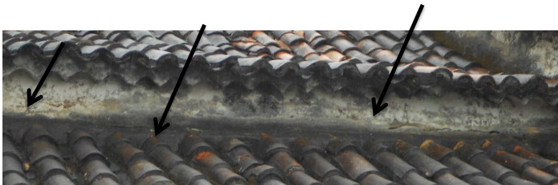
Mancha enegrecida e descascamento da camada pictórica, telhas quebradas e deslocadas, fissuramento e desprendimento de argamassa (fachada lateral direita)
