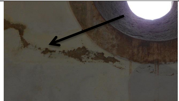
b) Descascamento da camada pictórica (parede interna do coro)
