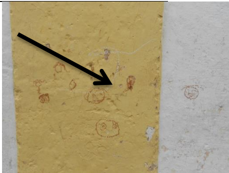
a) Pichação (fachada posterior)
