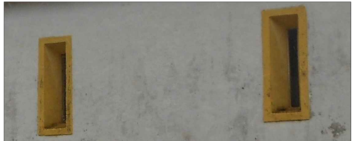
B - MANCHA DE ENEGRECIDADA, DESTACAMENTO DA CAMADA PICTÓRICA
