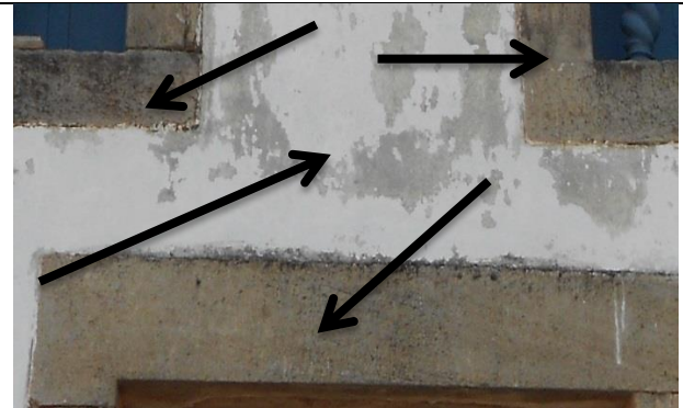
b) Pitting (picadura) e descascamento da camada pictórica (fachada principal)
