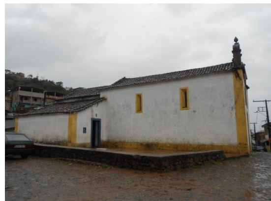
Figura 18: Foto atual da Capela da Piedade Fonte: Autora, 2014
