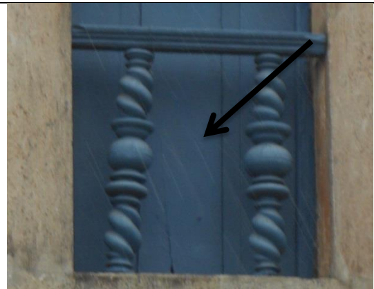
b) Perda de material (fachada principal)
