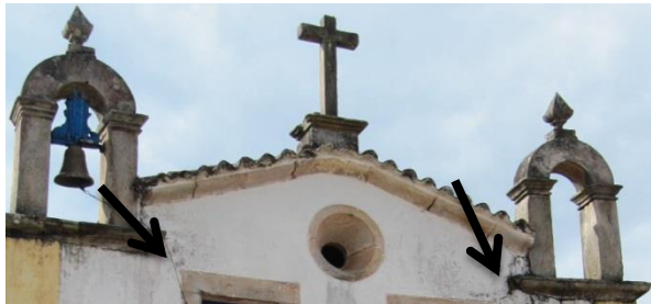
a) Mancha enegrecida e mancha de sujeira (fachada principal)
