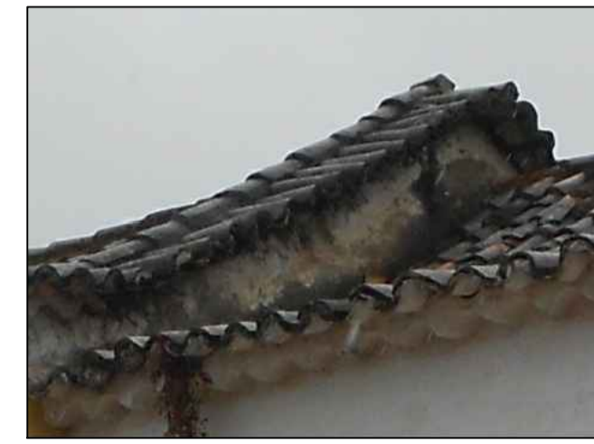
B - MANCHA ENEGRECIDA DESESCENTE, DESGASCAMENTO DA CAMADA PICTÓRICA, FALTA DE AMARRAÇÃO NAS TELHAS, PEÇAS QUEBRADAS E DESLOCADAS, FISSURAMENTO, DESPRENDIMENTO DE ARGAMASSA
