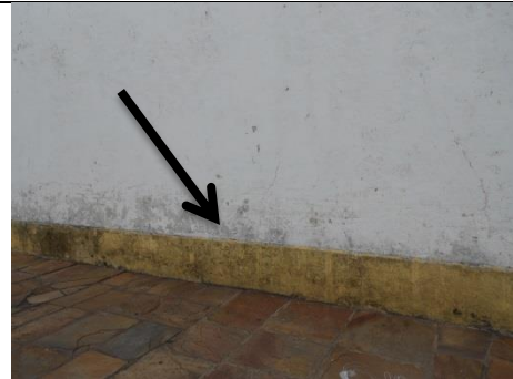
b) Mancha de umidade e desprendimento da camada pictórica (fachada lateral direita)
