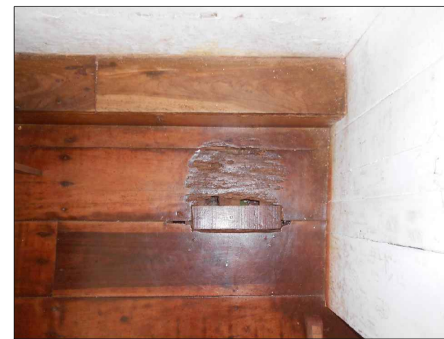
A - INTERVENÇÃO INACABADA/APRODERECIMENTO DO MADEIRA/PERDA DE MATERIAL
