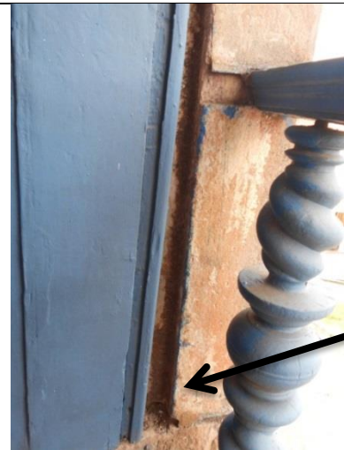
b) Descolamento de esquadria (janela fachada principal)
