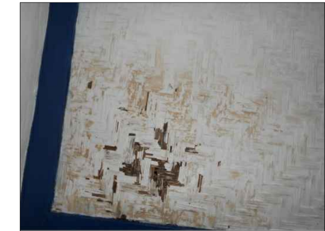
B - DESCASCAMENTO DA CAMADA PICTÓRICA, MANCHA DE UMIDADE DESCENDENTE
