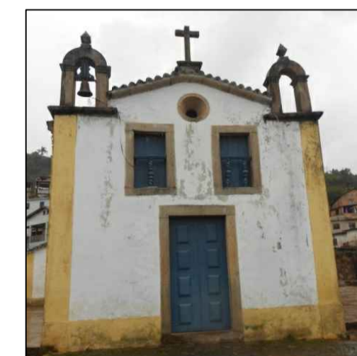
D - MANCHA DE UMIDADE, DESGASCAMENTO DA CAMADA PICTÓRICA
