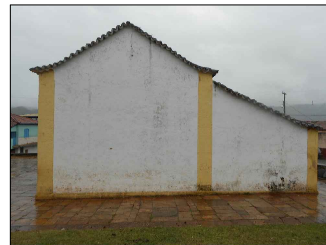
C - FACHADA POSTERIOR COM PRESENÇA DE SUJIDADE, DESGASCAMENTO DA CAMADA PICTÓRICA
