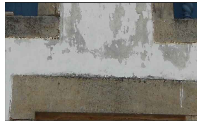
B - PITING, DESGASCAMENTO DA CAMADA PICTÓRICA
