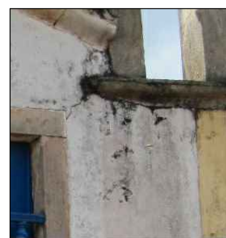
H - PERDA DE MATERIAL COM FORMAÇÃO DE LACUNAS
