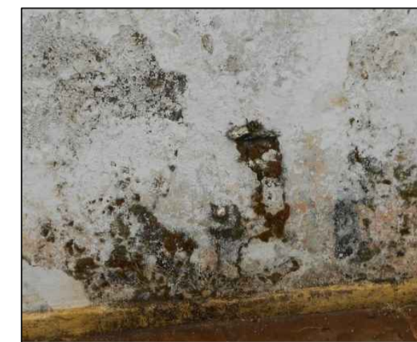
D - MANCHA ENEGRECIDA, DESGASCAMENTO DA CAMADA PICTÓRICA E MANCHA DE UMIDADE ASCEDENTE
