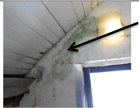
b) Mancha de umidade descendente (parede interna do coro)
