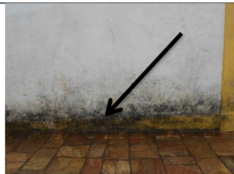
b) Mancha de umidade (fachada lateral direita)
