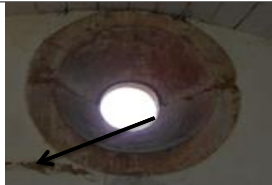
b) Umidade descendente, sujidade e descascamento da camada pictórica (parede interna do coro)
