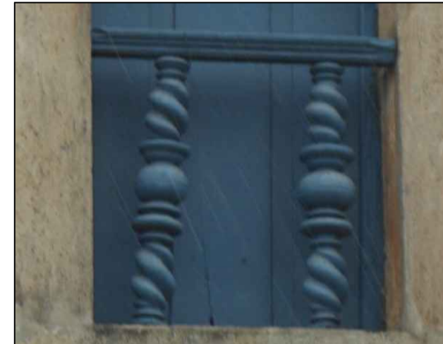
E - PERDA DE MATERIAL COM FORMAÇÃO DE LACUNAS
