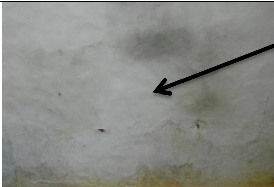
a) Sujidade (parede interna da capela mor)
