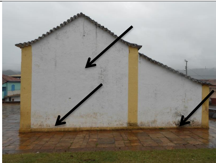
Descascamento da camada pictórica e mancha de umidade (fachada posterior)
