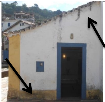
b) Vegetação aérea e mancha de umidade (fachada principal)
