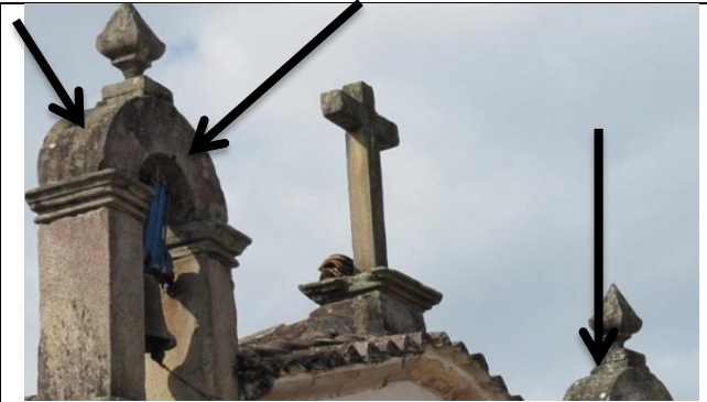
b) Mancha enegrecida, pátina biológica e porosidade (fachada principal)
