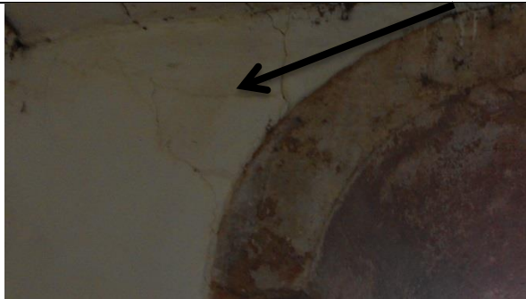
a) Fissuras (parede interna do coro)
