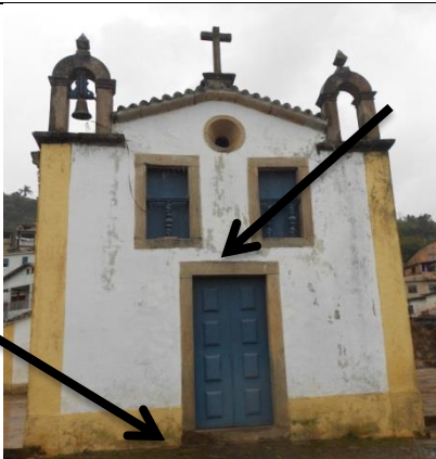
a) Descascamento da camada pictórica e mancha enegrecida (fachada principal)
