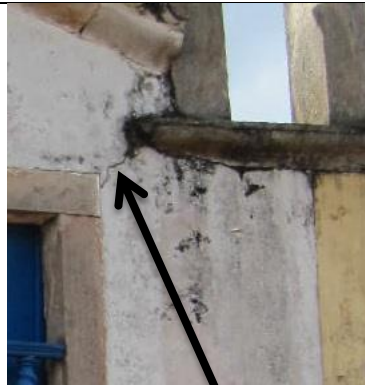
a) Fissura e mancha enegrecida (fachada principal)
