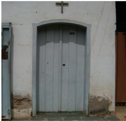
Foto 02 – A Fachada Principal, apresenta desprendimento de argamassa, perda da camada pictórica, trincas.
