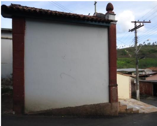
Foto 04 -A Fachada Lateral Esquerda, apresenta perda da camada pictórica, manchas de umidade.
