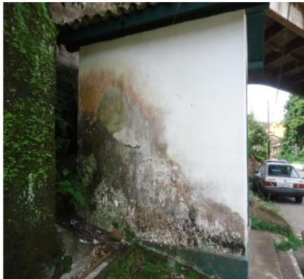
Foto 04 –A Fachada Lateral Esquerda, apresenta vegetação, manchas de umidade, trincas, mofo, perda da camada pictórica.
