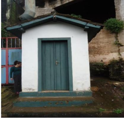
Foto 02 –A Fachada Principal apresenta manchas de umidade, perda da camada pictórica, desprendimento de argamassa.
