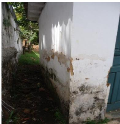
Foto 04 - A Fachada Lateral Esquerda, apresenta manchas de umidade, desprendimento de argamassa, bolor, vegetação.
