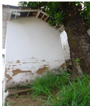
Foto 05 - A Fachada de Fundos, apresenta desprendimento de argamassa, manchas de umidade, vegetação, mofo.
