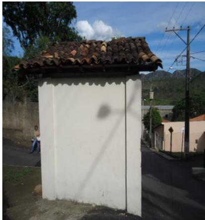
Foto 04 - A Fachada Lateral Esquerda, apresenta manchas de umidade, vegetação, trincas.
