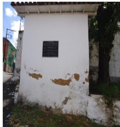
Foto 03 - A Fachada Lateral Direita, apresenta desprendimento de argamassa, perda da camada pictórica, vegetação, manchas de umidade.
