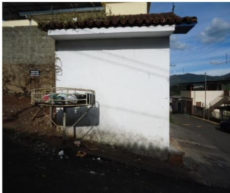
Foto 04 - A Fachada Lateral Esquerda apresenta manchas de umidade e vegetação
