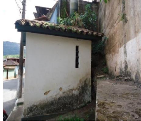
Foto 03 –A Fachada Lateral Direita, apresenta, manchas de umidade, desprendimento de argamassa, perda da camada pictórica, trincas.
