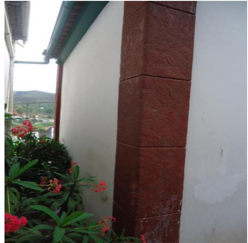
Foto 03 -A Fachada Lateral Direita, apresenta manchas de umidade e vegetação.
