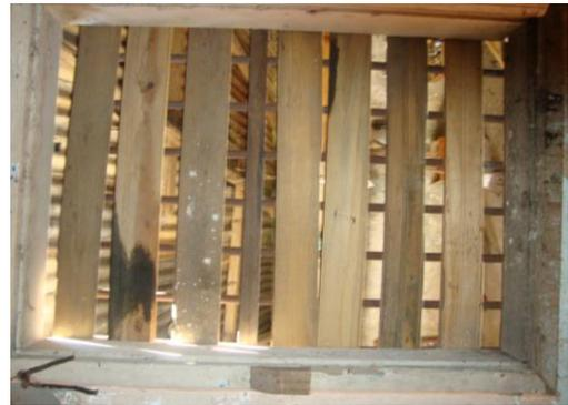
FIGURA 35: Porão - Janela de madeira com gradil.
