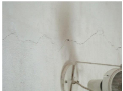
Figura 154: Rachaduras. Fonte: Camila Pereira, 2016.
