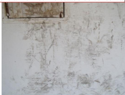
Figura 112: Sujidade nas paredes Fonte: Camila Pereira, 2016.
