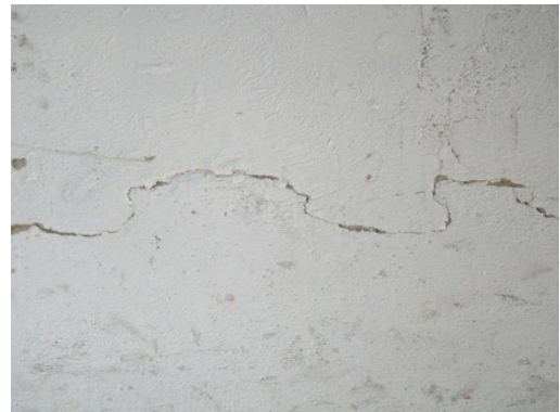
Figura 93: Rachaduras. Fonte: Camila Pereira, 2016.
