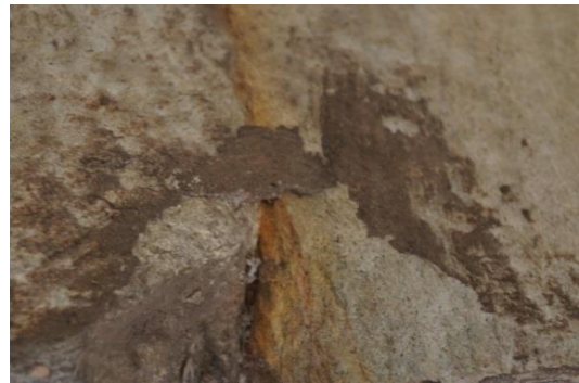
Figura 32: Argamassa cimentíssia na pedra. Fonte: Camila Pereira, 2016.
