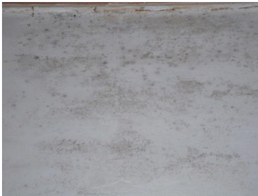
Figura 126: Mancha de umidade. Fonte: Camila Pereira, 2016.
