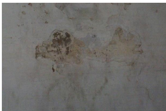
Figura 137: Perda da camada de pintura. Fonte: Camila Pereira, 2016.
