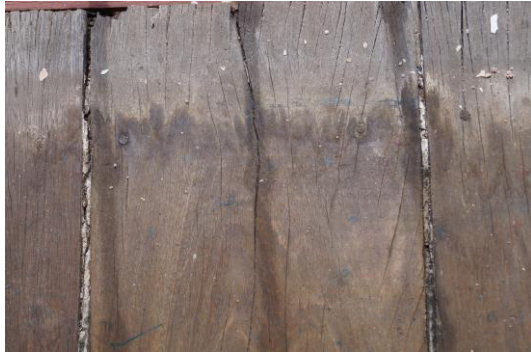
Figura 139: Manchas de água da chuva no assoalho. Fonte: Camila Pereira, 2016.
