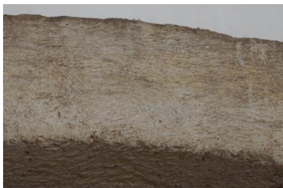
Figura 40: Sujidade na pedra. Fonte: Camila Pereira, 2016.
