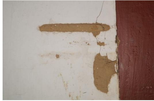
Figura 140: Perda de reboco, ocasionado pelo contato do trinco com a parede. Fonte: Camila Pereira, 2016.
