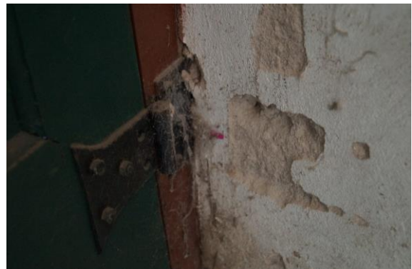
Figura 149: Perda de reboco. Fonte: Camila Pereira, 2016.
