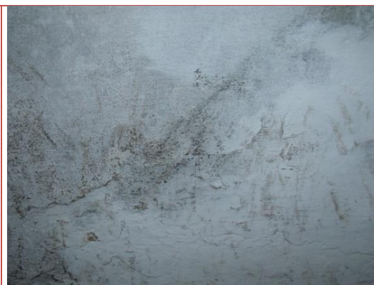
Figura 18: Sujidade nas paredes do nartex. Fonte: Camila Pereira, 2016.
