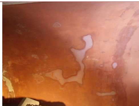
Figura 36: Manchas de umidade nas paredes. Fonte: Camila Pereira, 2016.
