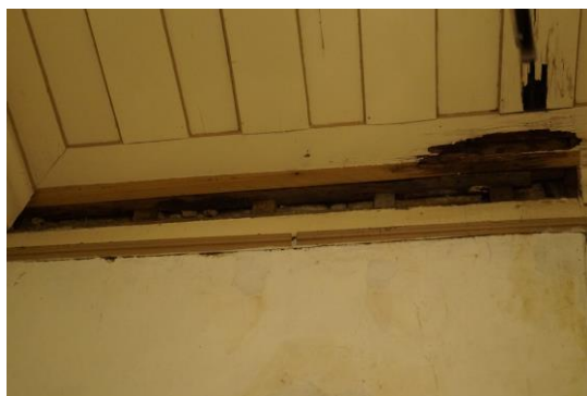
Figura 51: Perda de suporte do forro do Cômodo dos passos.
