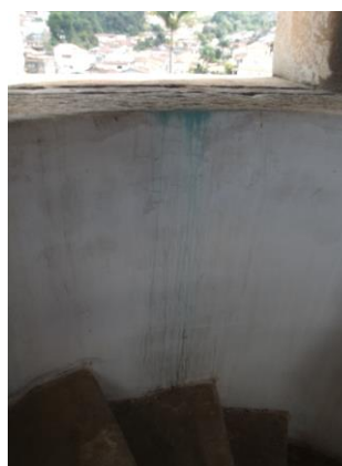
Figura 43: Manchas de escoamento de água na parede. Fonte: Camila Pereira, 2016.
