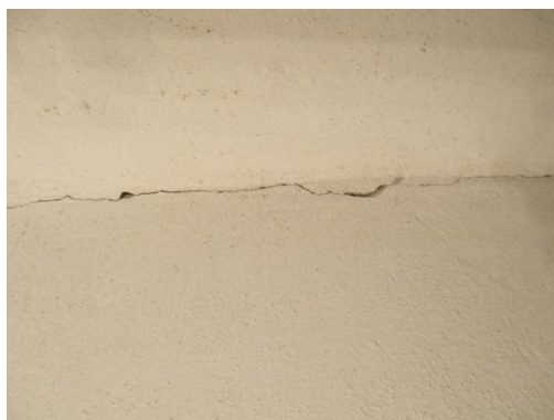
Figura 50: Rachadura. Fonte: Camila Pereira, 2016.
