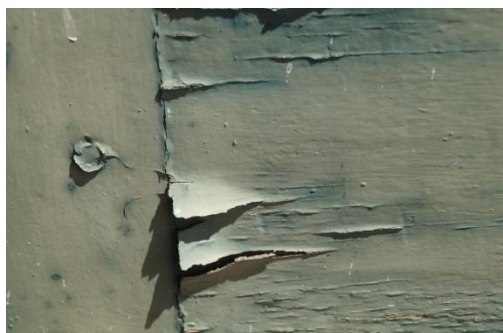
Figura 146: Ressecamento da camada de pintura da janela, em madeira. Fonte: Camila Pereira, 2016.
