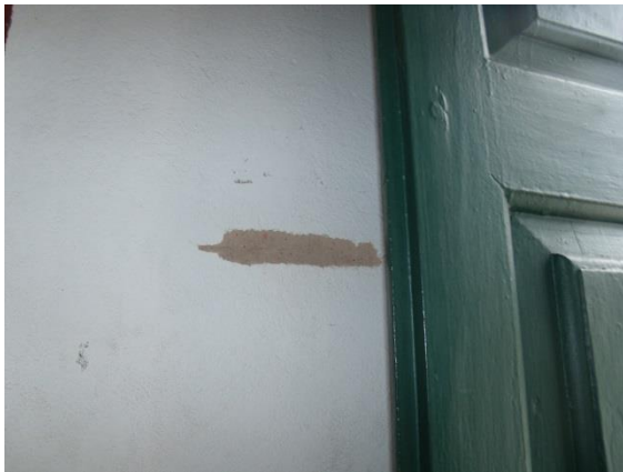
Figura 83: Perda de reboco, ocasionado pelo contato do trinco com a parede. Fonte: Camila Pereira, 2016.
