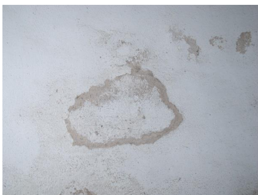
Figura 42: Perda da camada de pintura. Fonte: Camila Pereira, 2016.
