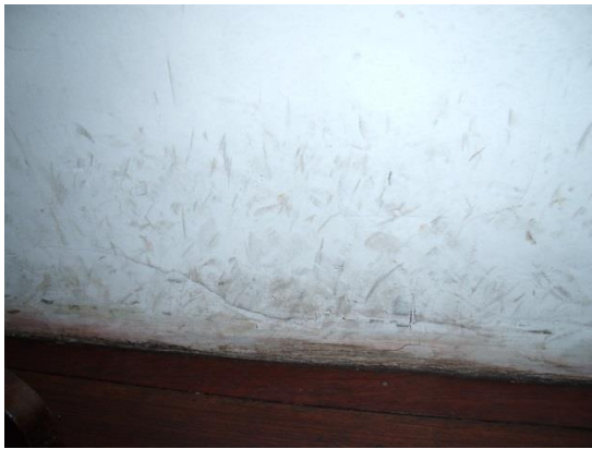
Figura 105: Sujidade nas paredes. Fonte: Camila Pereira, 2016.
