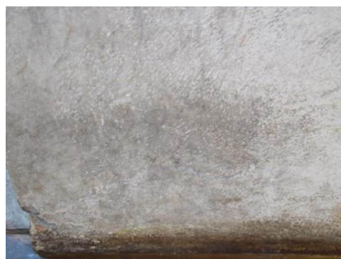
Figura 88: Sujidade nas paredes. Fonte: Camila Pereira, 2016.
