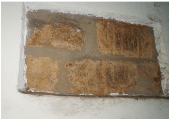
Figura 67: Detalhe da alvenaria em adobe. Fonte: Camila Pereira, 2016.
