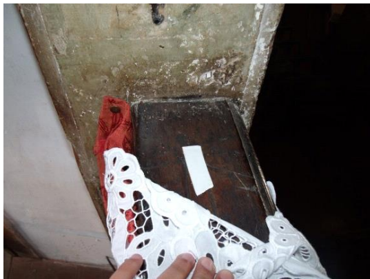
Figura 128: Fita adesiva na balaustrada. Fonte: Camila Pereira, 2016.
