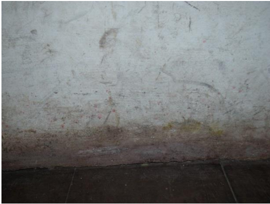
Figura 56: Sujidade na parede. Fonte: Camila Pereira, 2016.
