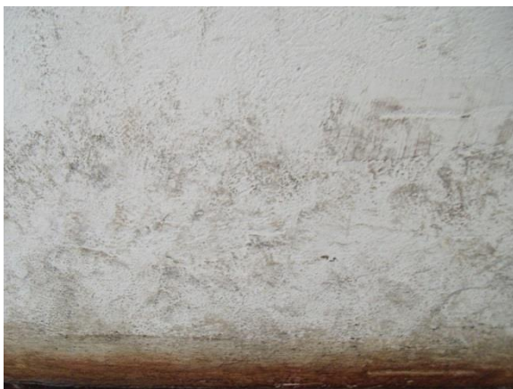
Figura 85: Sujidade na parede. Fonte: Camila Pereira, 2016.
