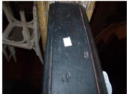
Figura 156: Fita adesiva na balastrada. Fonte: Camila Pereira, 2016.
