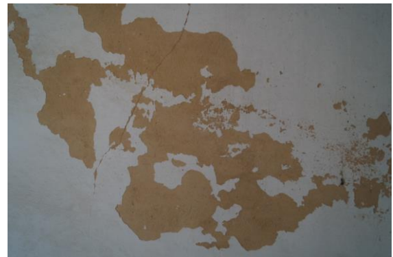
Figura 127: Perda de camada de pintura. Fonte: Camila Pereira, 2016.
