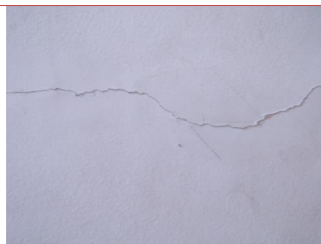
Figura 113: Rachadura Fonte: Camila Pereira, 2016.
