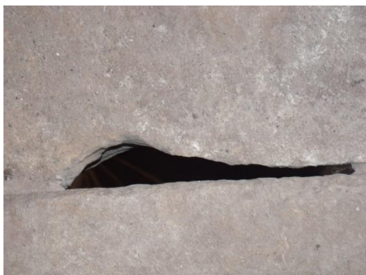
Figura 38: Perda pontual de suporte em pedra do degrau da escada. Fonte: Camila Pereira, 2016.
