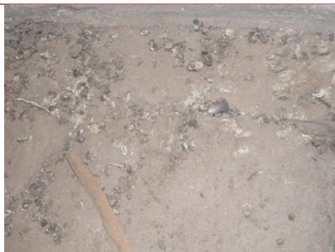
Figura 35: Fezes de pombo na torre da lateral direita. Fonte: Camila Pereira, 2016.
