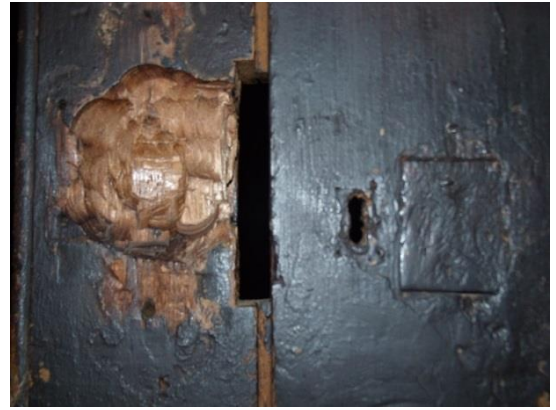
Figura 57: Perda pontual de suporte (madeira) da porta. Fonte: Camila Pereira, 2016.
