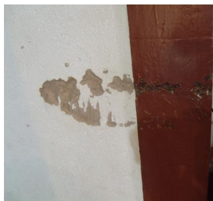
Figura 79: Perda de reboco, ocasionado pelo contato do trinco da porta, com a parede.
