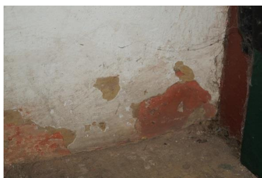
Figura 145: Perda da camada de pintura. Fonte: Camila Pereira, 2016.
