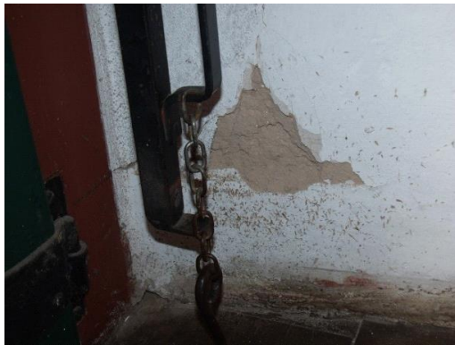
Figura 101: Perda de reboco, ocasionado pelo contato do trinco da Janela, com a parede. Fonte: Camila Pereira, 2016.
