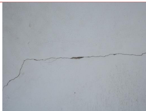
Figura 97: Rachadura. Fonte: Camila Pereira, 2016.
