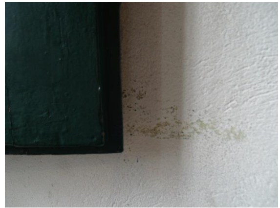
Figura 84: Resquícios de tinta, ocasionado pelo contato da janela com a parede. Fonte: Camila Pereira, 2016.
