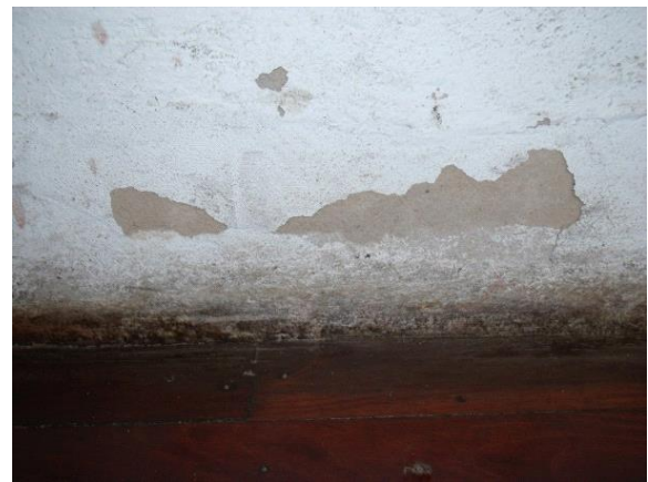
Figura 86: Perda da camada de pintura. Fonte: Camila Pereira, 2016.
