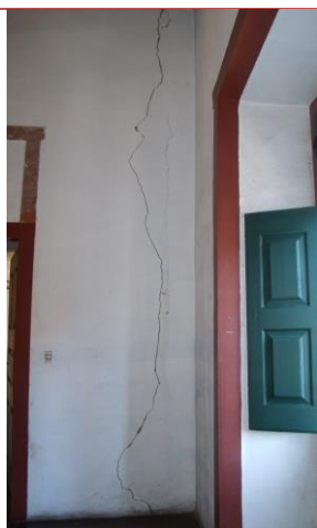
Figura 121: Rachadura. Fonte: Camila Pereira, 2016.
