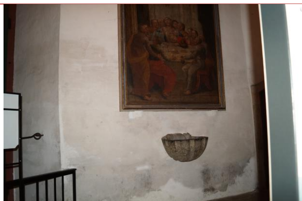
Figura 17: Manchas de umidade nas paredes Fonte: Camila Pereira, 2016.
