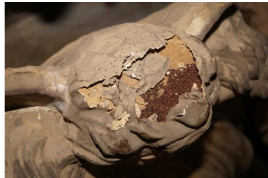
Figura 61: Foco de cupim. Fonte: Camila Pereira, 2016.
