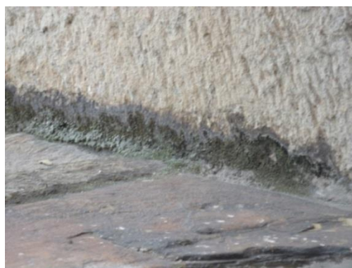
Figura 27: Biofilme na torre da lateral esquerda. Fonte: Camila Pereira, 2016.
