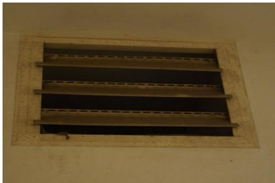
Figura 117: Exaustor. Fonte: Camila Pereira, 2016.
