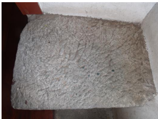
Figura 78: Sujidade nas conversadeiras em cantaria da janela.
