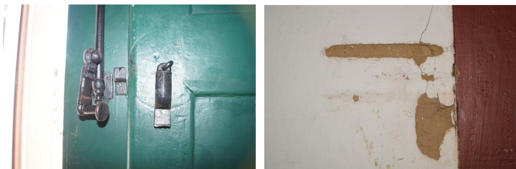
Figuras 157 e 158: Trincos das janelas entram em contato com a parede causando perda de reboco. Fonte: Camila Pereira, 2016.
