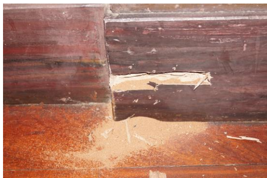
Figura 69: Foco de cupim Fonte: Camila Pereira, 2016.
