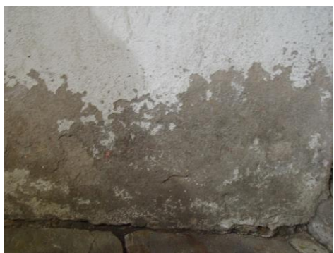
Figura 87: Perda da camada de pintura. Fonte: Camila Pereira, 2016.
