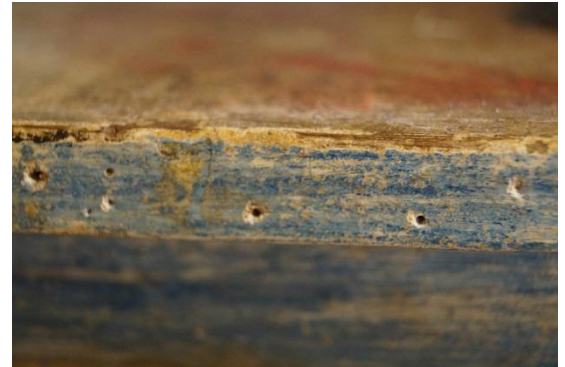
Figura 66: Orifícios causados pelo percevejo. Fonte: Camila Pereira, 2016.
