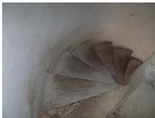
Figura 41: Detalhe da escada. Fonte: Camila Pereira, 2016.
