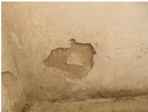
Figura 44: Perda da camada de pintura. Fonte: Camila Pereira, 2016.
