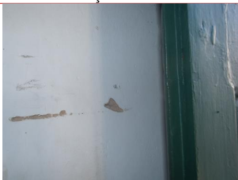
Figura 96: Perda de reboco. Fonte: Camila Pereira, 2016.
