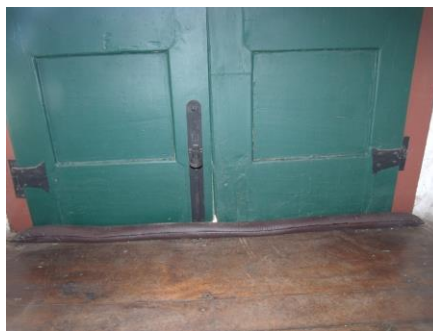
Figura 159: Proteção contra penetração de poluentes atmosféricos, poeira e águas de chuva. Fonte: Camila Pereira, 2016.
