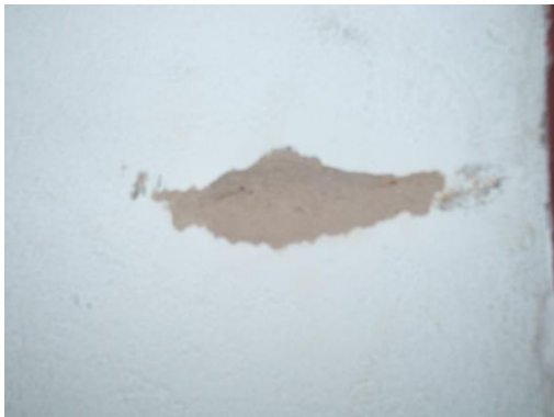
Figura 92: Perda de reboco, ocasionado pelo contato do trinco com a parede. .Fonte: Camila Pereira, 2016.
