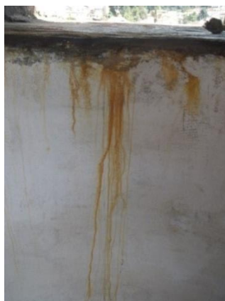
Figura 26: Manchas de água da chuva. Fonte: Camila Pereira, 2016.
