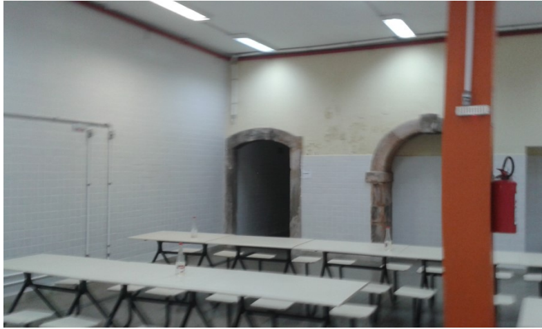
Figura 40- Detalhe de Instalação dos Equipamentos de Combate a Incêndio no Restaurante. Fonte: Arquivo Pessoal 05/05/2017
