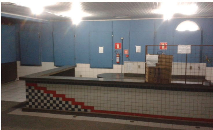
Figura 41- Detalhe de Instalação dos Equipamentos de Combate a Incêndio no Salão de Festas. Fonte: Arquivo Pessoal 05/05/2017
