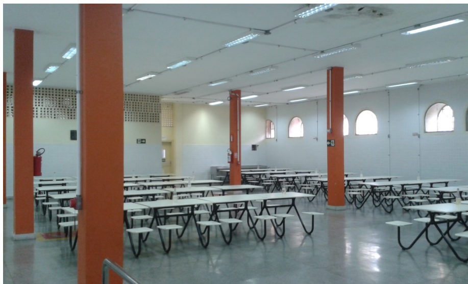
Figura 39- Detalhe de Instalação dos Equipamentos de Combate a Incêndio no Restaurante. Fonte: Arquivo Pessoal 05/05/2017
