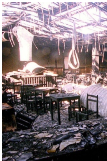
Figura 7-Incêndio no Canecão Mineiro
