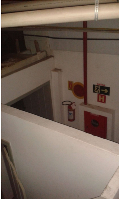
Figura 38- Detalhe de Instalação dos Equipamentos de Combate a Incêndio no Subsolo. Fonte: Arquivo Pessoal 05/05/2017
