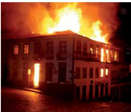
Figura 17- Incêndio no Antigo Hotel do Pilão
