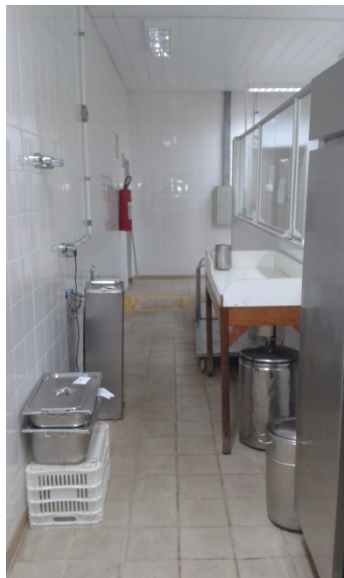
Figura 42 - Detalhe de Instalação do Extintor de Combate a Incêndio na Cozinha do Restaurante. Fonte: Arquivo Pessoal 05/05/2017
