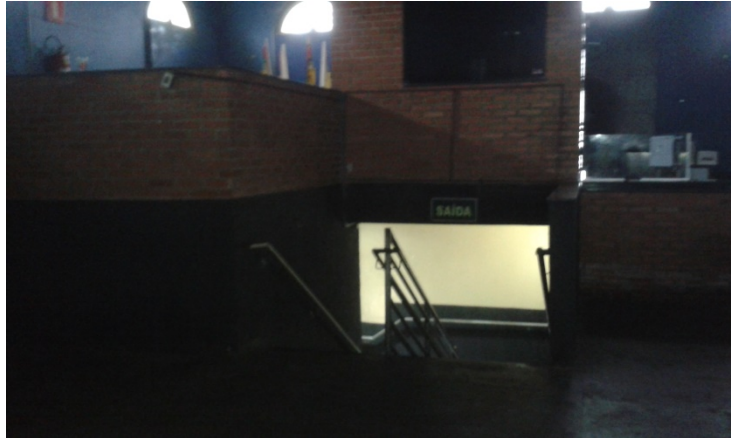
Figura 46- Detalhe de Instalação do Corrimão na Escada Fonte: Arquivo Pessoal 05/05/2017
