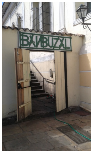
Figura 37 Detalhe da Porta com barras antipânico e abrindo no sentido de fuga Fonte: Arquivo Pessoal 05/05/2017
