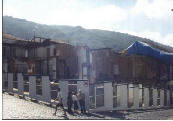
Figura 19- Incêndio no Antigo Hotel do Pilão
