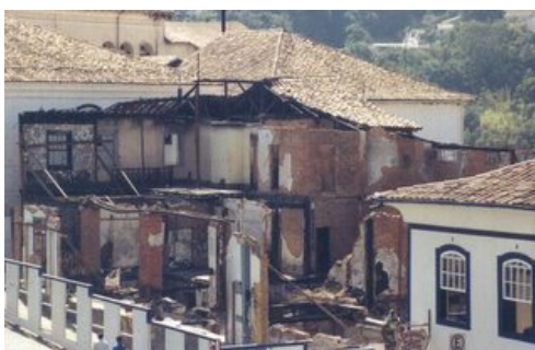
Figura 18- Incêndio no Antigo Hotel do Pilão
