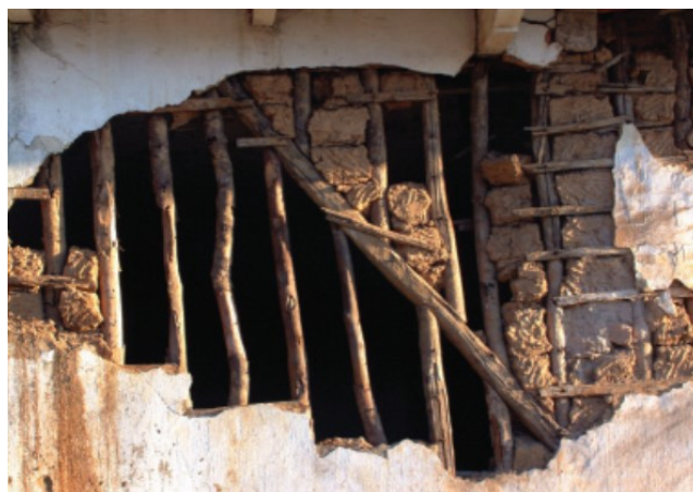
Figura 1-Detalhe de parede em pau a pique Fonte: (GOUVEIA. 2006 ,pag. 37)
