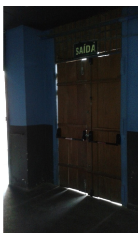
Figura 36 Detalhe da Porta com barras antipânico e abrindo no sentido de fuga Fonte: Arquivo Pessoal 05/05/2017
