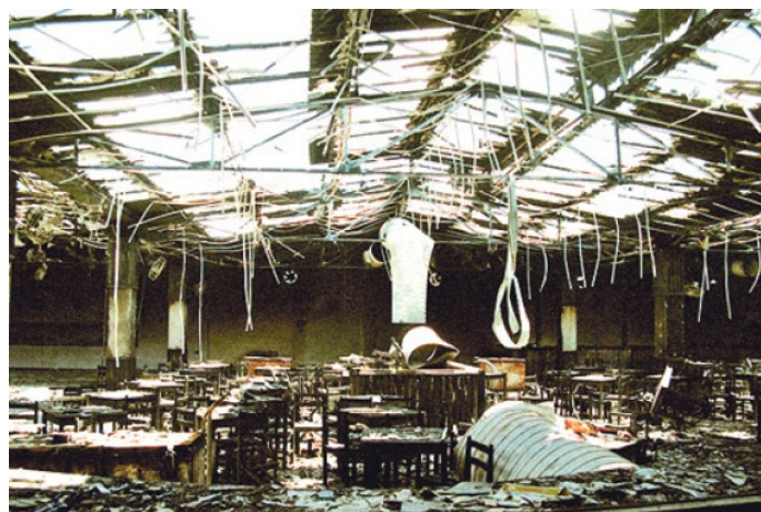
Figura 8- Incêndio no Canecão Mineiro
