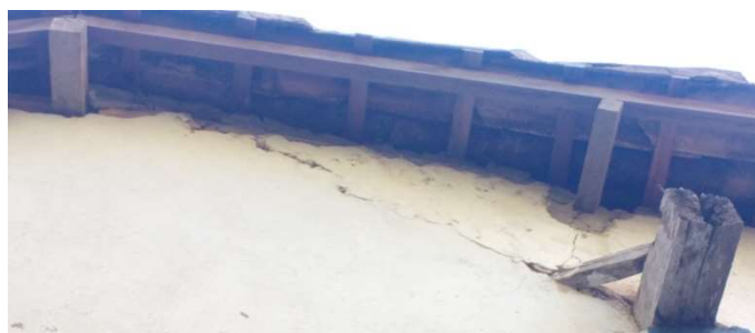
Imagem 64: Trinca na fachada posterior Fonte: Ludmila Ribeiro 28/05/2018
