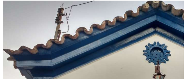
Imagem 62: Detalhe da cimalha após intervenção Fonte: Ludmila Ribeiro 28/05/2018
