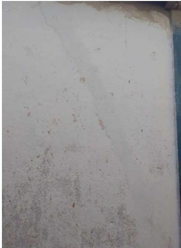
Imagem 70: Fissura no revestimento externo Fonte: Ludmila Ribeiro 28/05/2018
