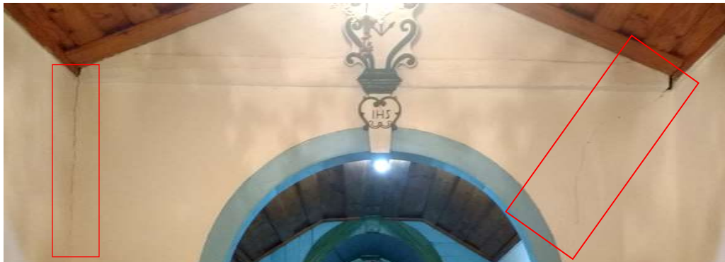
Imagem 63: Trincas descendentes localizadas na parede que divide a nave da capela-mor Fonte: Ludmila Ribeiro 28/05/2018
