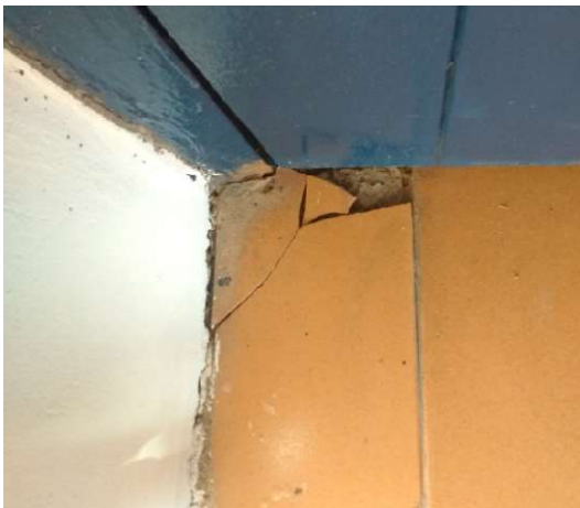
Imagem 77: Fratura na cerâmica Fonte: Ludmila Ribeiro 28/05/2018
