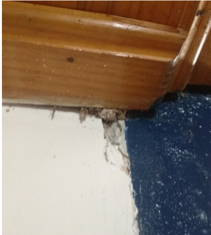
Imagem 68: Fragilidade e descolamento do reboco no interior da capela Fonte: Ludmila Ribeiro 28/05/2018
