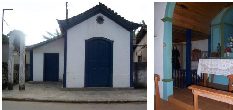
Fachada frontal e parte interna da Capela de Santa Rita
