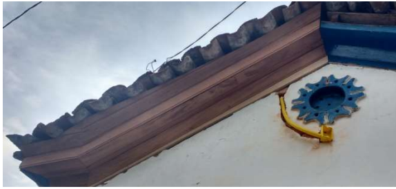
Imagem 61: Detalhe da cimalha em processo de intervenção Fonte: Ludmila Ribeiro 2017
