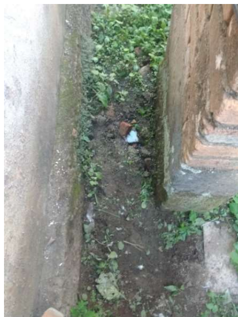
Imagem 92: Umidade causada pelo vazamento da caixa d'água Fonte: Ludmila Ribeiro 28/05/2018
