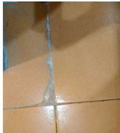
Imagem 78: Desgaste na cerâmica Fonte: Ludmila Ribeiro 28/05/2018
