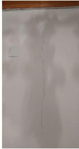
Imagem 71: Fissura no revestimento interno Fonte: Ludmila Ribeiro 28/05/2018
