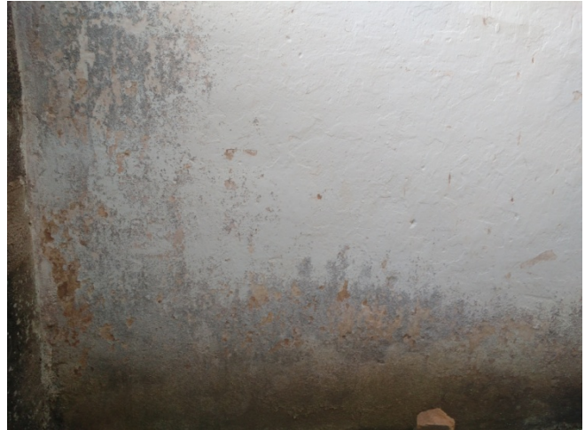
Imagem 69: Fragilidade e descolamento do reboco no exterior da capela Fonte: Ludmila Ribeiro 28/05/2018
