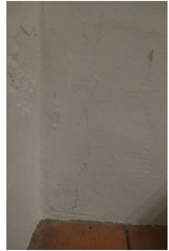
Imagem 72: Fissura no revestimento interno Fonte: Ludmila Ribeiro 28/05/2018
