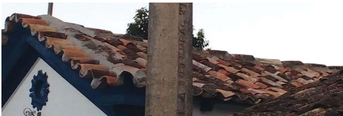
Imagem 59: Detalhe do telhado Fonte: Ludmila Ribeiro 28/05/2018
