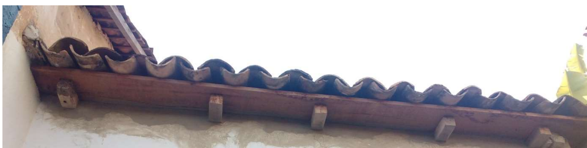
Imagem 60: Detalhe do beiral na fachada lateral direita Fonte: Ludmila Ribeiro 28/05/2018
