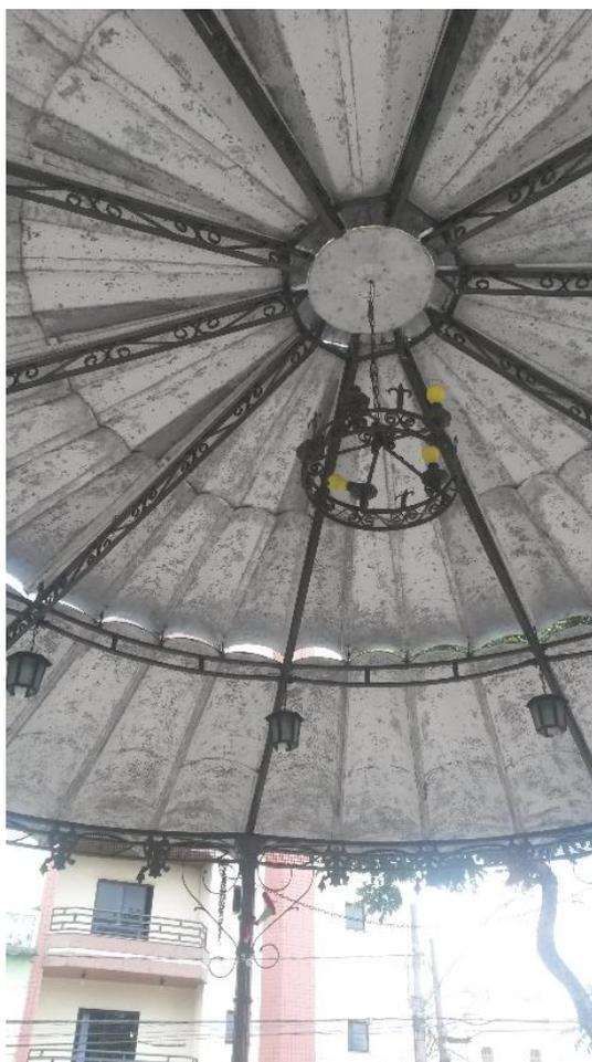
Figura 23 - Cobertura metálica e estruturas em ferro.
