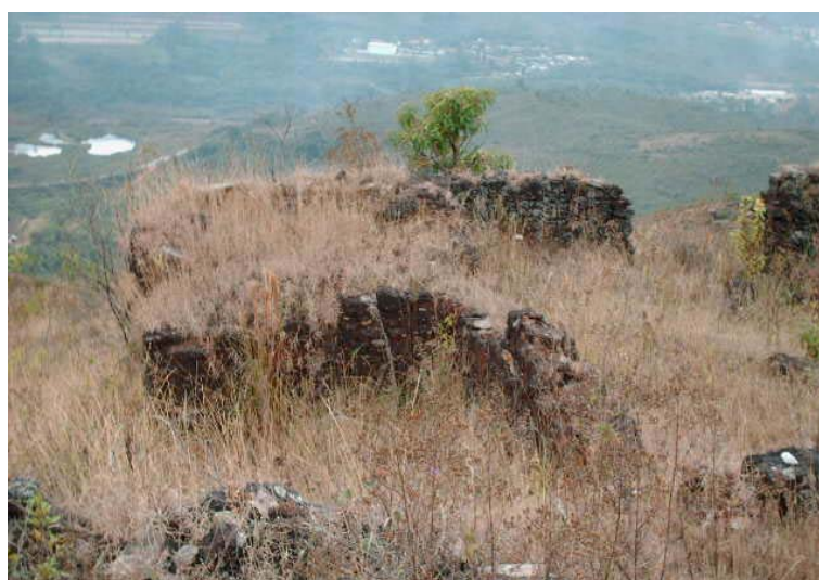
Figura 35: Ruína de edificação encoberta por vegetação Fonte: Foto de Wagner Muniz, 2008
