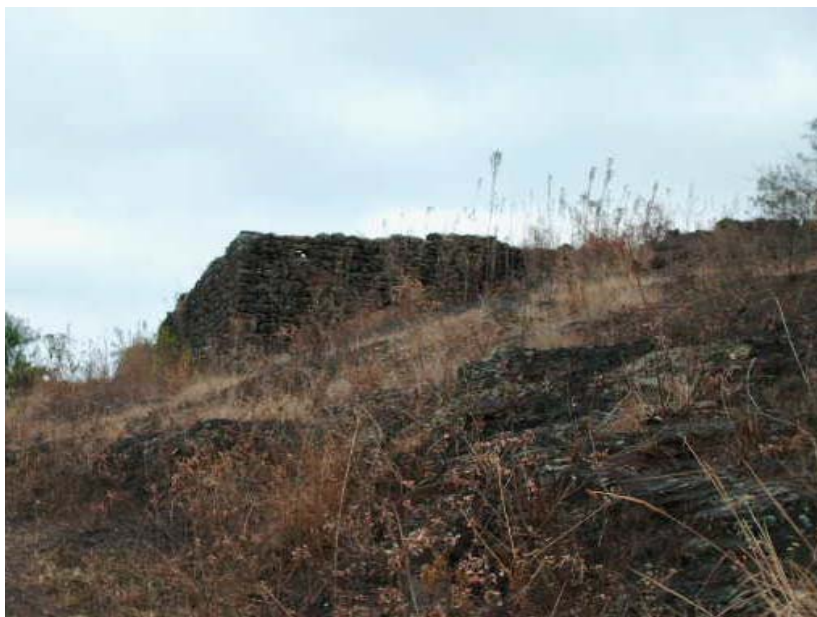
Figura 53: Muro de arrimo Fonte: Foto de Wagner Muniz, 2008
