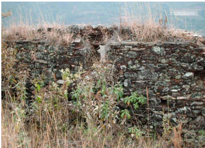
Figura 48: Ruína de alvenaria de habitação Fonte: Foto de Wagner Muniz, 2008
