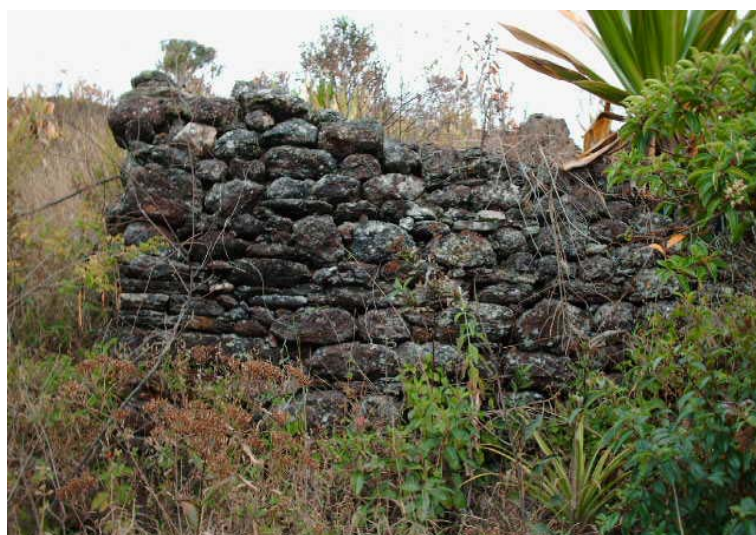
Figura 36: Alvenaria de pedra seca encoberta pela vegetação Fonte: Foto de Wagner Muniz, 2008
