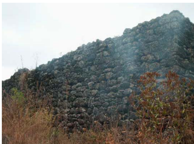
Figura 67: Queimadas que atingiram as ruínas Fonte: Foto de Wagner Muniz, 2008
