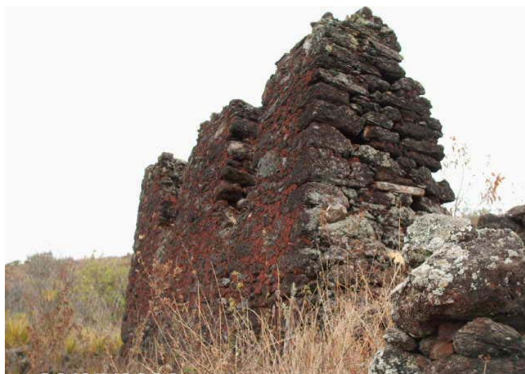
Figura 37: Alvenaria de pedra e barro com revestimento de barro Fonte: Foto de Wagner Muniz, 2008
