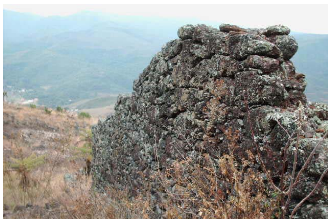
Figura 52: Muro de alvenaria de pedra de canga Fonte: Foto de Wagner Muniz, 2008
