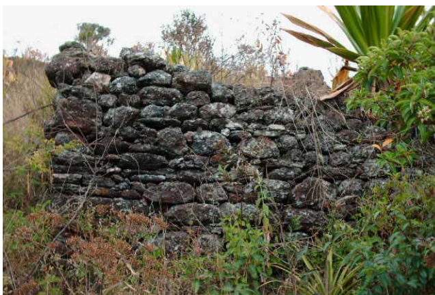
Figura 68: Alvenaria de pedra seca encoberta pela vegetação Fonte: Foto de Wagner Muniz, 2008
