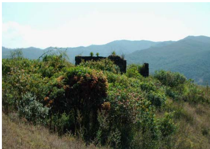
Figura 61: Ruína de hospital encoberta por vegetação Fonte: Foto de Wagner Muniz, 2008
