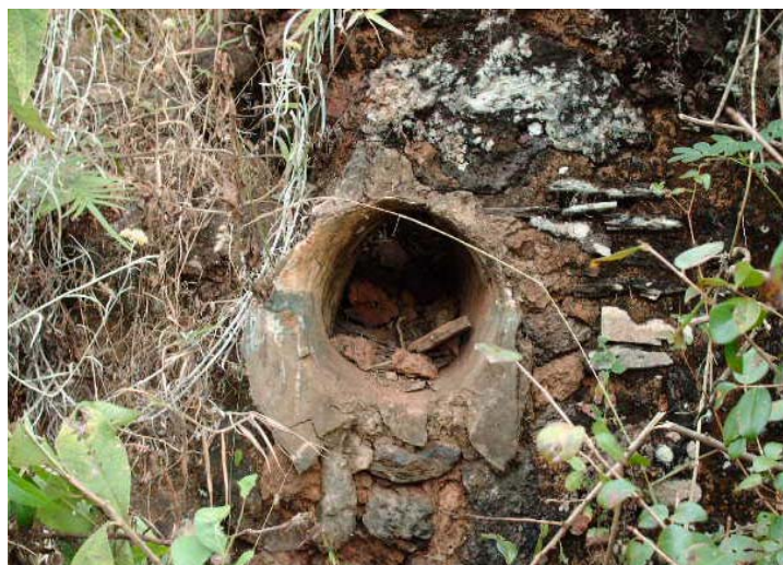
Figura 62: Detalhe de tubo de esgoto na ruína do hospital Fonte: Foto de Wagner Muniz, 2008
