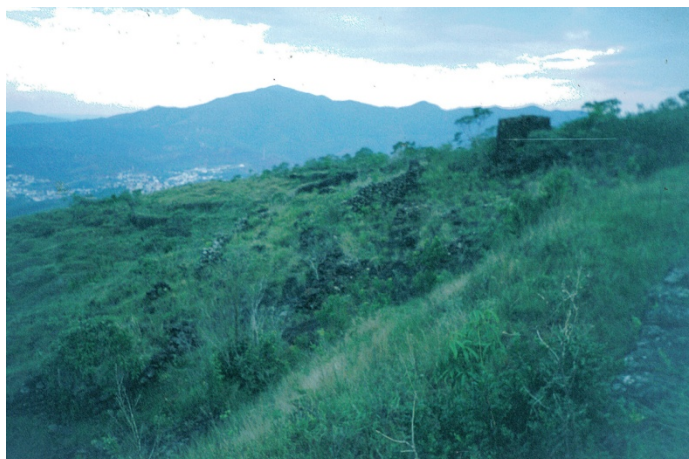
Figura 39: Ruína encoberta por vegetação Fonte: Arquivo E. M. Morro Santana, Data desconhecida
