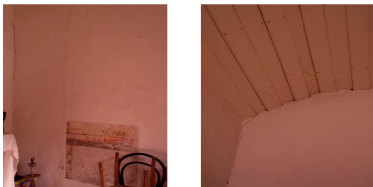
Figuras 57: Janela de prospecção e forro saia e camisa/ Fonte: Andresa Martins, 2014.
