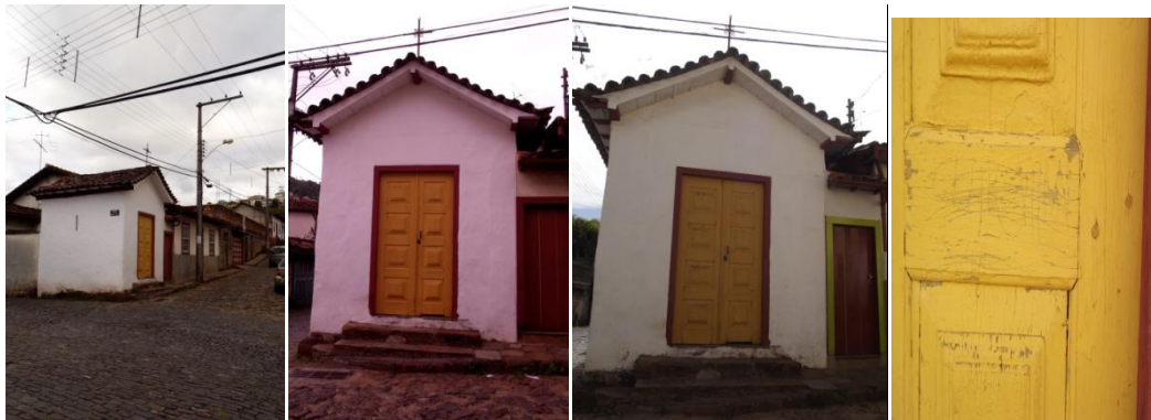
Figuras 59: edificação antes e depois da intervenção/ Fonte: Andresa Martins, 2014.
