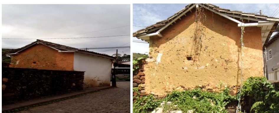
Figura 56: Fachada Posterior/ Fonte: Andresa Martins, 2014.
