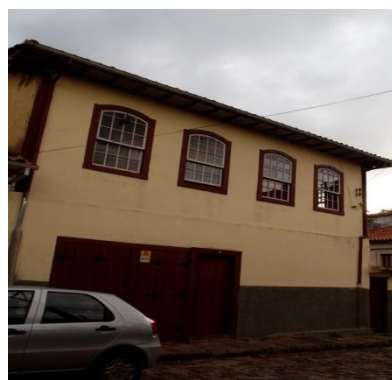
Figura: 46 Edificação frontal a Capela Fonte: Andresa Martins, 2014.
