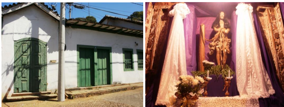
Edificação Geminada ao Passo da Ponte de Areia Mariana - MG - 14/03/2013
