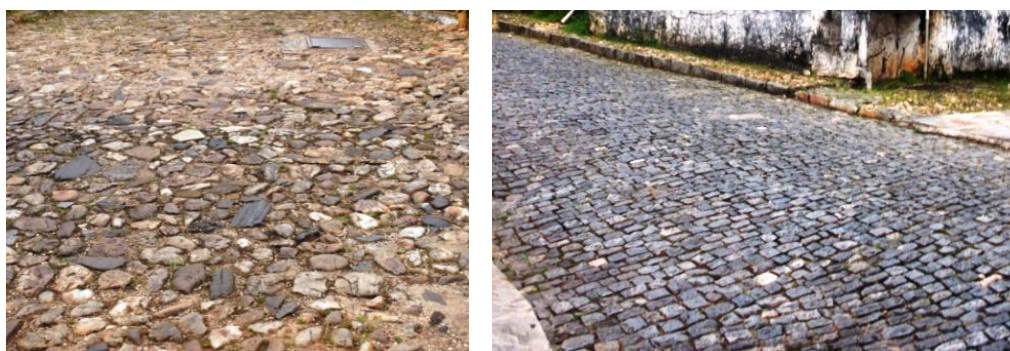
Calçamento de ruas em Mariana Minas Gerais Gilmar P. Nunes - 10/03/2013
