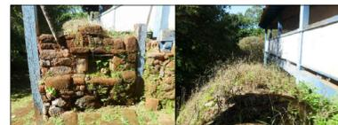
Esmacimento de pintura, presença de vegetação de pequeno porte, manchas de umidade, ressecamento da madeira
