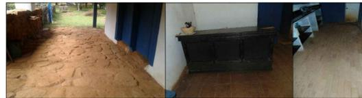
Pisos: Lajeado de pedra, taboado e lajota cerâmica: Desgaste por abrasão e sujeidade acumulada
