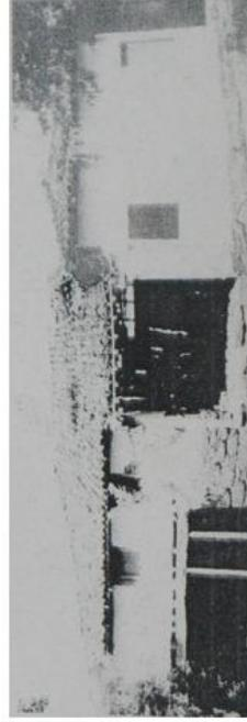
Fachada lateral esquerda, a cobertura já se encontrava mais uma vez em alto grau de deterioração. Uma parede do cômodo usado como cozinha chegou a ruir.
