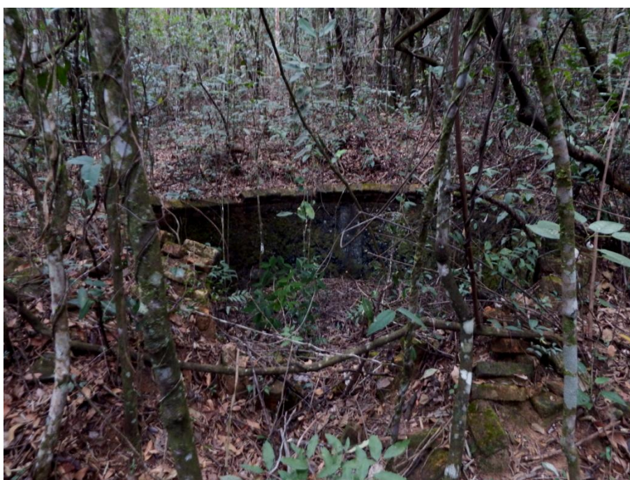
FIGURA 7: Provável reservatório d'água circular Foto: Italo M. Ribeiro – Agosto/2018
