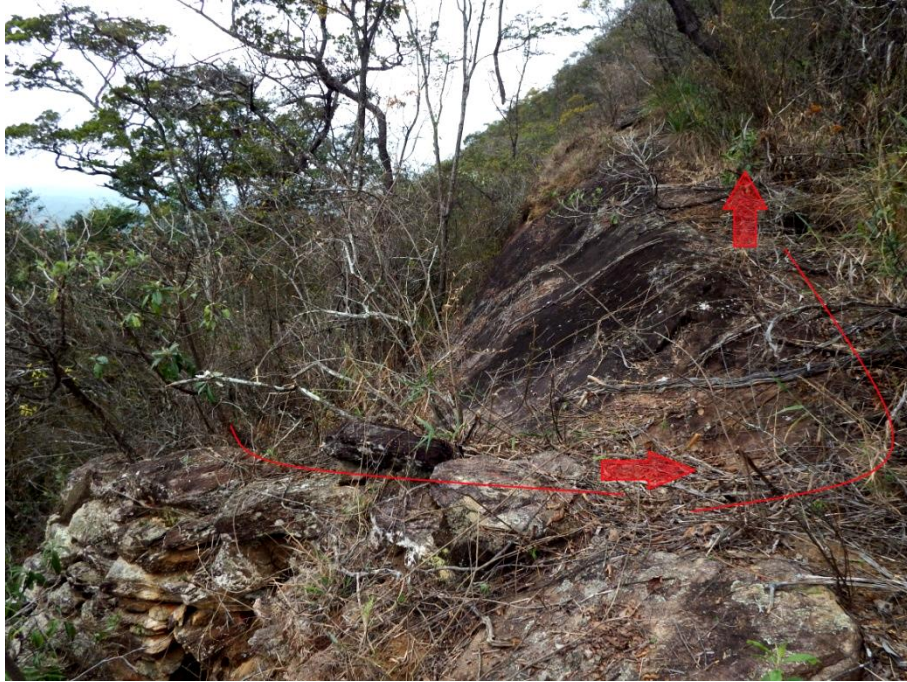
FIGURA 11: Trecho em curva do acesso arrimado Foto: Italo M. Ribeiro – Agosto/2018
