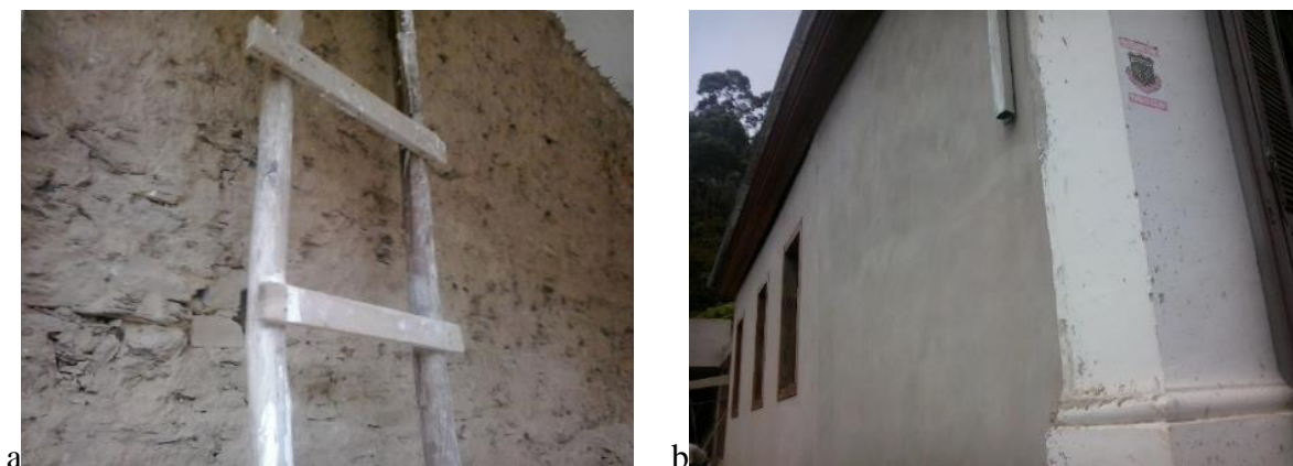
Figura 52: Alvenaria em pedra com reboco totalmente substituído.
