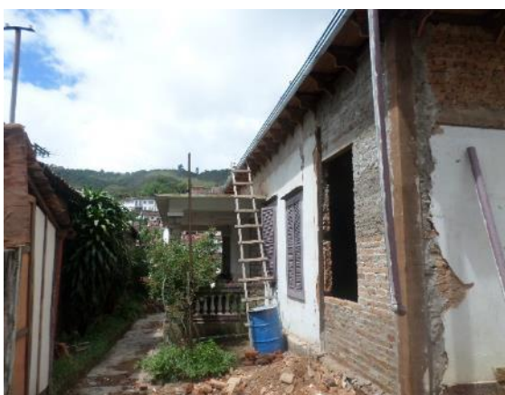
Figura 53: Reconstituição de alvenaria com tijolo queimado maciço.
