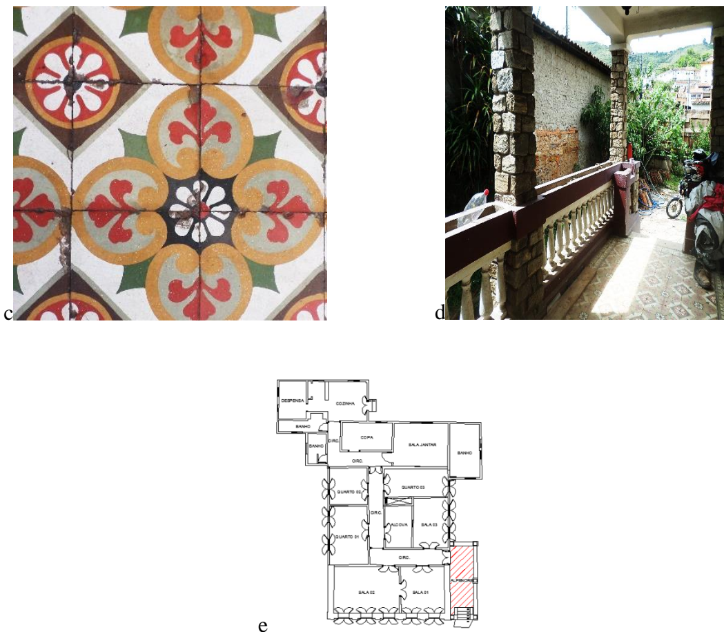
Figura 18: Alpendre. Escada em mármore branco, ladrilhos hidráulicos e balaústres em argamassa. Localização em planta.
