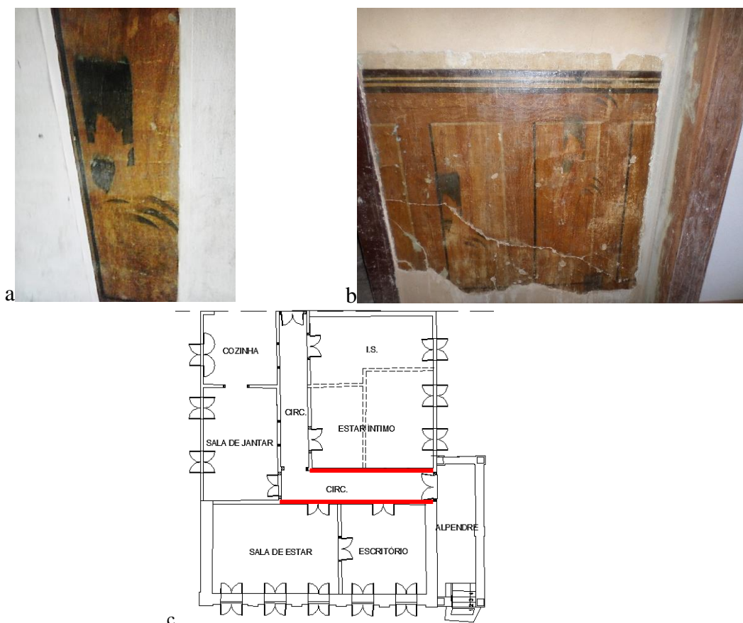
Figura 58: Janela de prospecção da pintura parietal corredor e sua localização.
