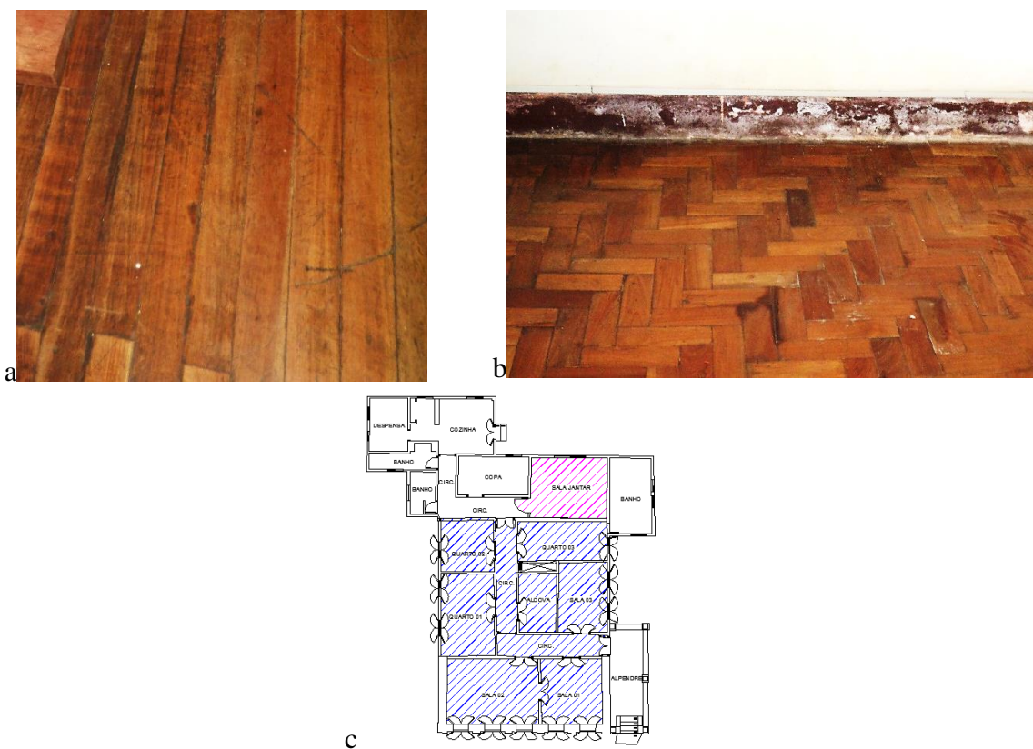
Figura 24: Pisos em pinho-de-riga (em azul) e taco (em magenta). Fontes: a e b: Maria Cláudia C. Coelho, 2014; c: Projeto arquitetônico por Alessandra Carvalho, adaptado para croqui por Maria Cláudia C. Coelho, 2016.
