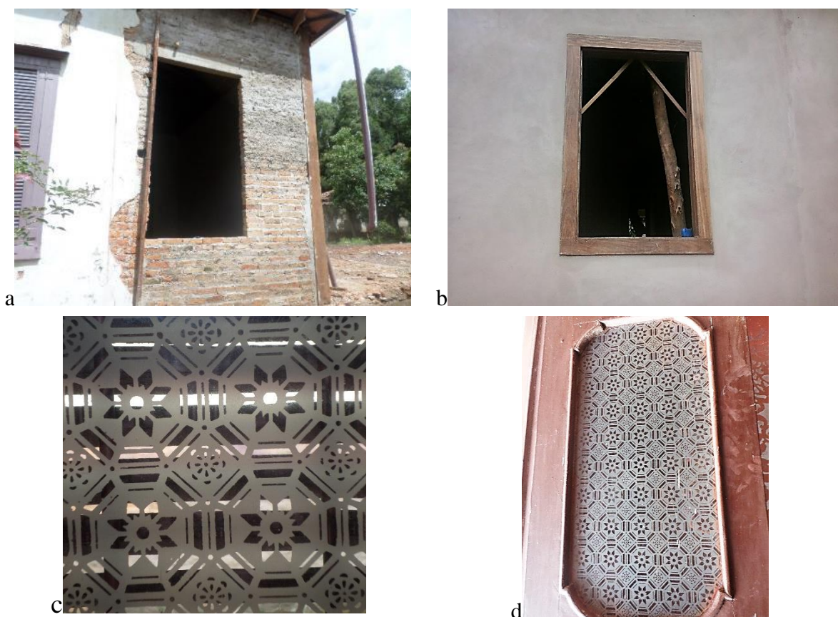
Figura 56: Vão sem esquadria, substituição por madeira de qualidade equivalente e vidro lapidado.
