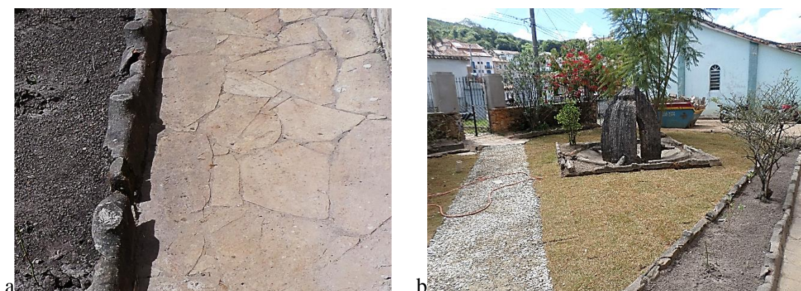
Figura 46: Substituição do piso em quartzito por grama no jardim.
