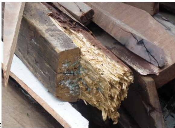
Figura 48: Reconstrução da cobertura, reaproveitamento de telhas e uso de manta metálica. Madeira retirada da cobertura original.
