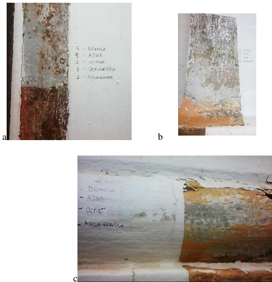
Figura 61: Prospecções de pinturas da fachada frontal.
