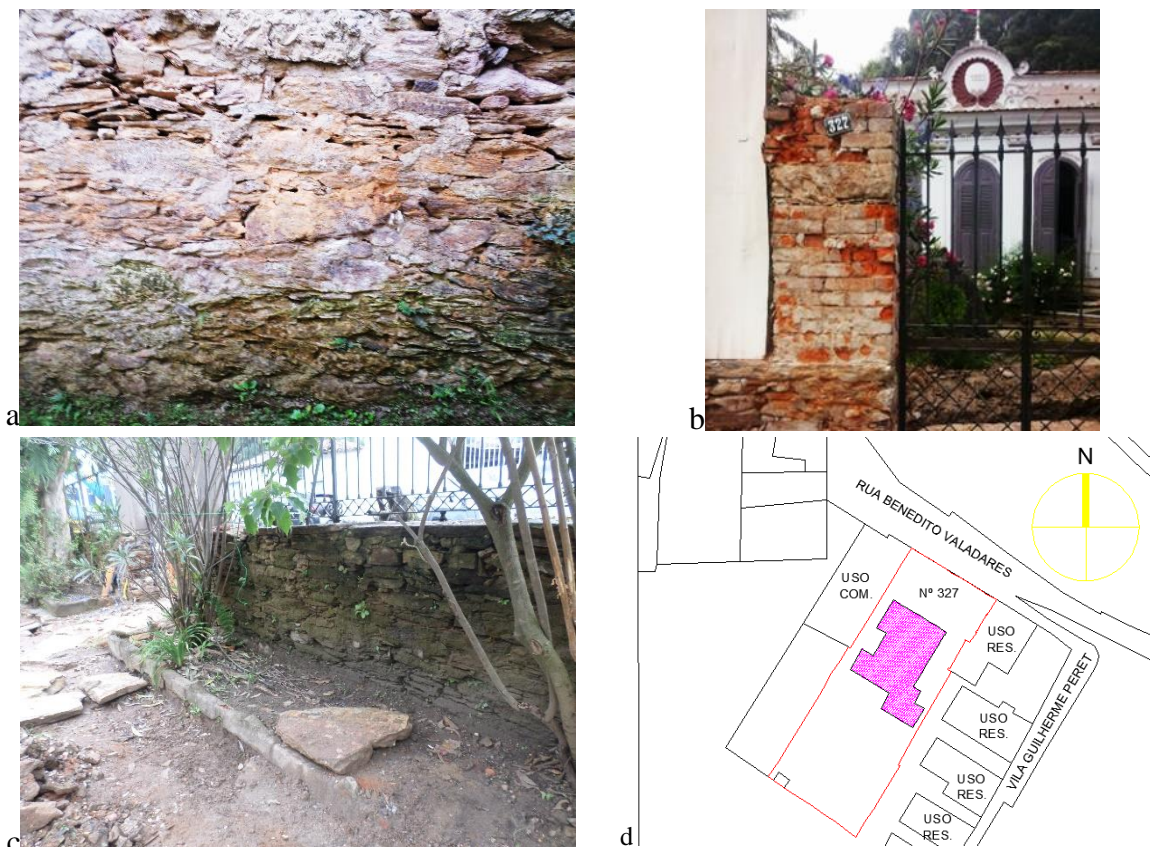
Figura 17: Muro que delimita a residência. Detalhe de adaptação de 1921 em tijolo maciço. Implantação com área do muro em vermelho.
