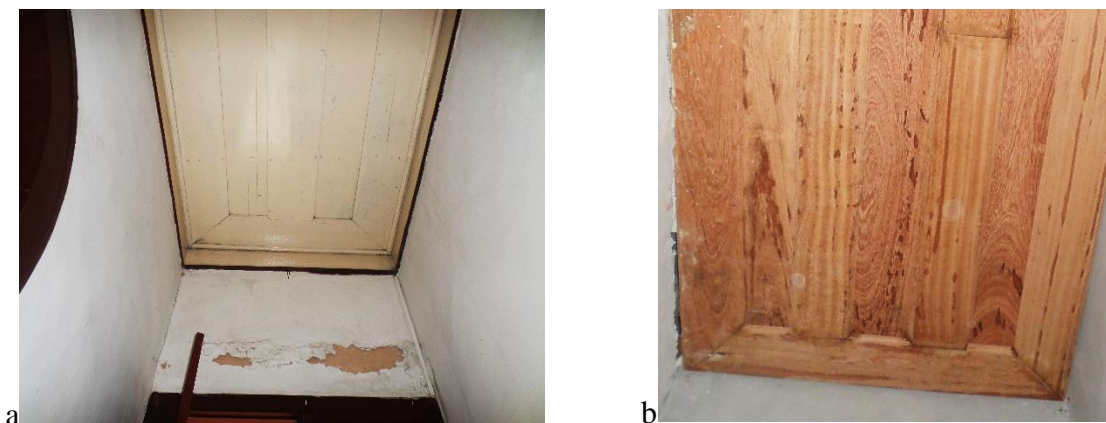
Figura 49: Forros original e substituto. Fonte: a e b: Maria Cláudia C. Coelho, 2015/2016
