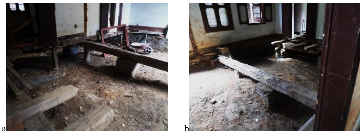
Figura 23: Alicerces e barroteamento. Fonte: a e b: Maria Cláudia C. Coelho, 2015.
