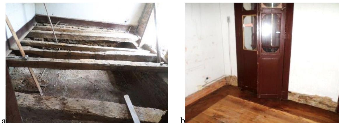
Figura 50: Barroteamento original e madeira retirada. Pinho-de-riça reinstalado.
