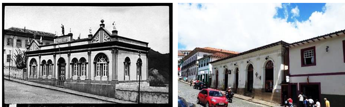
Figura 2: Exemplo de intervenção em busca de unidade de conjunto. Demolição do Lyeco de Artes e Offícios e construção do atual Cine Vila Rica.
