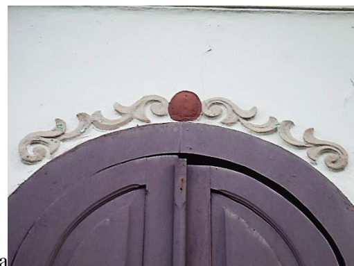
Figura 30: Detalhe de sobreverga e capitéis em estuque. Fonte: a e b: Maria Cláudia C. Coelho, 2014.
