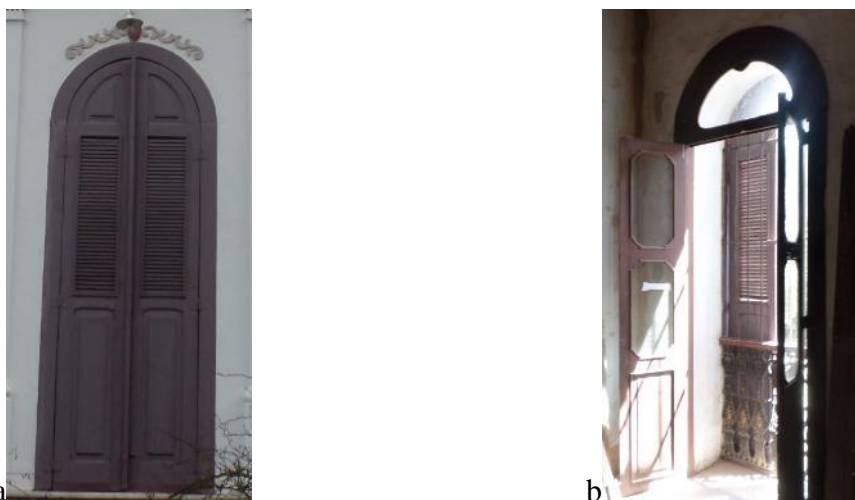
Figura 33: Janelas da fachada frontal. Folhas externas, internas, vidro lapidado e parapeito em ferro fundido. Fonte: a e b: Maria Cláudia C. Coelho, 2014-2016.
