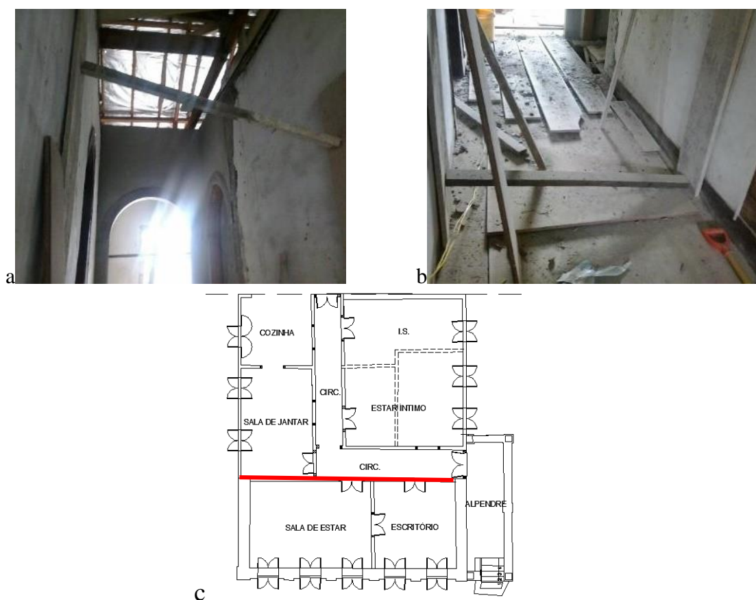
Figura 55: Ajuste da posição de alvenaria em pau-a-pique e sua localização.
