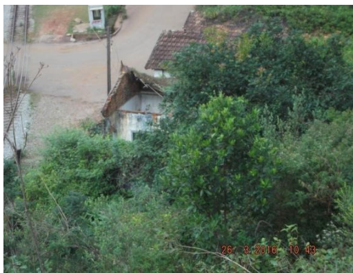
Figura 47: Vista superior, do bloco C. Fonte: Michelle Adriane, 2015.
