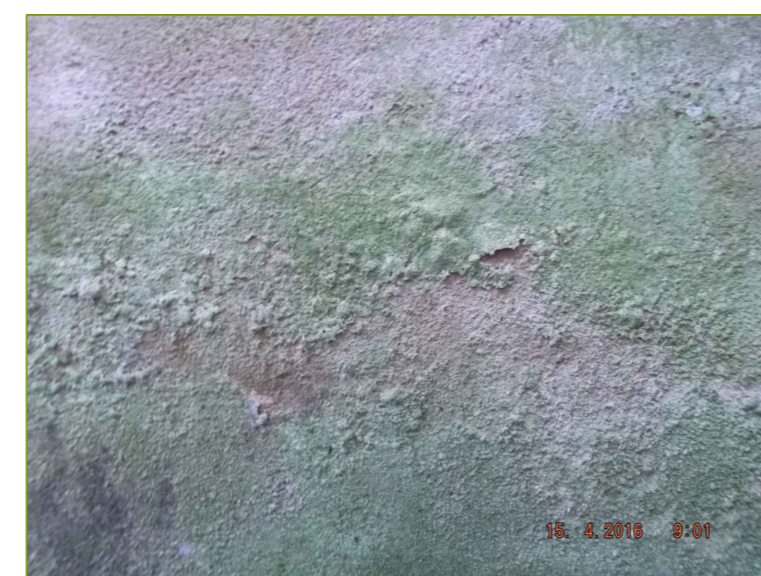
7- Desagregação da camada pictórica.
