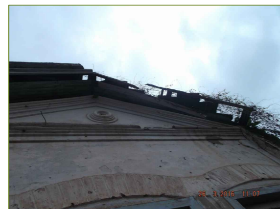
2- Perda de peças do telhado, perda pontual do estuque, matéria orgânica e sujidade.
