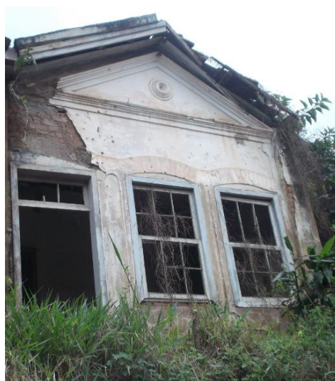
Figura 54: Janela da fachada principal e telhado com acúmulo de matéria orgânica. Fonte: Michelle Adriane, 2016.
