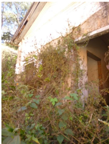
Figura 39: Concentração de vegetação, na fachada principal da casa 3, bloco B. Fonte: Michelle Adriane, 2015.
