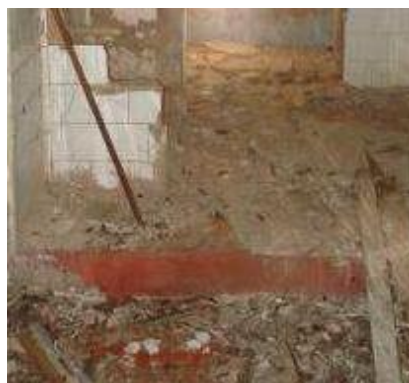
Figura 34: Piso de cimento queimado em 2010. Fonte: Inventário de proteção do acervo cultural-IPAC- Ouro Preto - Minas Gerais, 2010.
