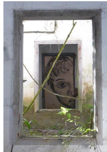
Figura 29: Marcos das janelas localizadas no interior da edificação.
