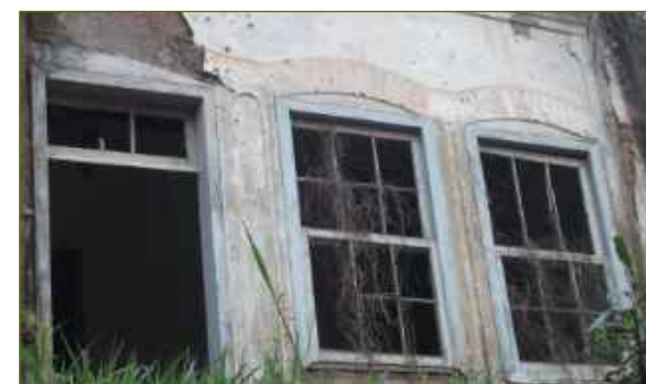
5- Matéria orgânica, sujidade, perda pontual de peças das esquadrias, perda pontual do estuque e destacamento da camada pictórica.
