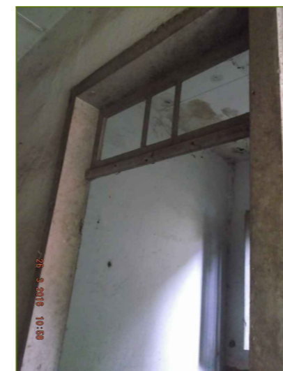
7- Sujidade, perda pontual de peças da esquadria.
