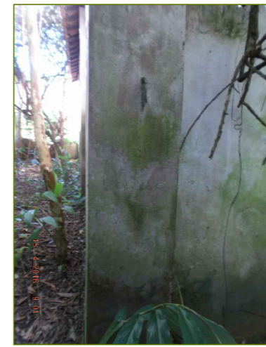
6- Destacamento da camada pictórica, sujidade, pátina botânica.
