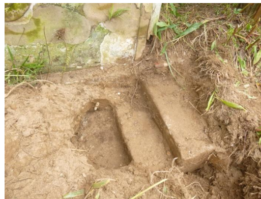
Figura 46: Buraco cavado na parte inferior, na fachada principal da casa 1, bloco A. Fonte: Michelle Adriane, 2015.
