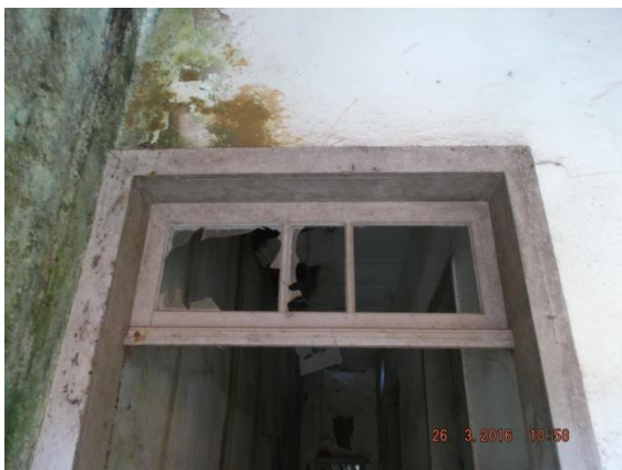
Figura 52: Vidro quebrado, localizado no interior da edificação, próximo a sala. Fonte: Michelle Adriane, 2016.
