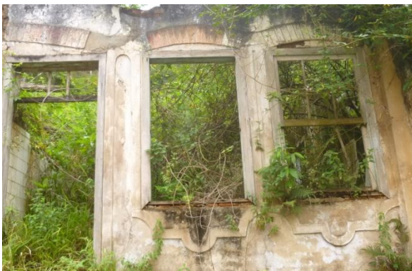
Figura 36: Esquadrias de verga reta emolduradas por detalhes de arco abatido em argamassa. Fonte: Michelle Adriane, 2015.
