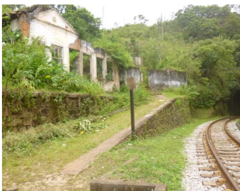
Figura 18: Rampa de acesso, lado direito.
