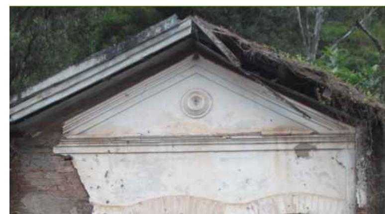
1- Sujidade, matéria orgânica, perda pontual do reboco e do estuque, perda de peças do telhado e mancha de água descendente.
