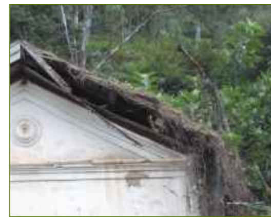
6- Matéria orgânica, sujidade, perda de peças do telhado e perda pontual do estuque.
