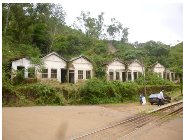
Figura 3: Conjunto Residencial do Caminho da Fábrica, composta por seis edificações.
