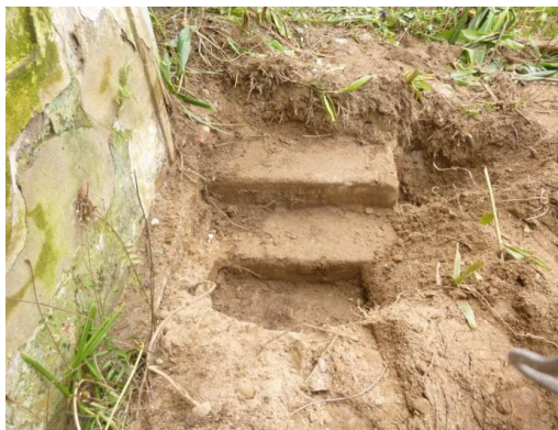
Figura 45: Buraco cavado na parte inferior, na fachada principal da casa 1, bloco A. Fonte: Michelle Adriane, 2015.
