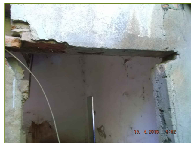
1- Sujidade, perda de peças da esquadria.
