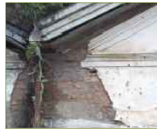
7- Vegetação de pequeno porte, perda pontual do reboco, sujidade e mancha de água descendentes.
