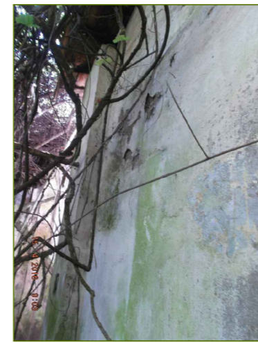
7- Destacamento da camada pictórica, sujidade, desagregação da camada pictórica, matéria orgânica e vegetação grande porte.
