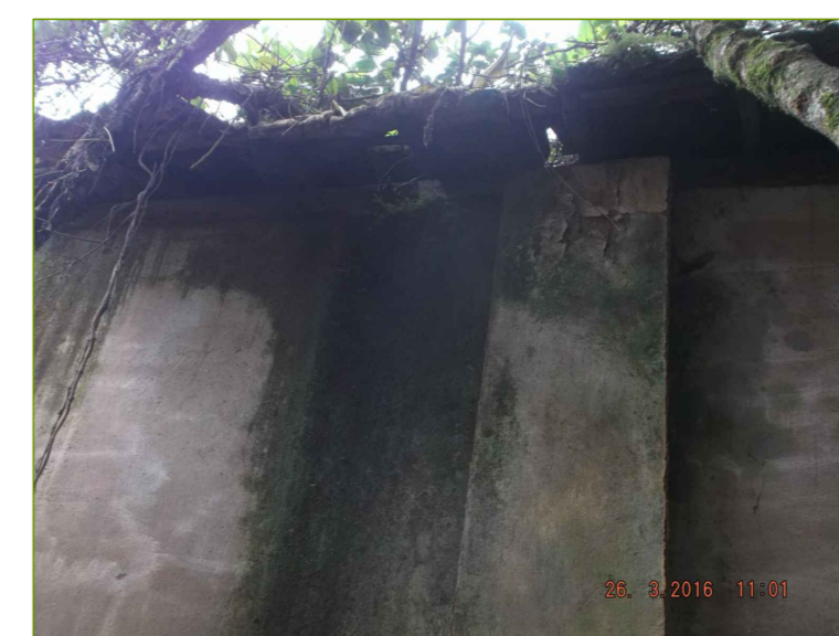
8- Mancha de umidade descendente, destacamento da camada pictórica, sujidade, matéria orgânica, perda pontual de peças do telhado.
