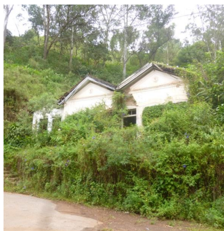
Figura 41: Concentração de vegetação, na fachada principal do bloco A, antes da limpeza. Fonte: Michelle Adriane, 2015.
