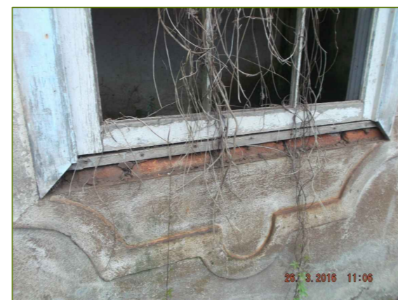
3- Perda de madeira da esquadria, matéria orgânica, sujidade e destacamento da camada pictórica.
