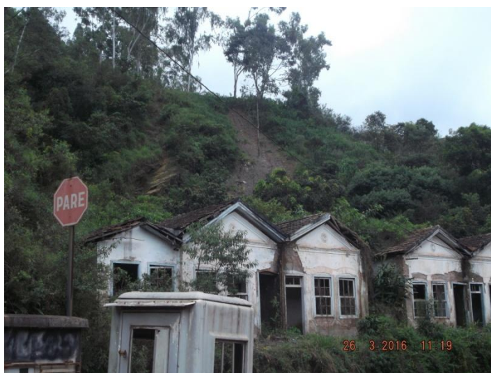
Figura 51: Barranco localizado na parte posterior das edificações.
