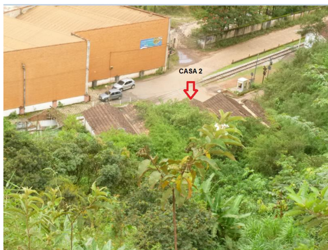
Figura 50: Vista superior das edificações, com a localização da casa 2, bloco A.
