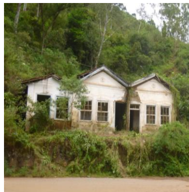
Figura 9: Edificações que sofreram soterramento, na parte posterior. Fonte: Michelle Adriane, 2016.
