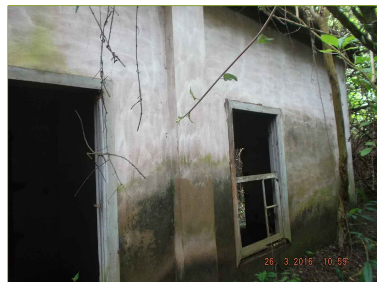
1- Sujidade, matéria orgânica, pátina botânica, perda pontual de madeira da esquadria.
