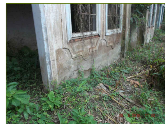
4- Perda de madeira da esquadria, matéria orgânica, sujidade, destacamento da camada pictórica e vegetação de pequeno porte.
