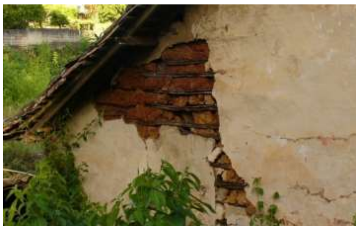
Fig. 48 – Paredes de pau-a-pique – Rua Salvador Tropicia 156, Centro. Ouro Preto, MG. Fonte: Foto do Autor.
