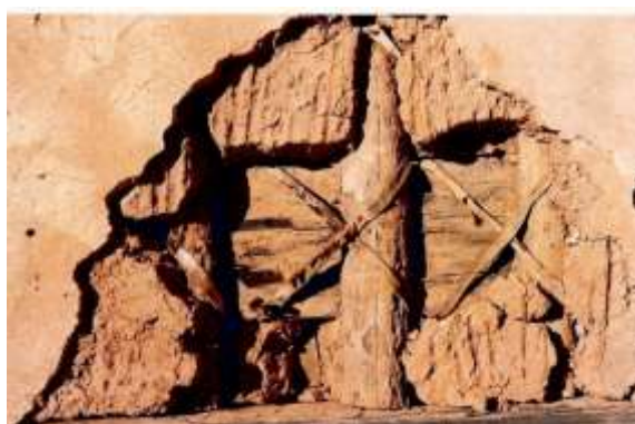
Fig. 49 – Detalhe da amarração e da estrutura do pau-a-pique. Fonte: Ricardo Abdalla.
