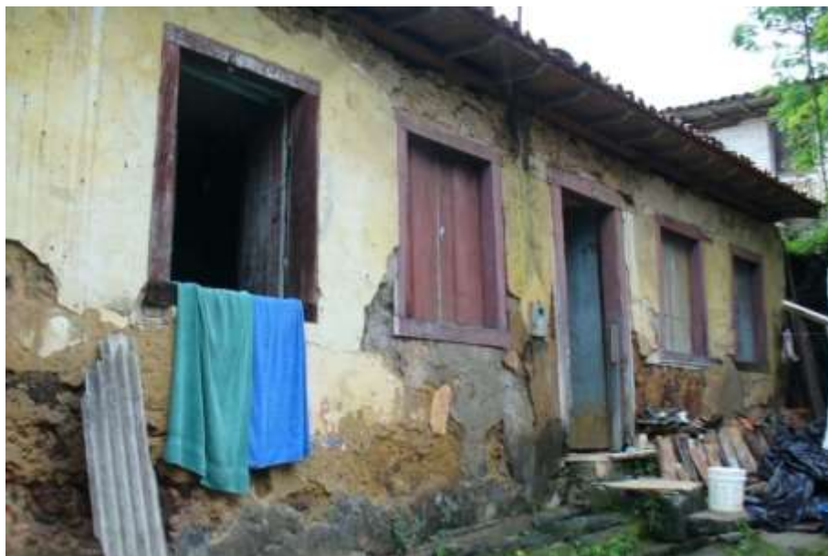
Fig. 42 – Edificação construída com pedra de canga – Rua Chico Rei, 108. Ouro Preto, MG. Fonte: Foto do Autor.
