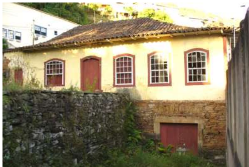
Fig. 22 – Muro e alicerce de pedra seca – Rua Salvador Tropicia 156, Centro. Ouro Preto, MG. Fonte: Foto do Autor.
