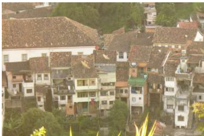
Fig. 47 – Edificações com porões – Bairro Antônio Dias. Ouro Preto, MG. Fonte: Foto do Autor.
