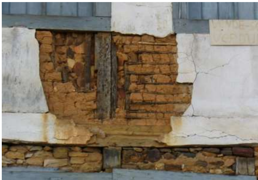
Fig. 44 – Detalhe de uma estrutura autônoma em madeira – diferenças das madeiras utilizadas. Fonte: Foto do Autor.
