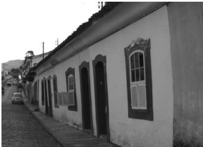
Fig. 41 – Edificações construídas com taipa de pilão – Casas do Bom-Será , Bairro Cabeças. Ouro Preto, MG. Fonte: Foto do Autor.
