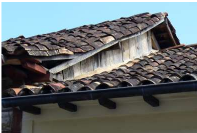
Fig. 50 – Tabique usado no fechamento de empenas – Bairro Cabeças. Ouro Preto, MG. Fonte: Foto do Autor.
