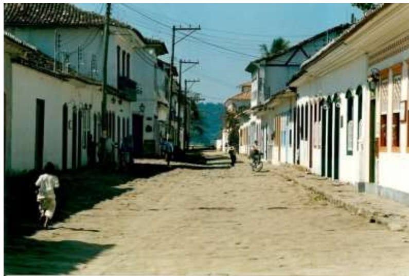
Fig. 08: Paraty (RJ), uniformidade do partido arquitetônico. Fonte: Ricardo Abdalla.
