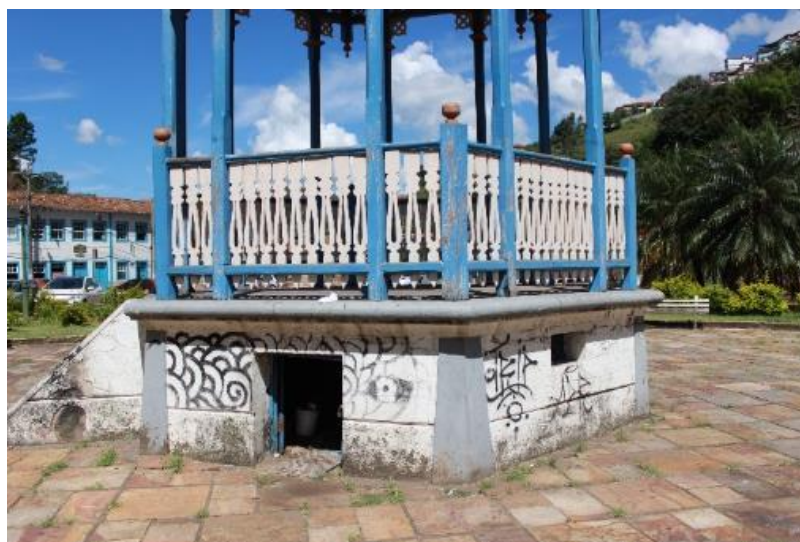
FIGURA 25- Vandalismos no coreto.
