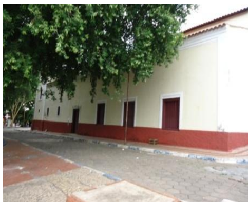
Figura12 - Fachada lateral direita.
