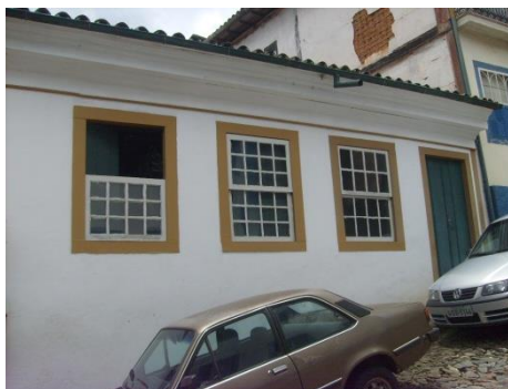
FIGURA 74 – Entrada principal do segundo andar com acesso ao terceiro.
