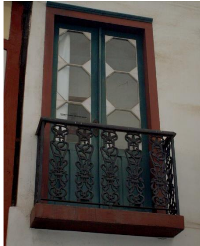
FIGURA 34 – Vidraças e ferro nas fachadas
