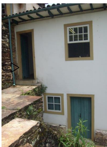
FIGURA 75 - Entrada de acesso ao terceiro pavimento pelos fundos
