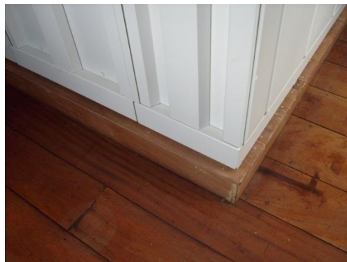
FIGURA 86 – Abaixo do arquivo, estrutura metálica revestida com tábua
