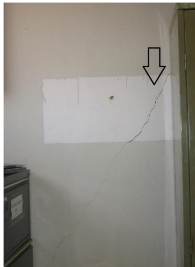
FIGURA 92 – Fissuras nas paredes estruturais
