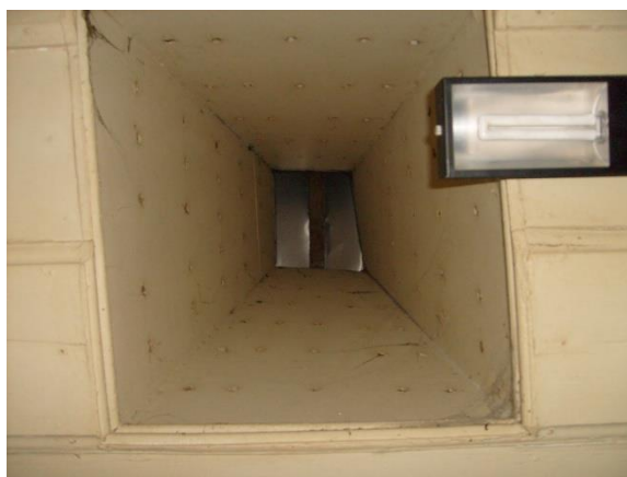
FIGURA 90 – Abertura no teto (tampada) nos banheiros
