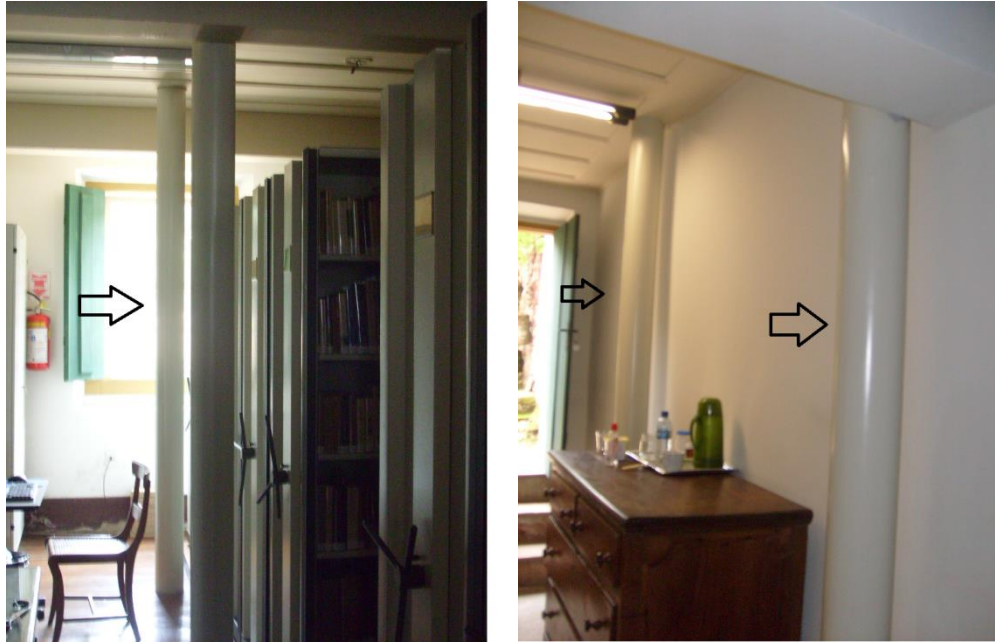
FIGURA 83 e 84 – Pilares de sustentação
