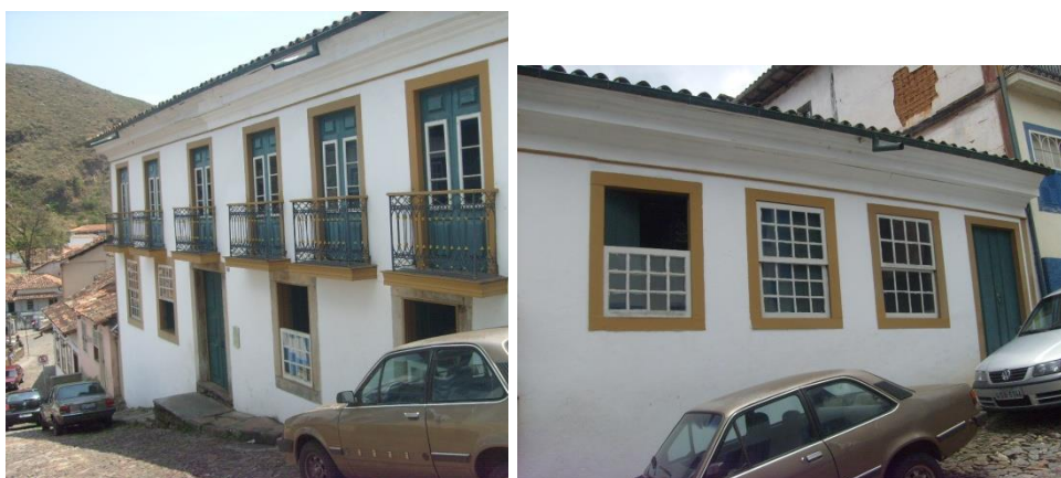
FIGURA 55 e 56 - Fachada da casa maior e casa menor, respectivamente
