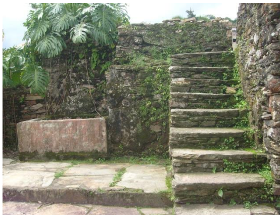
FIGURA 58 – Tanque localizado no pátio inferior.
