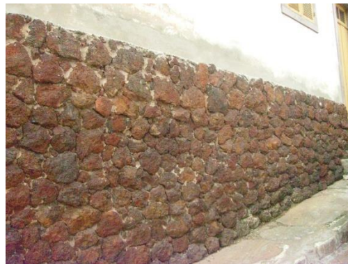
FIGURA 43 - Parede de canga
