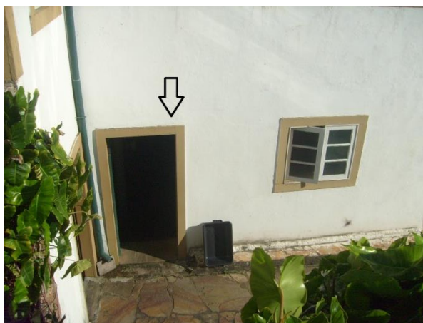
FIGURA 77 – Porta que liga o pátio externo ao pavimento térreo
