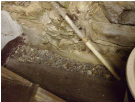
FIGURA 78 – Brita nas laterais da sala do Setor Pedagógico
