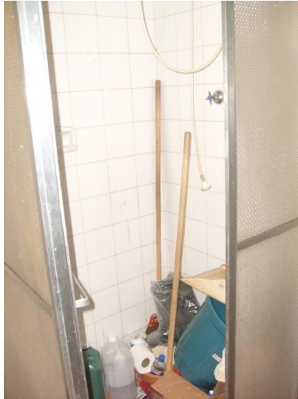
FIGURA 91 – Box do banheiro do 3º andar
