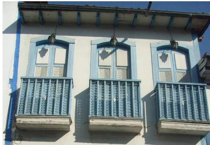
FIGURA 28 – Sacadas com treliças do sobrado localizado a Rua do Pilar – Ouro Preto
