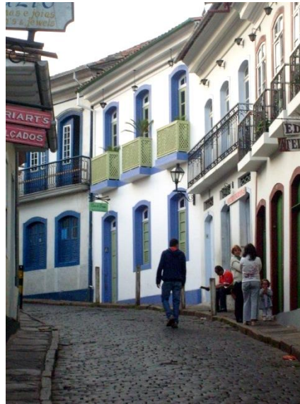
FIGURA 11 - Sobrados da Rua São Francisco - OP.
