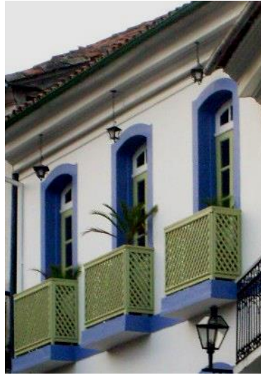
FIGURA 29 – Sacadas em treliças do sobrado localizado a Rua São Francisco
