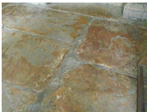
FIGURA 67 – Piso da portaria
