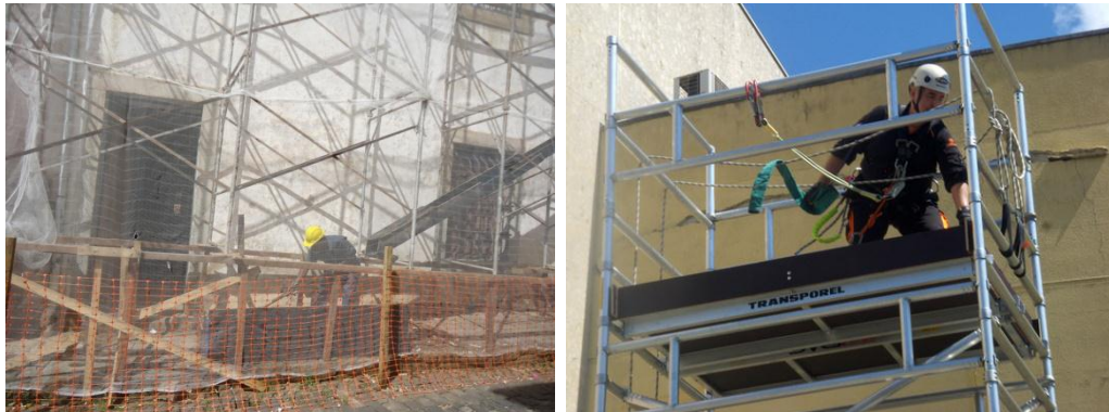
Figura 18 - Risco de acidente: trabalho em altura Fonte: autora, 2015.
