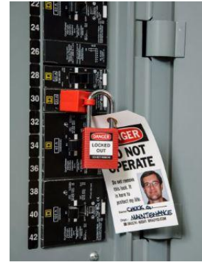
Figura 17 - Prevenção de acidente: Painel de controle elétrico adequado. Fonte: Google Imagens O, 2015.
