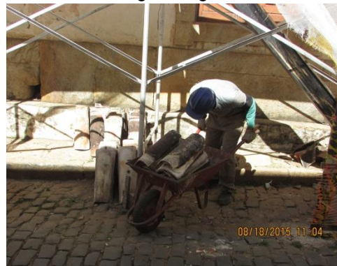
Figura 12 - Riscos ergonômicos: transporte manual de pesos e posturas inadequadas. Fonte: autora, 2015.
