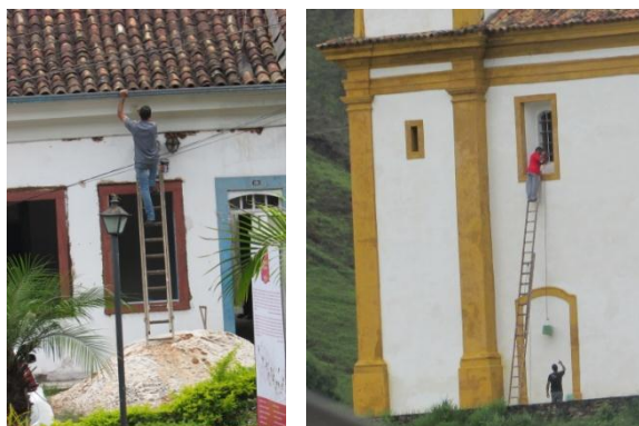
Figura 29 - Trabalhadores informais executando atividades em altura sem uso de EPI's e andaimes. Fonte: autora, 2015.
