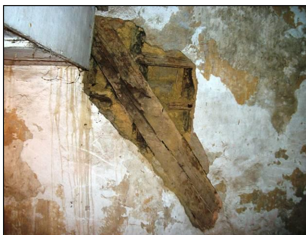
Figura 15: Parede onde se coletou material para análise. Fonte: Juliana Pereira, 2010.
