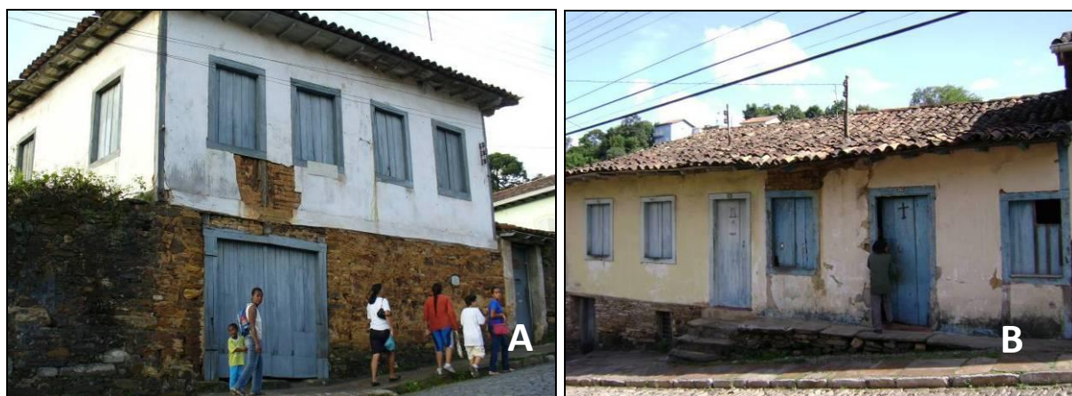
Figura11: A) Fachada mista com parede de pau-a-pique assentada sobre alvenaria de pedra com argamassa; B) Casas geminadas de pau-a-pique com baldrame de pedra (Ouro Preto, MG). Fonte: Juliana Pereira (2010).
