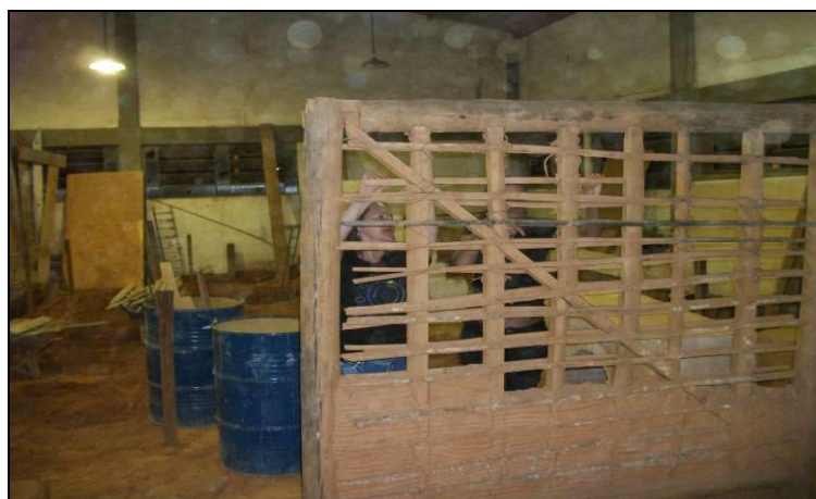
Figura 7: Parede de pau-a-pique em processo de construção. Fonte: Juliana Pereira (2010).
