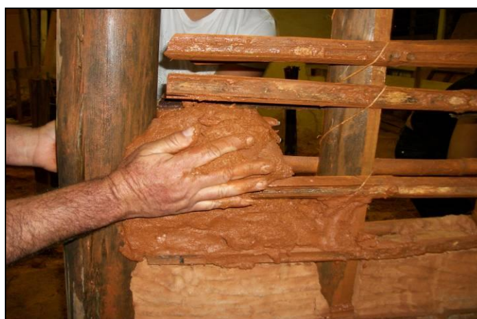
Figura 8: Aplicação de argamassa de barro. Fonte: Juliana Pereira (2010).
