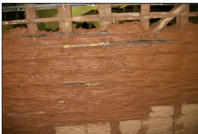
Figura 9: Parede de pau-a-pique. Fonte: Juliana Pereira (2010).
