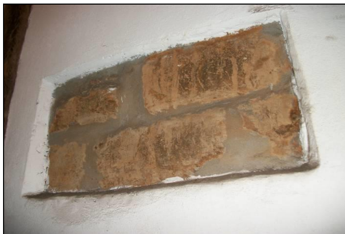
Figura 6: Janela de testemunho da Igreja Matriz de N. Sra do Pilar evidenciando parede de adobe (Ouro Preto-MG). Fonte: Juliana Pereira, 2010.
