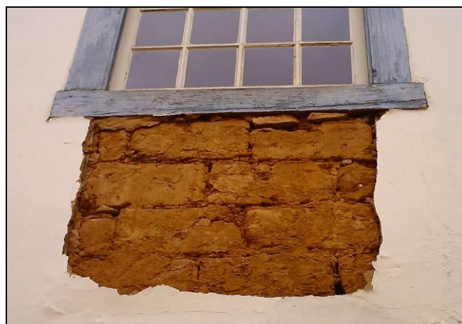
Figura 5: Parede de adobe ( Mariana-MG). Fonte: Gilmar Nunes (2010).
