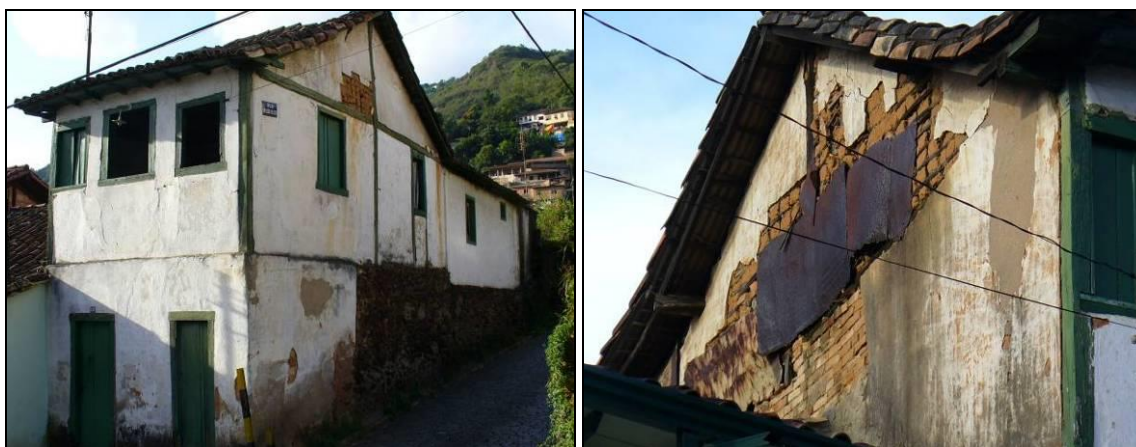
Figura 10: Sobrado com empena de pau-a-pique (Ouro Preto-MG). Fonte: Juliana Pereira (2010).
