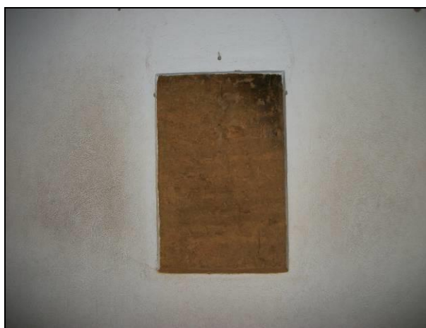
Figura 3: Janela de testemunho da Igreja Nossa Sra. do Pilar evidenciando parede de taipa de pilão (Ouro Preto-MG).
