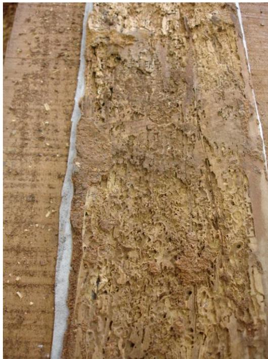
**Figura 6:** Detalhe de madeira atacada por insetos xilófagos (cupins e brocas).
