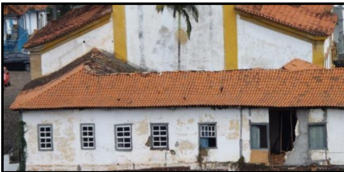
Fig. 02- Fachada Lateral Direita (vista parcial)
