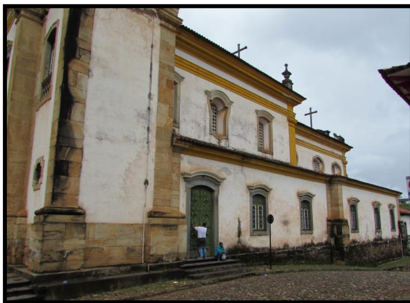
Fig. 06 - Fachada lateral esquerda
