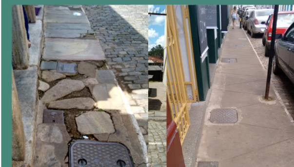
Calçada em laje de pedra. Algumas pedras se encontram soltas dificultando a acessibilidade.
