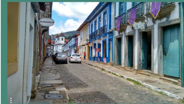
Calçada em laje de pedra. Algumas pedras se encontram soltas dificultando a acessibilidade.
