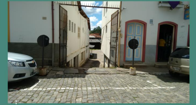
Calçada em laje de pedra e lajota cimentícia. Tabladões de madeira para vencer desnível do passeio. Laje de pedra faltante.
