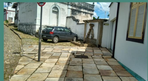
Calçada com bloco de pedra retangular e a transição para a com pé de moleque
