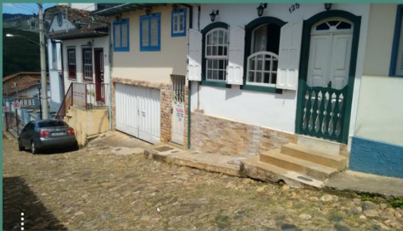
Degraus de escadas edificadas sobre o passeio, criando obstáculos no passeio
