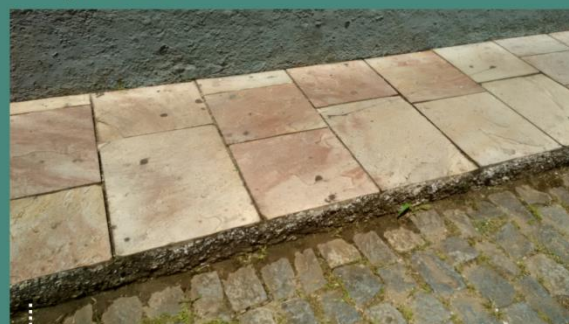
Calçada com bloco de pedra retangular
