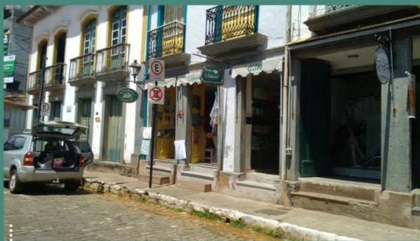
Calçada em laje de pedra e lajota cimentícia. Tabladões de madeira para vencer desnível do passeio.
