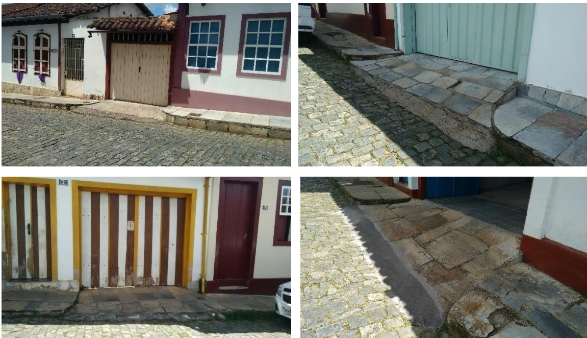
Figura 79, 80, 81 e 82: Rampas de acesso a garagem com degraus no passeio em suas laterais.
