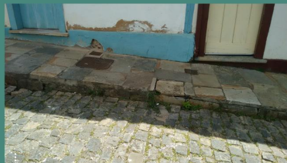
Calçada em bloco de pedra retangular com pedra solta
