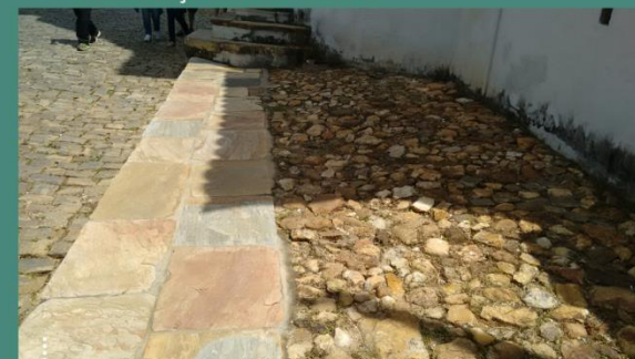
Calçada em bloco de pedra retangular na porção transitável do passeio e pé de moleque no restante
