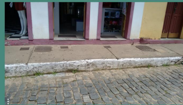
Calçada de concreto com juntas de dilatação.
