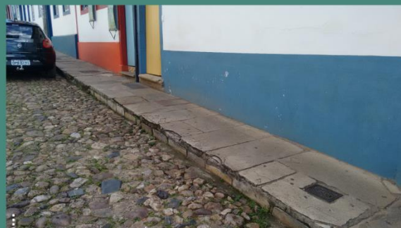
Calçada em bloco de pedra retangular
