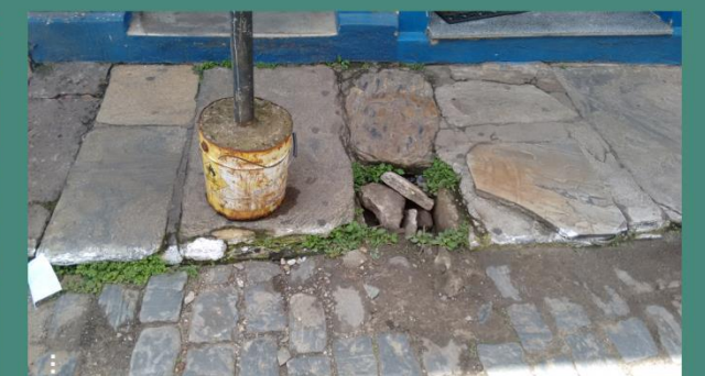
Calçada em laje de pedra com a pedra danificada e solta.
