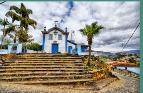
11 - Igreja das Mercês. Fonte: Disponível em: < http://www.panoramio.com/photo/38972311 >. Acesso em: 14 de abril de 2016.
