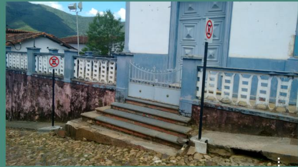
Degraus de escadas edificadas sobre o passeio, criando obstáculos no passeio
