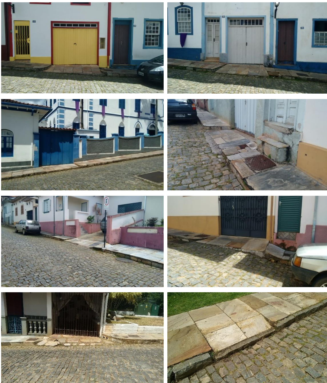
Figura 83, 84, 85, 86, 87, 88, 89 e 90: Rampas de acesso a garagem com degraus no passeio em suas laterais. A última foto mostra a única rampa para acesso de cadeirantes, próxima ao adro da Igreja de São Pedro. Fonte: Autora. Março de 2016.
