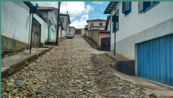
Degraus e desníveis no passeio, criando obstáculos e dificultando a passagem de pedestres
