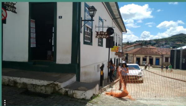
Calçada em laje de pedra com intervenções com cimento. Existência de degraus no passeio.
