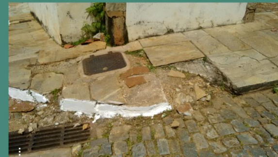
Calçada em bloco de pedra com peças faltantes e intervenções em cimento
