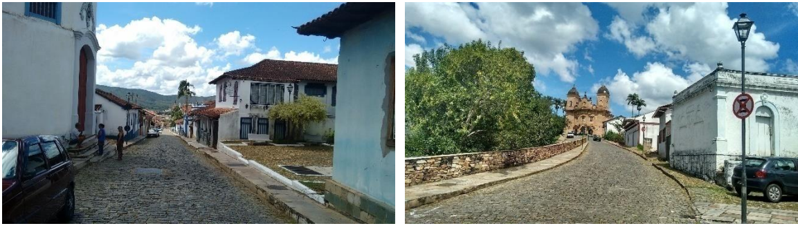
Figura 75 e 76: A esquerda, vista da Rua Dom Silvério próximo a Igreja de Nossa Senhora da Arquiconfraria. A Direita, vista da Rua Dom Silvério próximo a caixa d'água (a esquerda da foto). Ao fundo, Igreja de São Pedro dos Clérigos. Fonte: Autora. Março de 2016.
