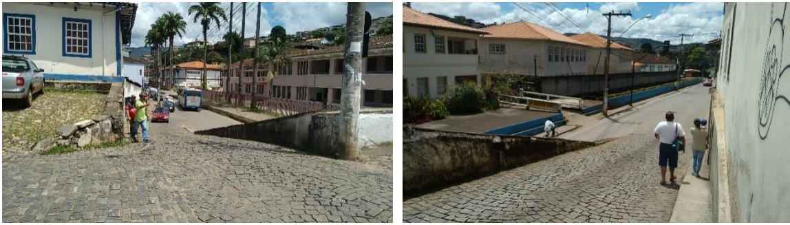
Figura 52 e 53: Cruzamento da Ponte de Areia com a Rua Direita. Ponto de conflito entre veículos e pedestres. Fonte: Autora. Março de 2016.
