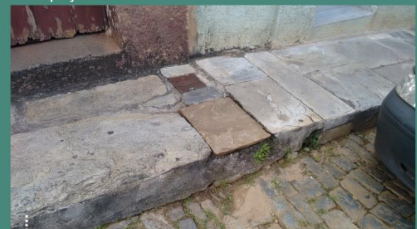
Calçada com laje de pedra e ao lado com bloco de pedra retangular
