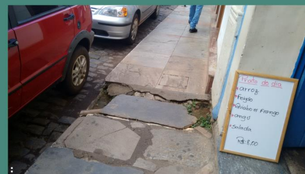
Calçada em laje de pedra e placas de pedra. Intervenção no passeio com laje de pedra sem fixação.
