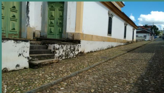
Calçada de pé de moleque.
