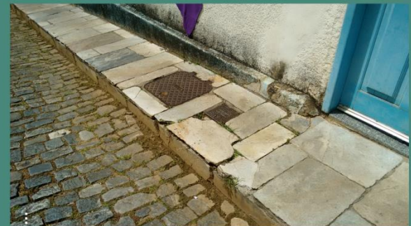
Passeio em bloco de pedra retangular com algumas peças soltas
