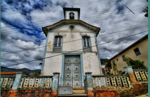
2 - Igreja das Mercês. Fonte: Disponível em: < http://www.panoramio.com/photo/38972226 >. Acesso em: 14 de abril de 2016.
