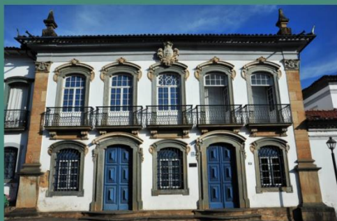
7 - Casa Capitular. Fonte: Disponível em: < http://www.panoramio.com/photo/38971733 >. Acesso em: 14 de abril de 2016.
