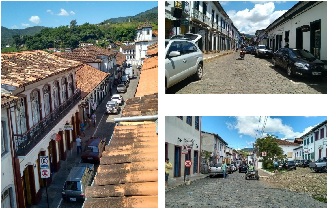
Figura 36, 37 e 38: A esquerda, vista da Rua Direita, sendo possível observar a largura constante do passeio e o calçamento em paralelepípedo da via. A direita, figura superior, calçamento de paralelepípedo da Rua Direita, bem como na figura inferior da direita, onde é possível observar o calçamento e o passeios (a direita da imagem afastamento com calçamento em pé de moleque utilizado como estacionamento). Fonte: Autora. Março de 2016
