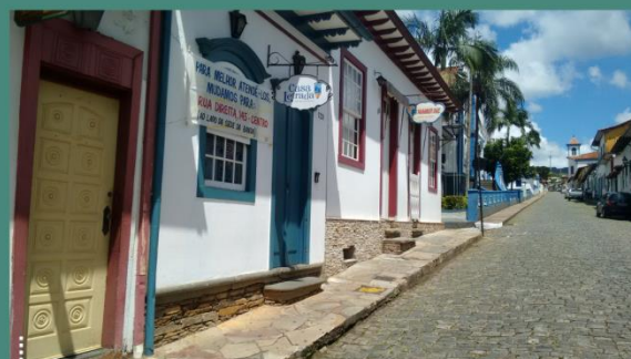
Calçada em bloco de pedra recortado
