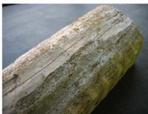
Figura 34: Ataques de caruncho pequeno. Fonte: http://construironline.dashofer.pt/?s=modulos&v=capitulo&c=1794 , Acesso em: 15/05/2014.
