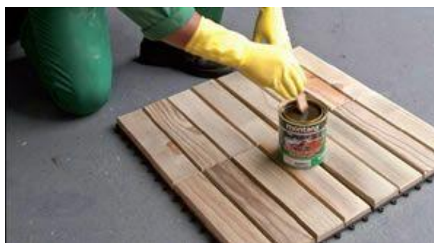
Figura 36: Tratamento por pincelamento. Fonte: http://www.construcaomercado.pini.com.br Acesso em: 24.04.2015
