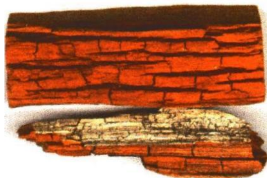
Figura 28: Madeira atacada por fungo de podridão parda. Fonte: http://www.ebah.com.br/content/ABAAAAMT8AH/agentes-deterioradores-madeira Acesso: 01.03.2015
