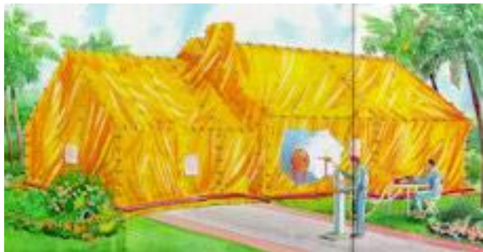
Figura 35: Tratamento por fumigação. Fonte: http://www.dowagro.com/br/sentricon/cupins/control.htm Acesso em: 24.04.2015
