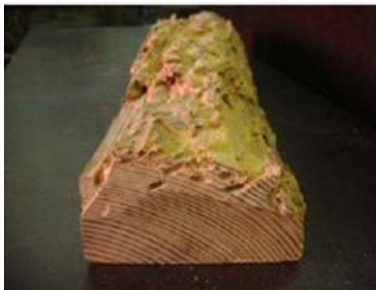
Figura 33: Ataques de caruncho grande. Fonte: http://construironline.dashofer.pt/?s=modulos&v=capitulo&c=1794 , Acesso em: 15/05/2014.
