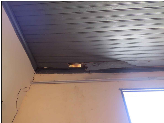
4-Apresenta trincas e perda de material, deterioração da madeira.
