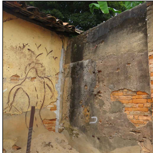
2-As paredes apresentam patina biológica e mancha enegrecida, intervenção inadequada com relação ao material original- argamassa de cimento, sujidade imprópria, vandalismo por pichação, perda de reboco e trincas.
