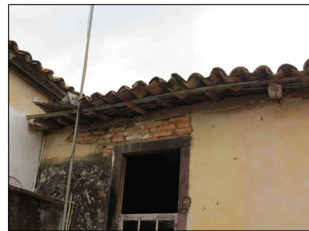
1-Presença de patina biológica, musgo, líquens mancha enegrecida, perda do reboco e trincas, devida à umidade constante no local.
