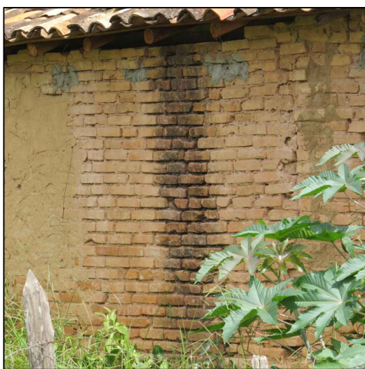
7-Manchas enegrecidas, perda do reboco e trincas
