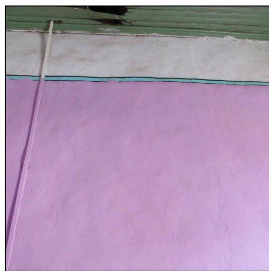
5-Trincas preenchida com argamassa de cimento.
