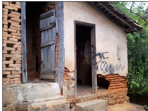
9-As alvenarias apresentam perda de material, lacunas, vandalismo por pichação, devida a falta de manutenção. As esquadrias apresentam desgaste e ressecamento da madeira, causada pelas intempéries, presença de umidade, ataque de cupins e pela própria ação natural do tempo decorrido. A estrutura em madeira apresenta ataque de xilófagos, podridão na madeira.
