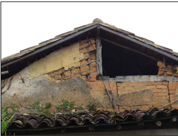
1-Apresenta patina biológica, ataque de térmitas, ressecamento e apodrecimento de peças estruturais de madeira do telhado, trincas e desprendimento do reboco, possivelmente provocada pela deformação da estrutura do telhado.
