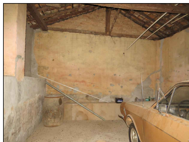
1-Apresenta umidade, ressecamento da pintura, trincas preenchida com argamassa de cimento apresenta sujidade imprópria, devida a falta de manutenção e intervenção inadequada.
