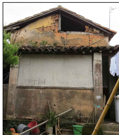
1- Apresenta patina biológica, musgos, mancha enegrecida, ataque de térmitas, ressecamento e apodrecimento de peças estruturais de madeira do telhado, trincas e desprendimento do reboco, possivelmente provocada pela deformação da estrutura do telhado.
