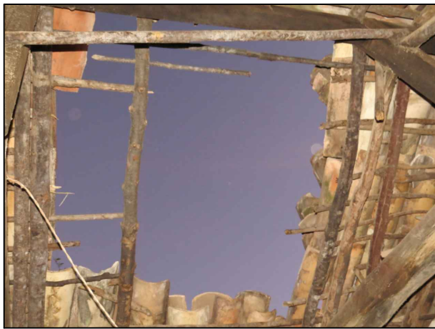
4-Os telhados estão com a estrutura de madeira deteriorada, devida o ataque de térmitas, as madeiras estão ressecadas devida ação do tempo e exposição constante a intempéries.
