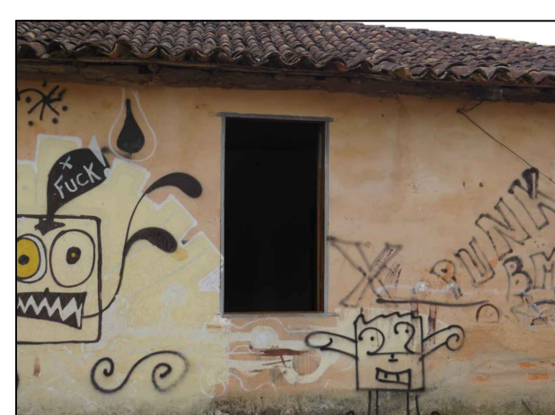
3-vandalismo por pichação, trincas e ressecamento, sujidade impregnada da pintura.
