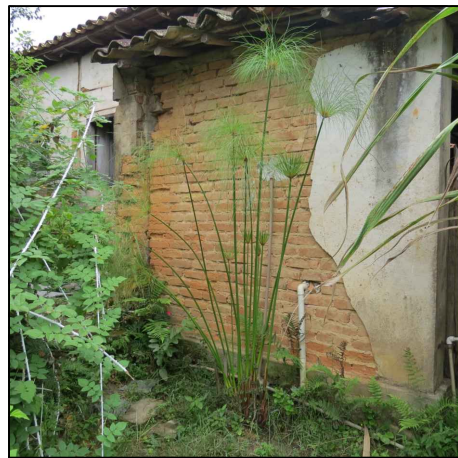
8-As paredes apresentam ataque botânico de pequeno e médio porte, perda do reboco e sujidade impregnada, provocada pela ação do tempo, umidade constante e falta de manutenção.
