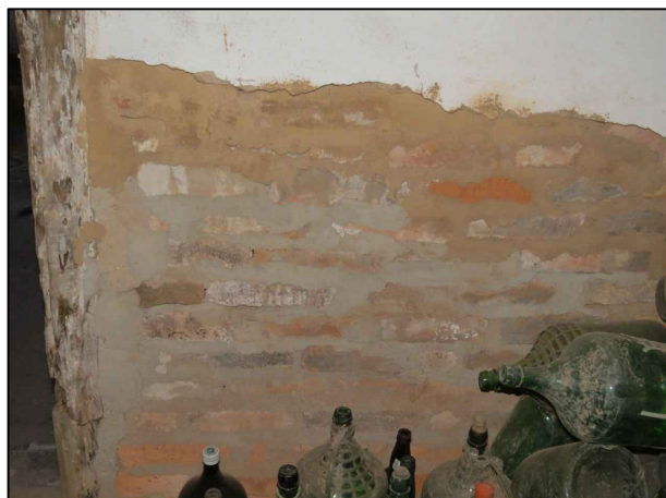
3- Perda do reboco, apodrecimento da madeira da esquadrias, intervenção inadequada.
