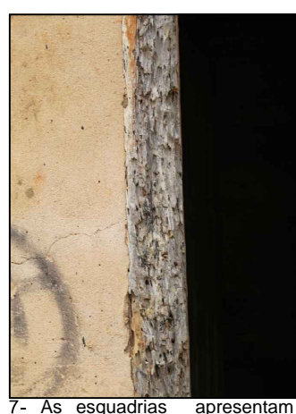
7-As esquadrias apresentam degradação e ressecamento da madeira.
