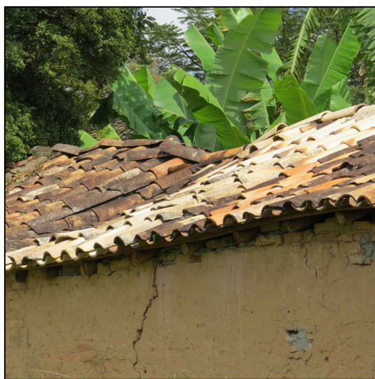
6-Os telhados estão com a estrutura de madeira deteriorada causando deformação e trincas na alvenaria trincas, devida o ataque de térmitas, ressecamento da madeira e umidade.
