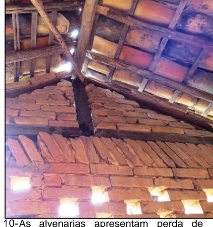
10-As alvenarias apresentam perda de material, material inadequado/argamassa de cimento, trincas devida a falta de manutenção. A madeira da estrutura apresenta ataque de xilófagos, podridão e ressecamento.
