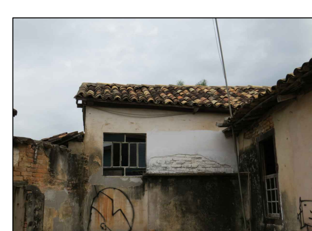
5-Presença de patina biológica, musgo, líquens mancha enegrecida, perda do reboco, vandalismo por pichação e trincas, devida à umidade constante no local.
