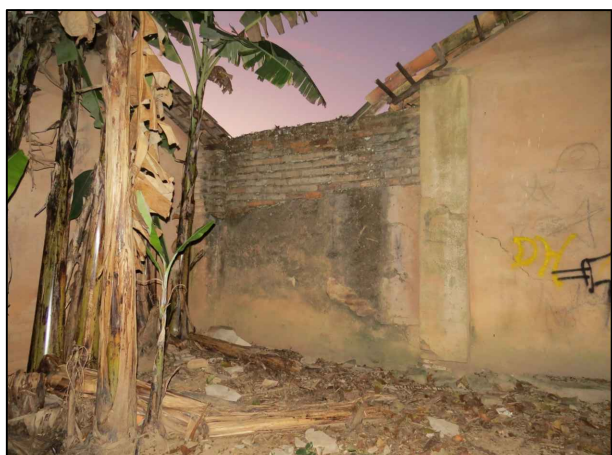
6- As paredes apresentam patina biológica e mancha enegrecida, vandalismo por pichação, intervenção inadequada, sujeidade impregnada, perda de reboco e trincas.
