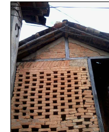
10-As alvenarias apresentam perda de material, material inadequado(argamassa de cimento), trincas devida a falta de manutenção. A madeira da estrutura apresenta ataque de xilófagos, podridão, ressecamento.
