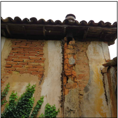
7-As paredes apresentam ataque botânico de pequeno e médio porte (trepadeira, hera), trincas, intervenção inadequada perda do reboco e sujidade impregnada, provocada pela ação do tempo, umidade constante e falta de manutenção.
