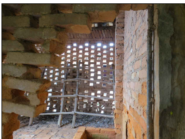
7- As alvenarias apresentam perda de material, material inadequado (argamassa de cimento), trincas e risco de desabamento devida a falta de manutenção.
