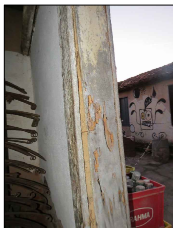
5- ataque de térmitas, ressecamento e apodrecimento da esquadrias.
