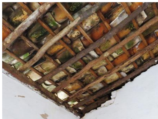
Figura 69: Engradamento do telhado— 2013 Foto: Tamara Pereira
