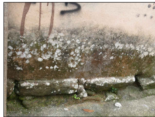
2-Presença de patina biológica, musgo, líquens mancha enegrecida, devida à umidade constante no local.
