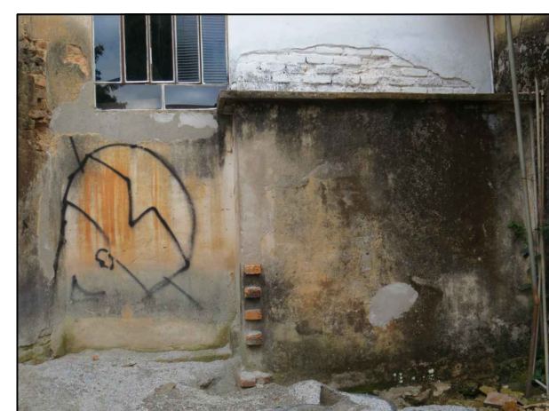
6-Presença de patina biológica, musgo, líquens mancha enegrecida, vandalismo por pichação, perda do reboco e trincas, devida à umidade constante no local.
